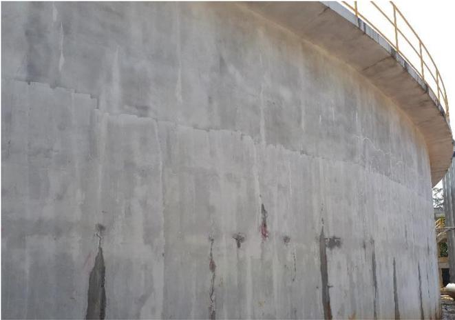
**FOTO 1** - Fissuras com vazamentos existentes
