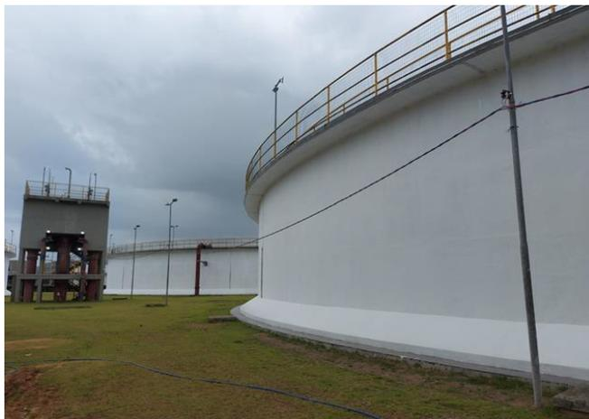
**FOTO 13** – Pintura e impermeabilização externa com **Fuseprotec Parede**
