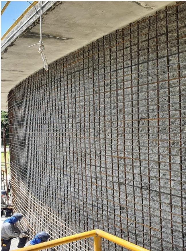
**FOTO 3** – Ancoragem da armadura na base do concreto com adesivo epóxi **Viapoxi Adesivo Gel**
