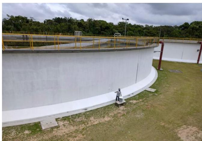
**FOTO 12** – Primeira demão da pintura e impermeabilização externa com **Fuseprotec Parede**
