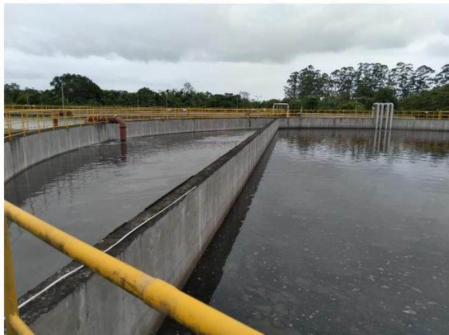
**FOTO 11** – Tanque em plena carga hidrostática com impermeabilizante cristalizante **Vandex Super**
