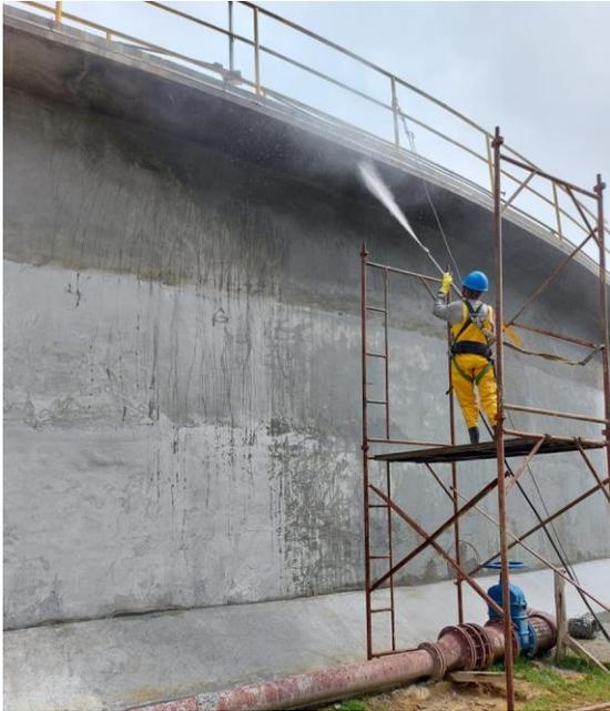
**FOTO 5** – Hidratação do concreto através de cura úmida e cura química com **Curacreto 309**
