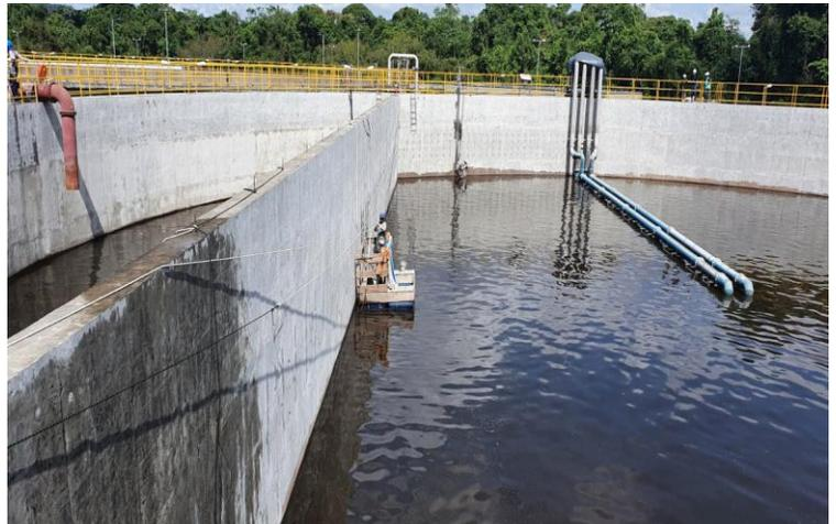
**FOTO 7** – Remoção da impermeabilização existente interno com tanque em operação, utilizando ferramenta mecânica
