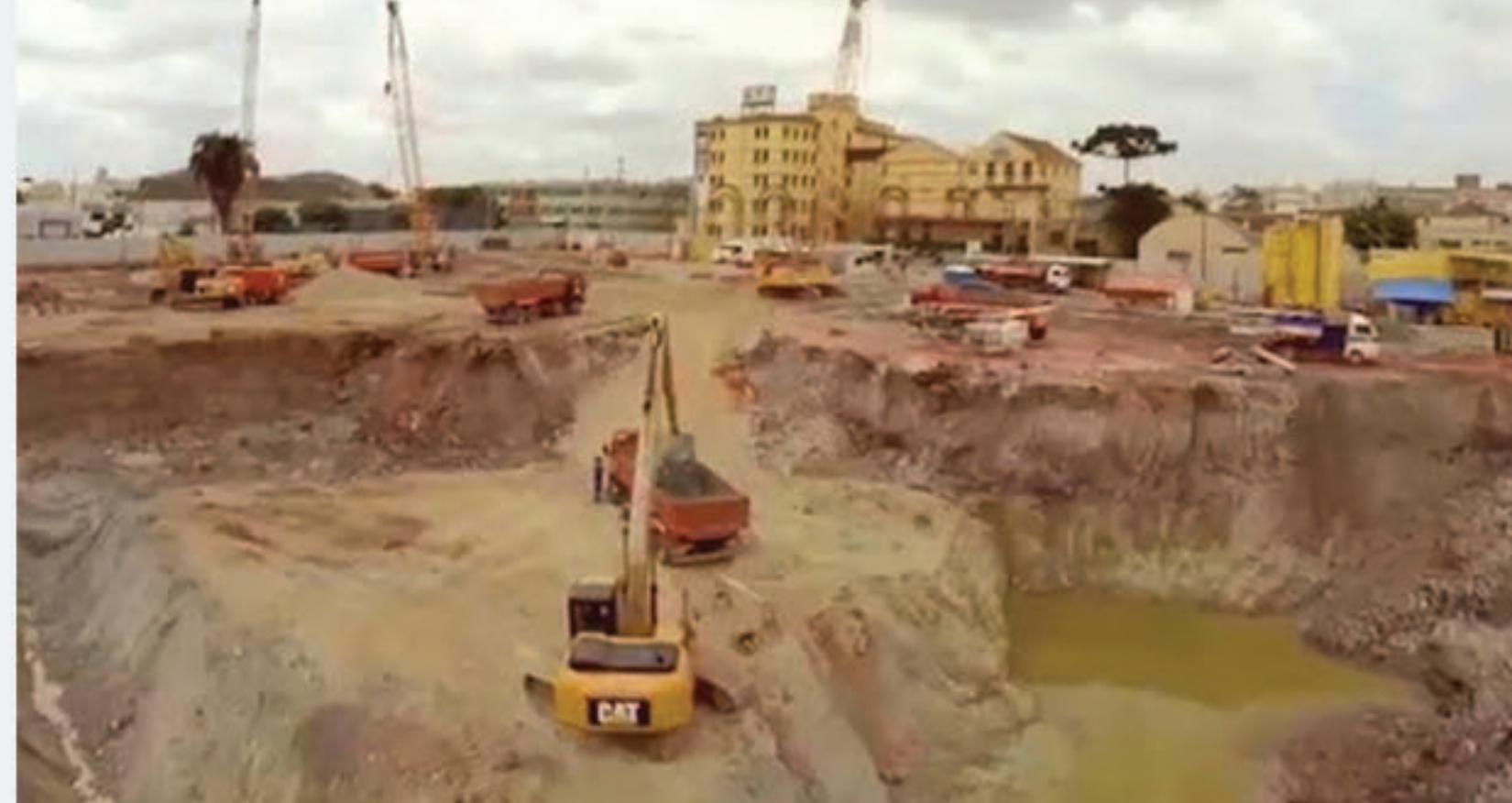
Figura 1 – Fotografia ilustrativa de obra - fonte Google
