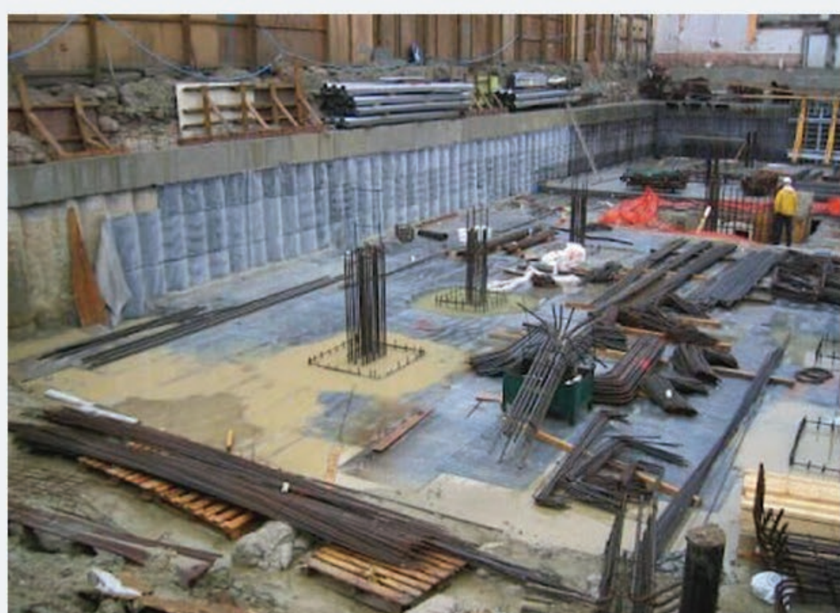
Figura 2 - Fotografia ilustrativa de obra - fonte Google
