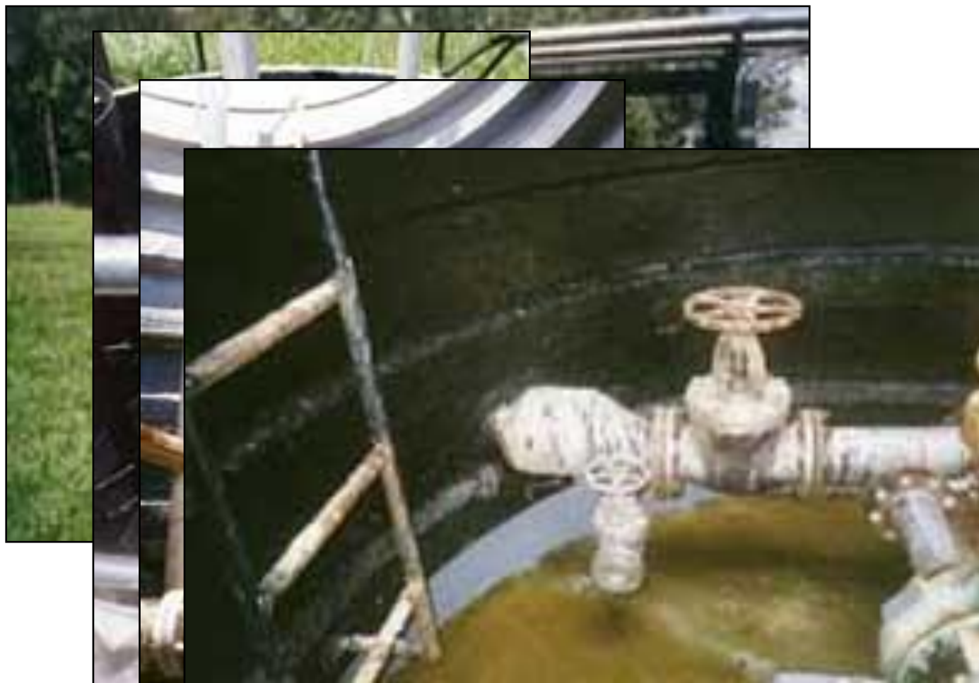
Vista do revestimento inferior
