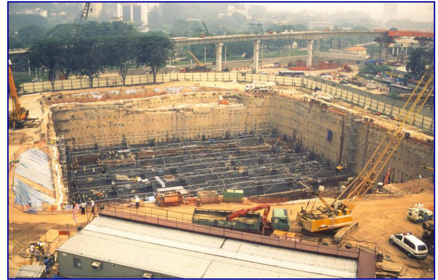
▲ Fundação (Maybank), Malásia
