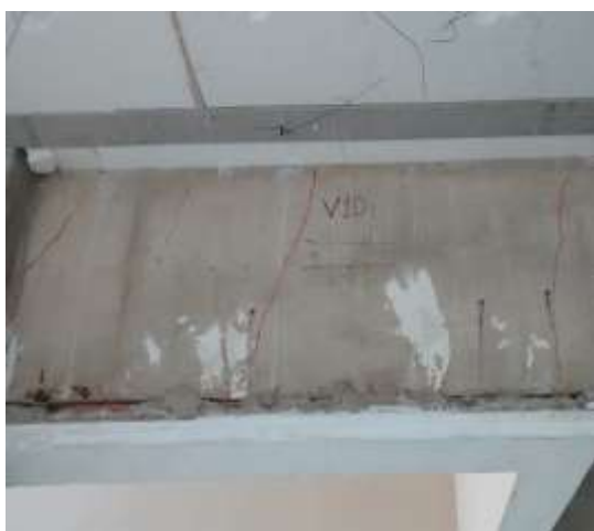
a) Fissuras de Flexão
