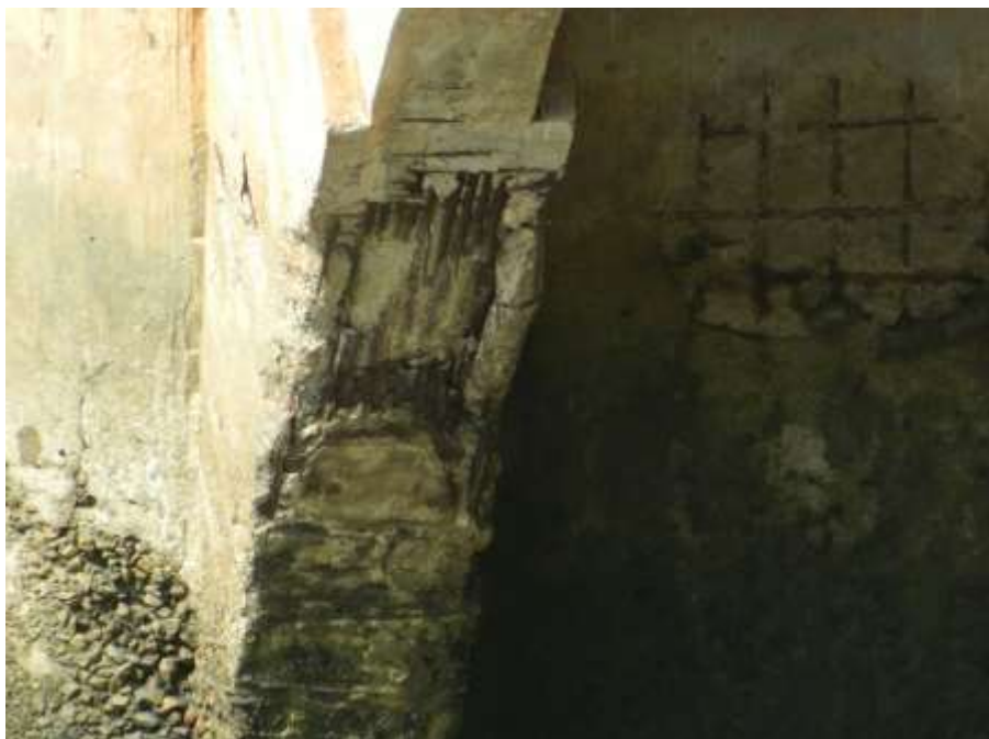
Figura 5: Ausência de armadura devido à corrosão e desgaste superficial devido à cavitação no pilar a esquerda.
