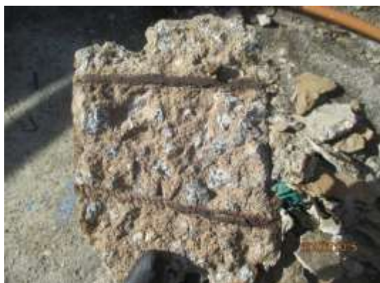
Figura 8: Deslocamento do concreto com ocorrência nas lajes de cobertura das células 2 e 1, devido ao processo de corrosão avançado das armaduras.
