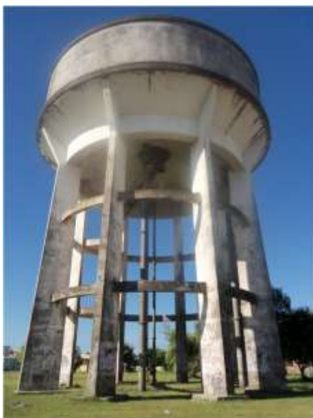
Figura 1: Reservatório R10 T (AUTORA)
