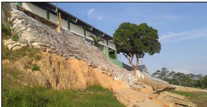
Figura 13: Reforço das fundações das infraestruturas portuárias e estabilização do talude. Fonte: DNIT (2014)
