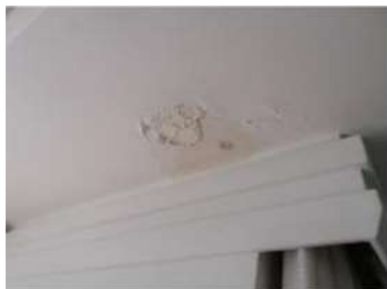
Figura 28: Infiltração no teto do último apartamento.
