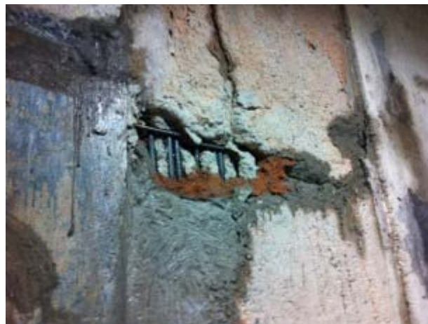
Figura 21 – Detalhe de concreto segregado na parede diafragma.
