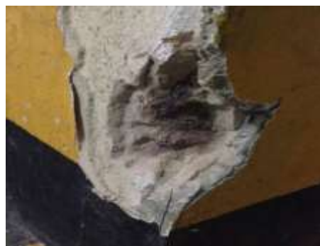
Figura 10 – Ensaio de profundidade de carbonatação no pilar de periferia
