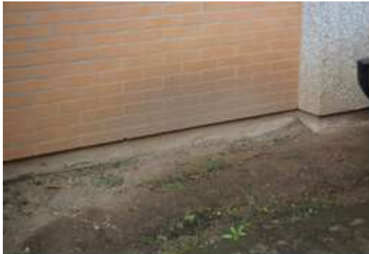
Figura 14: Manchamento por reflexão da chuva no solo
