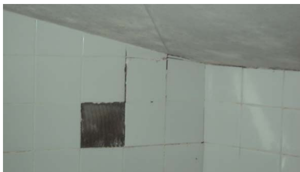
Figura 6. Descolamento da cerâmica
