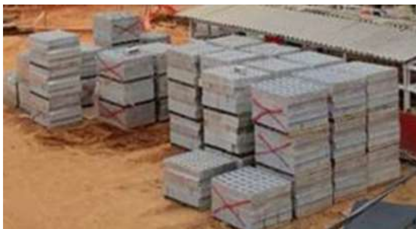
Figura 11– Armazenamento dos Blocos Obra B.
