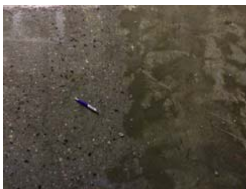
Figura 4 – Superfície de concreto após passagem do jato de alta pressão.
