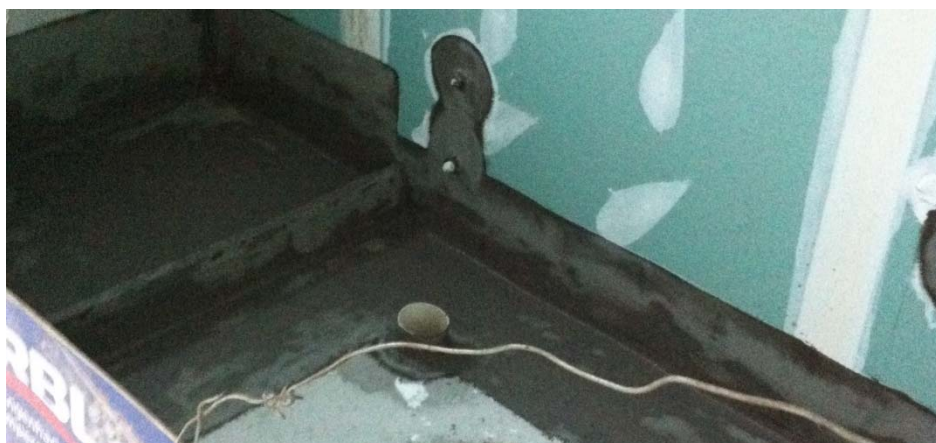
Figura 11 – Impermeabilização do banheiro
