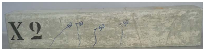
Figura 6 – Viga X2 pré-fissurada.
