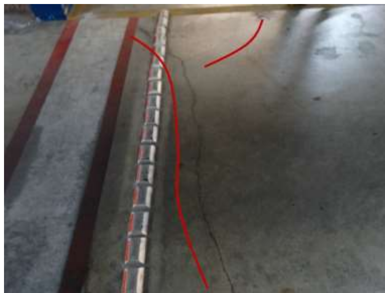
Figura 3 - Trincas e fissuras no piso da garagem.
