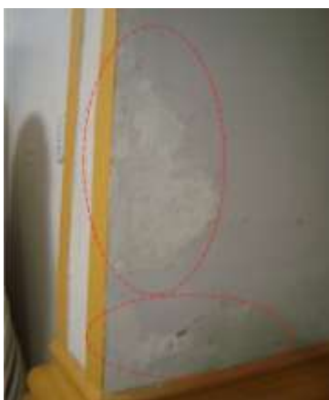
Figura 17: Área interna - Manifestações patológicas do revestimento.
