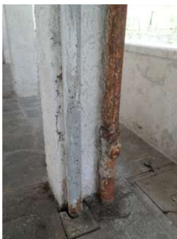
Figura 7: Corrosão na base do pilar. (Fonte: Prezi)
