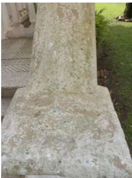
Figura 7: Descolamento de película de tinta no guarda-corpo da varanda
