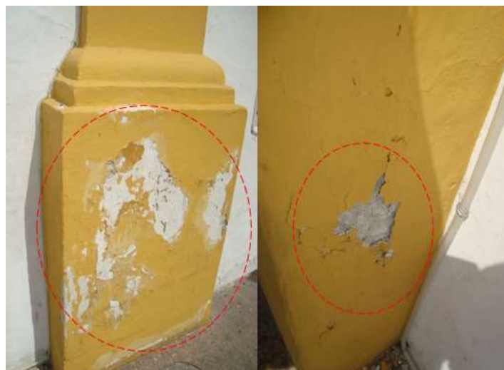
Figura 16: Fachada D - Manifestações patológicas do revestimento e outras.
