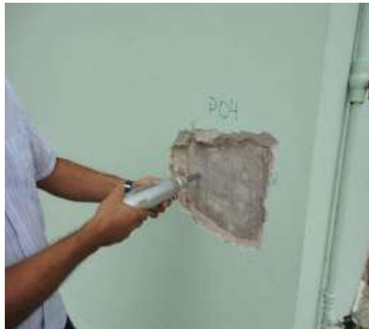
Figura 12: Realização dos ensaios de esclerometria
