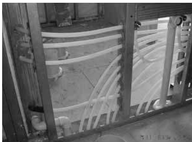
Figuras 8 e 9: Passagem de tubulação em montantes com proteção [19]
