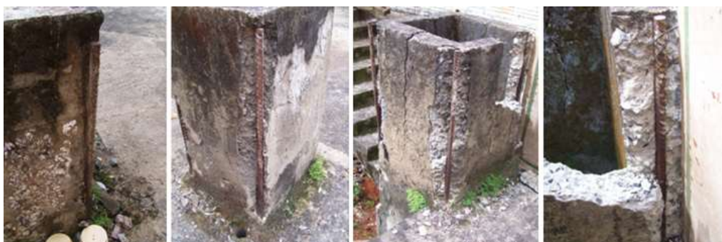
Figura 5: Armaduras expostas no térreo
