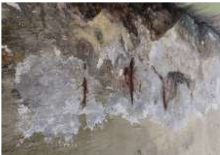
Figura 6: Corrosão da armadura de pilar
