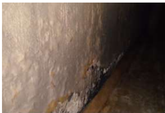
Figura 18: Destacamentos no concreto.
