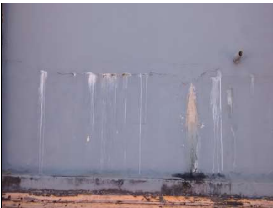
Figura 5: Eflorescência em junta de concretagem da parede do flocculador. (Fonte: Autor, 2015)
