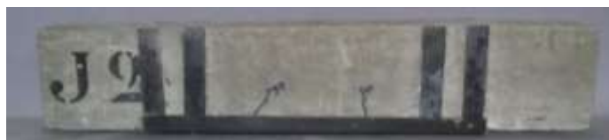
Figura 11: Viga J2 após Aplicação de Reforço
