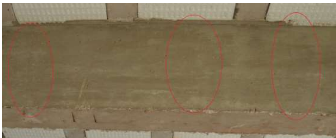
Figura 15 – Fissuras em vigas do anexo A
