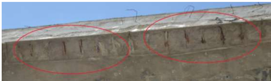
Figura 11 - Trechos em que a viga do anexo A está com a armadura exposta por falta de cobrimento.
