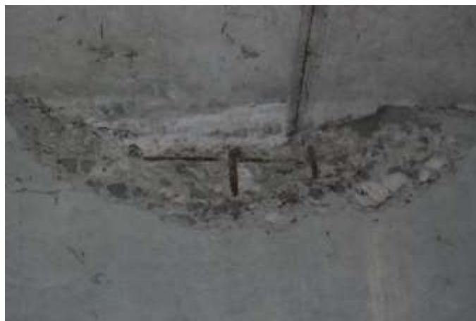
Figura 5: Esmagamento da viga
