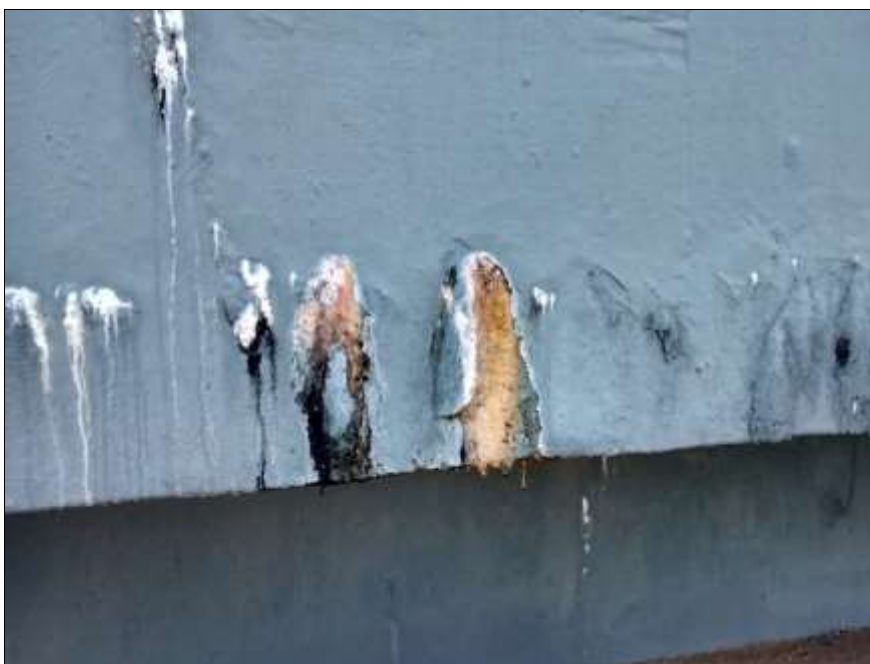
Figura 7: Eflorescências e manchas de bolor em parede da câmara de decantação. . (Fonte: Autor, 2015)
