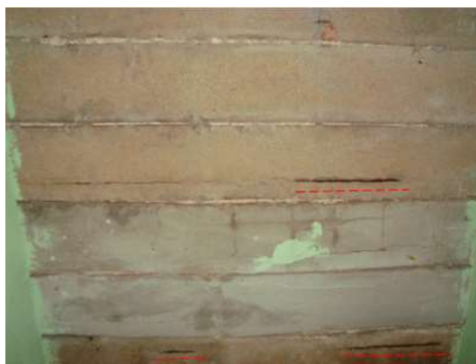
Figura 12: Área interna - Corrosão nas armaduras da laje.
