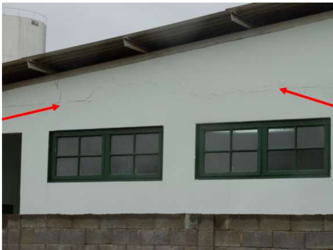
Figura 7: Trinca horizontal ao longo da viga de cobertura (parte externa)
