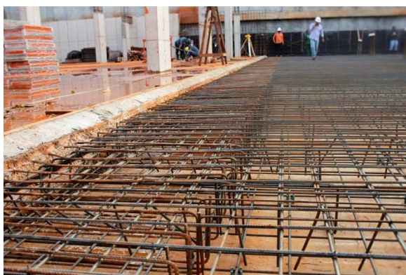
a) Detalhe do concreto magro executado.
