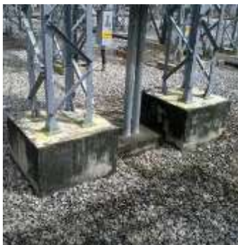
Figura - 2 Bases de concreto com pontos de eflorescência
