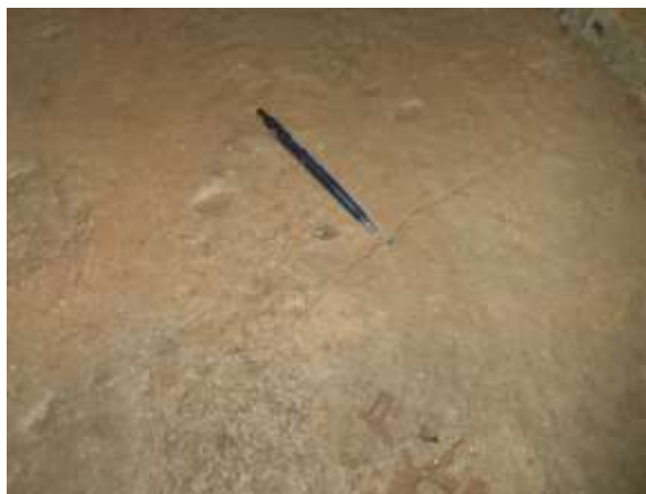
Figura 1: Fissuras características de expansão de grau 1 – F.EXP - G1
