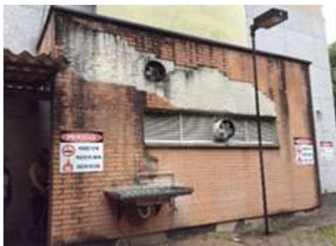
Figura 12: Descolamento e manchamento na fachada Noroeste
