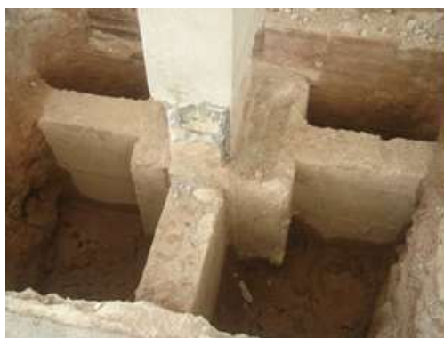
Figura 5: corrosão no pé do pilar devido a atmosfera marinha. (Fonte: Ricardo Dolabella)
