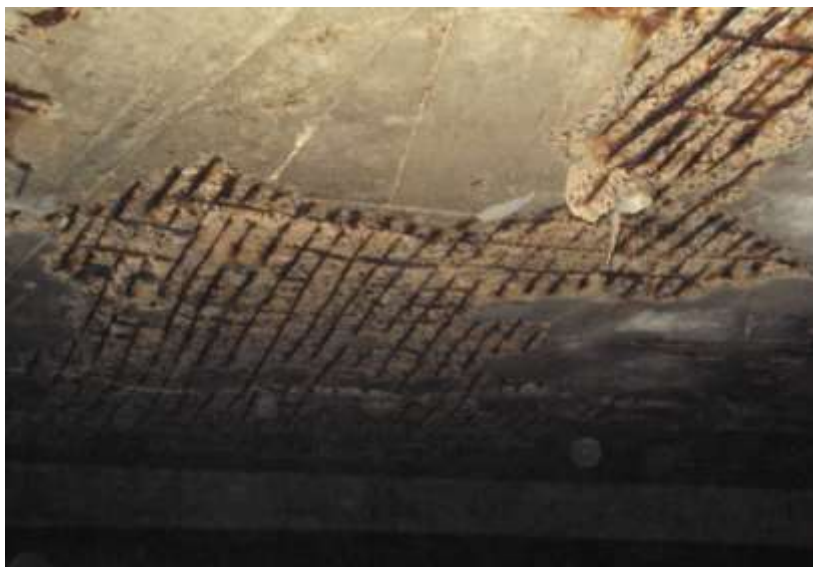
Figura 5 - Deslocamento da camada de cobrimento e corrosão de armaduras no interior da laje de cobertura do REL do SAA da cidade de Carpina denominado R-2.
