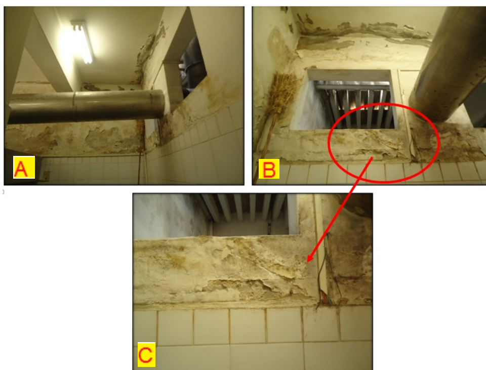
Figura 11: Antiga copa do edifício.
