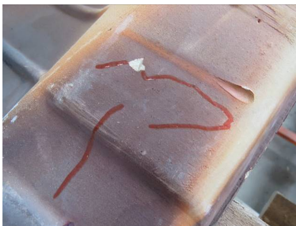
Figura 7 – Fissuras destacadas em vermelho no ponto 5 com energia de 1,5J
