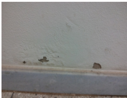
• Figura 2. Bolhas e descolamento da pintura
