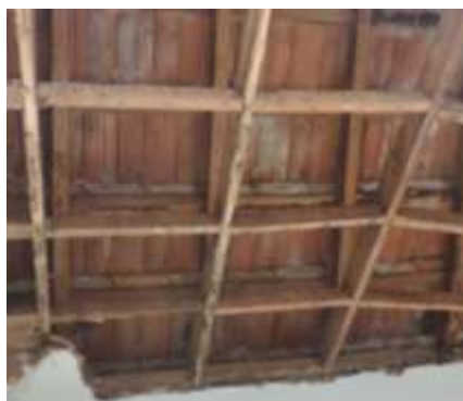
Figura 5: Vista inferior do entramado de madeira para suporte do forro depois da retirada da tela e da argamassa.
