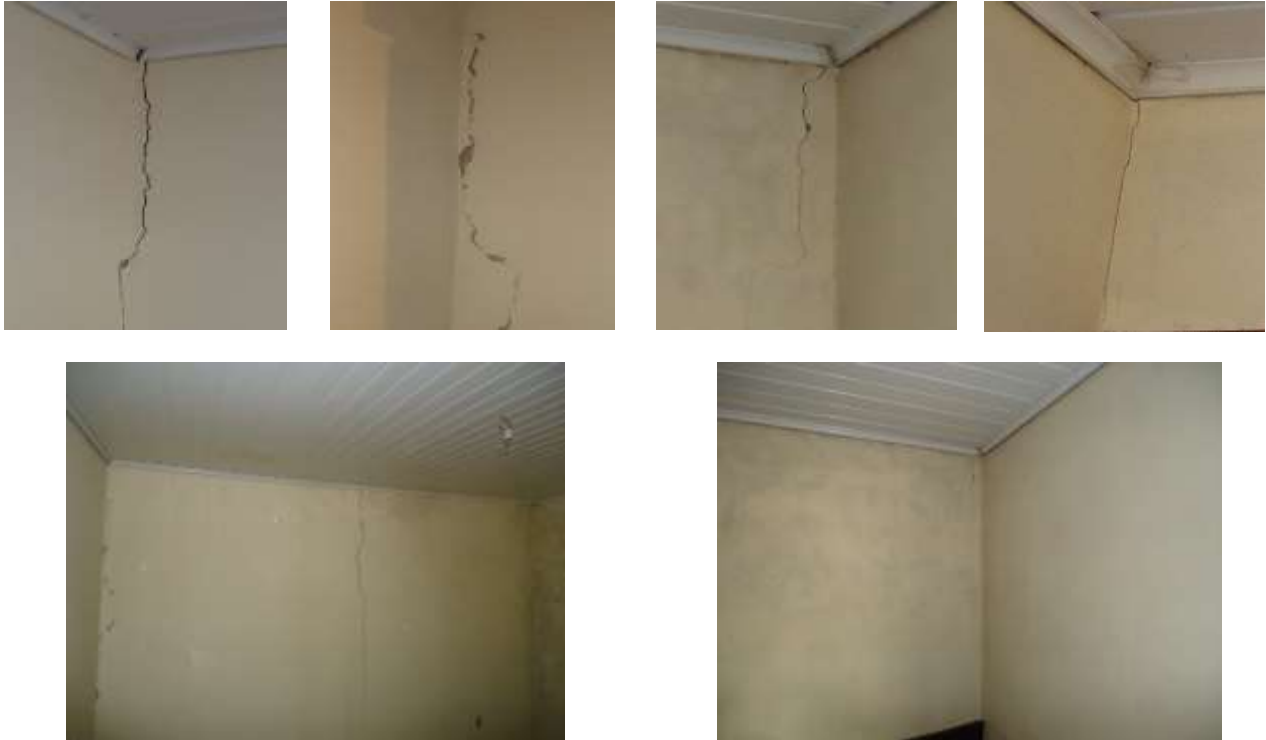
Figura 6 – Manifestações patológicas encontradas na ampliação do dormitório
