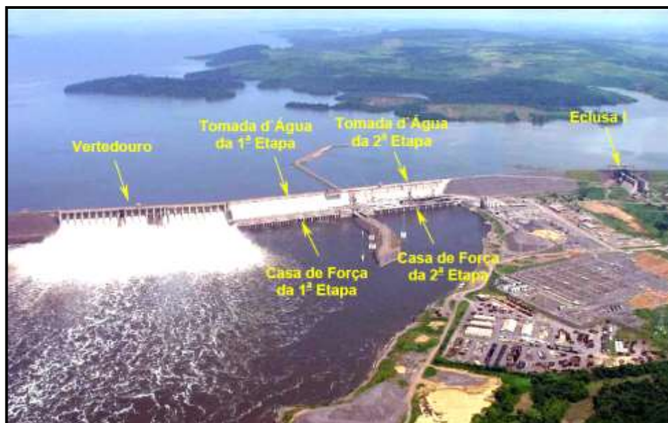
Figura 1: Vista aérea do barramento do rio Tocantins, destacando as principais estruturas de concreto que o compõe [1]
