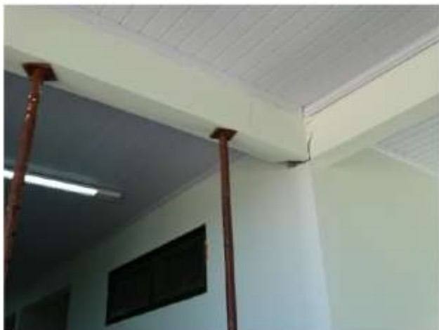
Figura 2a: Viga VC 02 escorada
