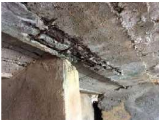
Figura 3: Ausência de recobrimento em armadura exposta apresentando corrosão [12]
