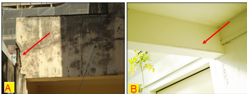
Figura 13: Disgregação do concreto na fachada e em uma viga do edifício.
