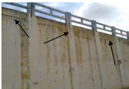
Figura 2: Fissuras nas estruturas de apoio
