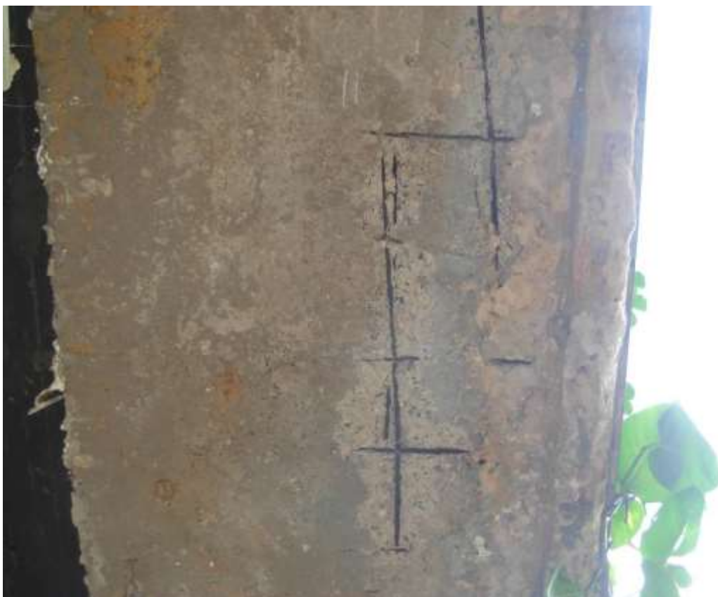
Figura 4: Cobrimento Insuficiente das Barras de Aço
