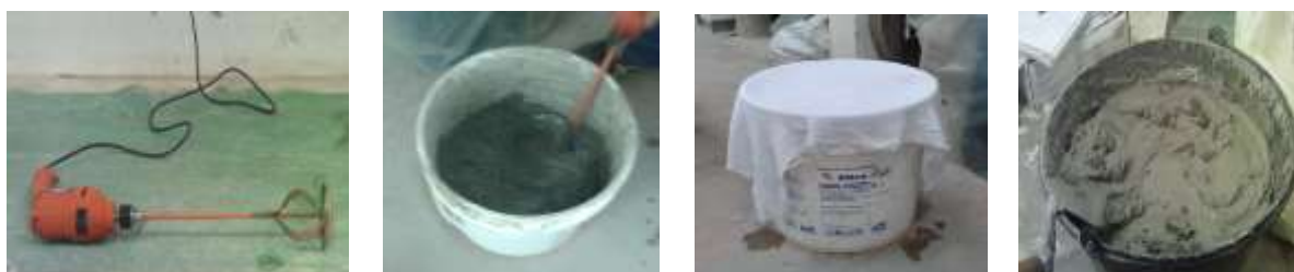
Figura 27: Misturador e etapas do processo de preparação das argamassas colantes.
