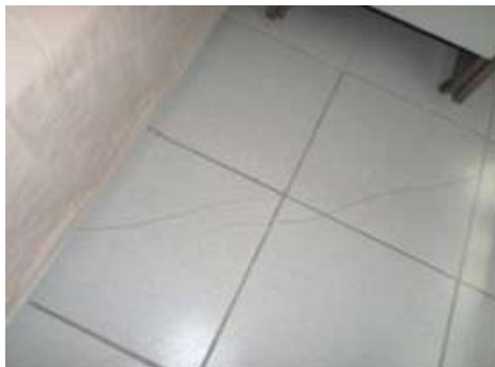
Figura 26: Fissura no piso do quarto.
