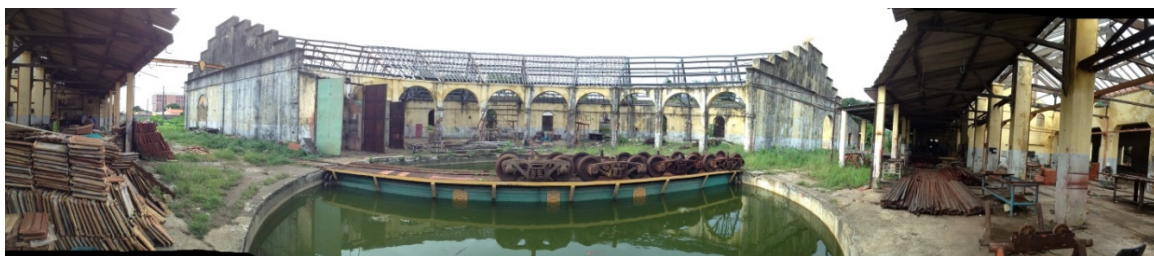
Figura 15: Vista da fachada principal (Fonte: acervo MULTITECH, 2012).
