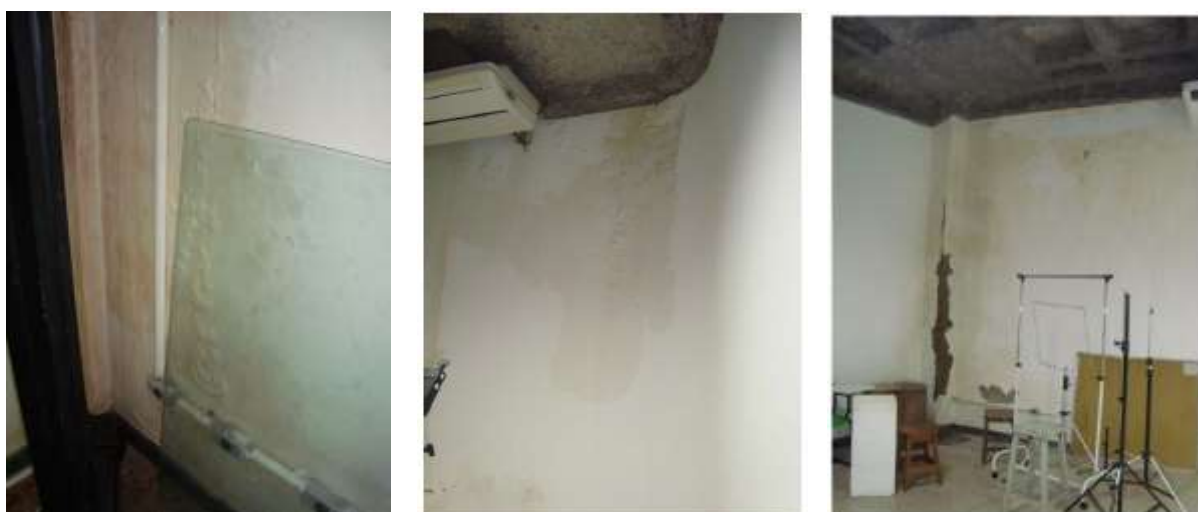
Figura 4: (a) Manchamento, vesículas e deslocamento de revestimento - sala 101, (b) Manchamento e vesículas - sala 101, (c) Manchamento e deslocamento de revestimento - sala 102.
