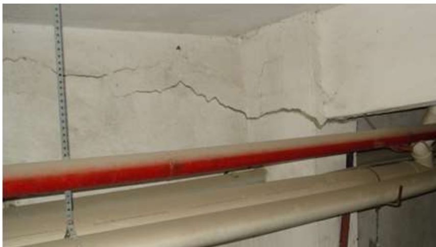
Figura 13: Fissura causada devido ao recalque diferencial
