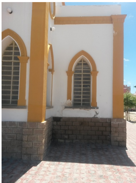
Figura 08: Revestimento em pedra na igreja de Angicos/RN a uma altura de cerca de 1,20 m
