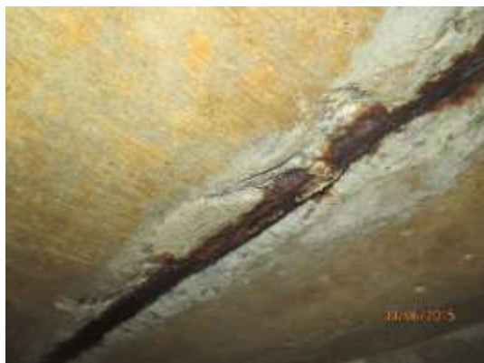
Figura 6: Laje de cobertura da célula 3 apresentando pontos aleatórios com armaduras expostas e em processo avançado de corrosão. Em alguns pontos observam-se resquícios de reparos anteriores, sem efetividade.
