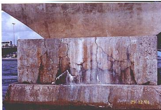
Figura 2: Bloco de apoio de vão central com ocorrência de patologia [20].
