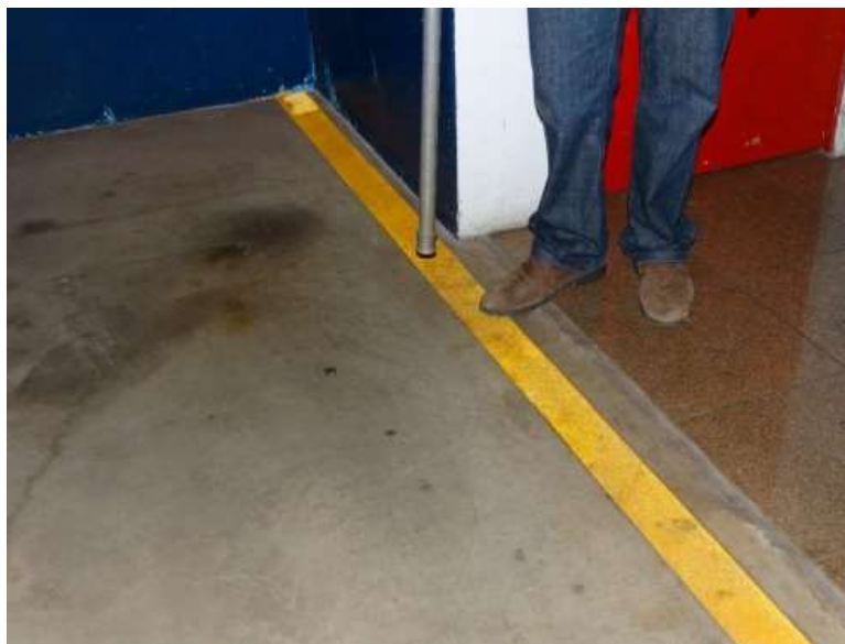
Figura 8 - Realização do ensaio de percussão.
