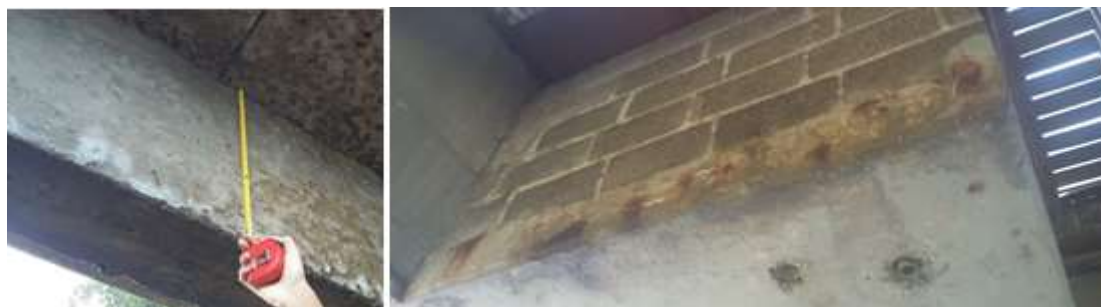
Figura 5- Carbonatação do concreto no Píer A (esquerda) e Píer D (direita).
