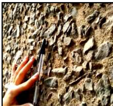
Figura 4: Foto ilustrando o desgaste superficial do paramento de montante da Eclusa 1
