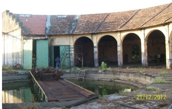
Figura 17: Vista geral: Trecho coberto (Acervo: Multitech, 2012).
