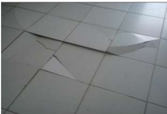
Figura 7 – Elevação de pisos.
