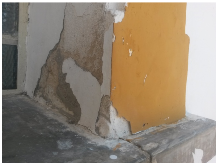
Figura 04: Destacamento da pintura na igreja de Angicos/RN Fonte: Acervo dos autores
