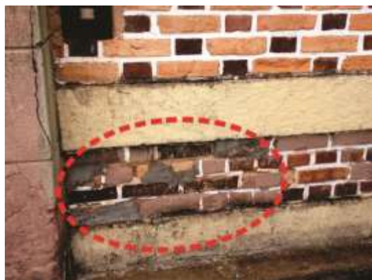
Figura 52: Vista da fachada leste, com preenchimento dos tijolos em cimento. Fonte: (PEREIRA, 2015, p.65)
