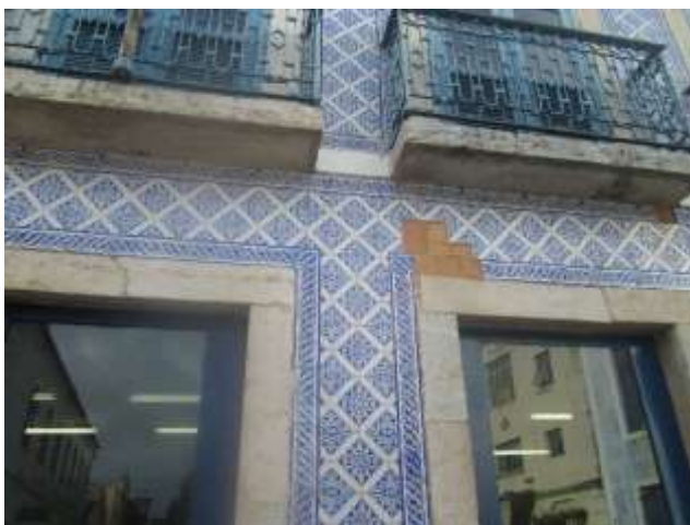
Figuras 36 e 37: Manifestações patológicas no revestimento em azulejo da fachada
