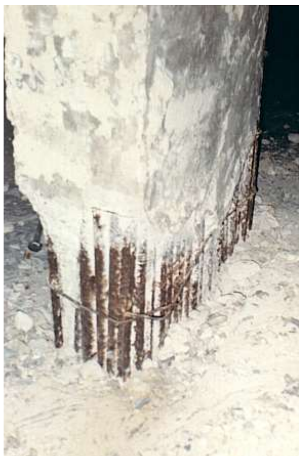
Figura 3: Alta densidade de armadura como causa da corrosão das armaduras em base de pilar
