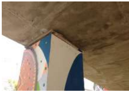
Figura 11: Reforço indevido no sistema de apoio
