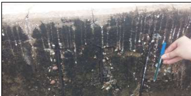
Figura 11: Exposição e corrosão de armaduras
