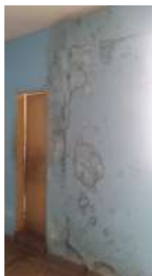
Figura 6- Umidade em área molhada – Banheiro (W.C)
