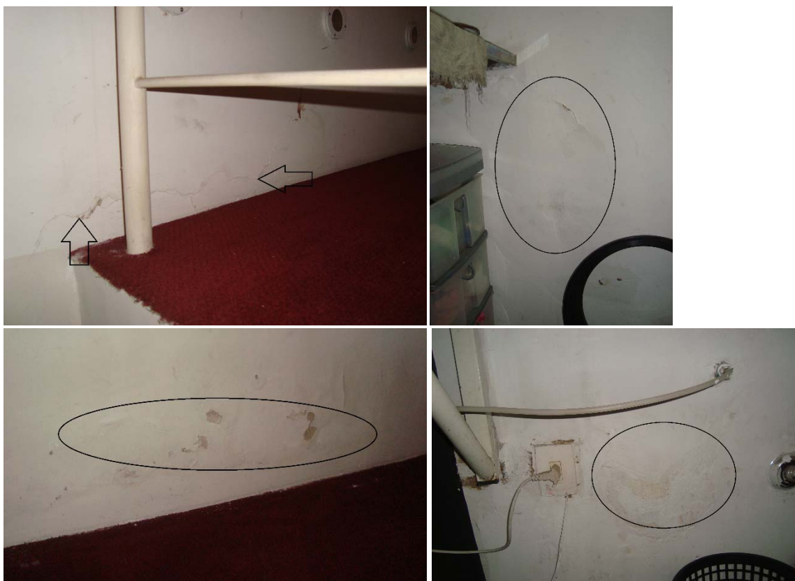
Figura 8: Estado de conservação do pavimento térreo
