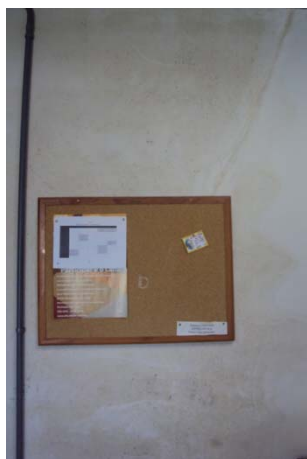
Figura 6. Manchas na parede
