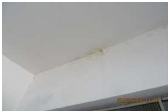
Figura 3: Infiltrações na laje do estacionamento.
