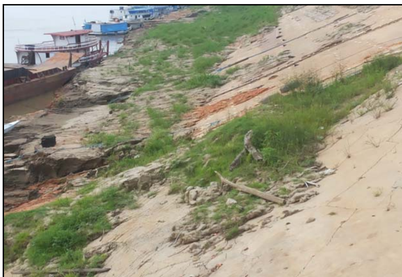
Figura 1: Vista da ocorrência do fenômeno de terra caídas à esquerda e de fissuras na estrutura. Fonte: DNIT (2014)
