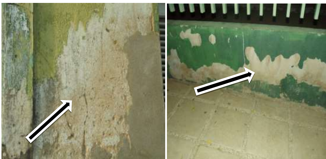
Figura 15: Desagregação de revestimento – Perda de aderência Fonte: Acervo pessoal (2014).
