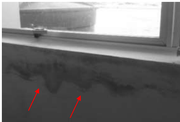
Figura 10: Caso de infiltração na interface do peitoril
