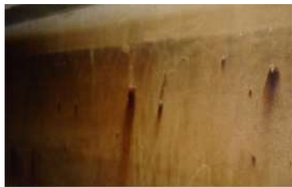
Figura 9: Pontos de corrosão nas paredes do reservatório inferior.
