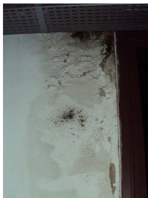
Figura 7. Danos na parede do corredor
