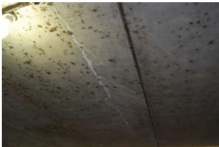
Figura 7: Laje fissurada e com eflorescência no sentido longitudinal
