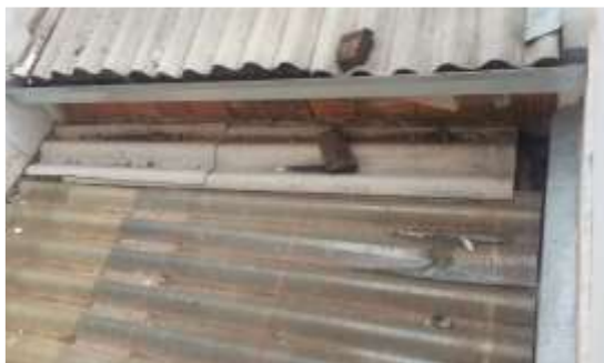
Figura 7- Cobertura (telhas de fibrocimento) e sistema de calhas
