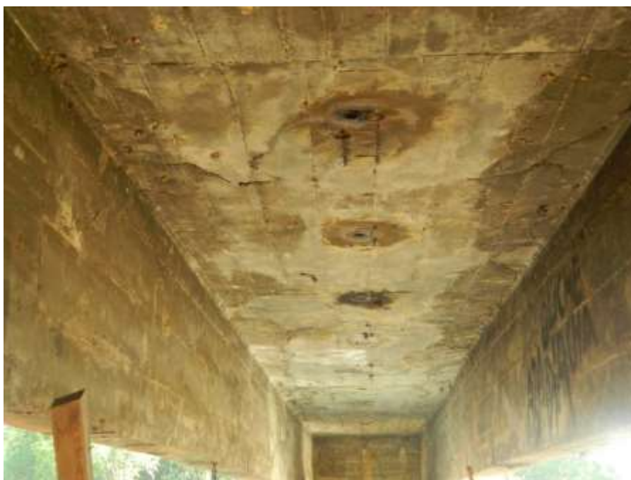
Figura 7: Vista inferior do tabuleiro mostra sinais de oxidação de armaduras e de infiltração.
