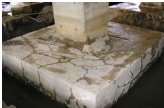
Figura 3: Fissuração devido a reação álcali-agregado.
