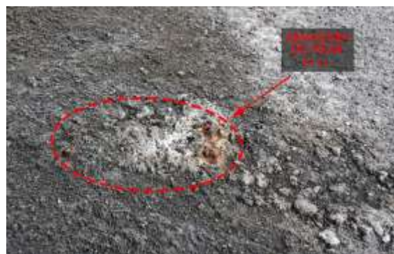
Figura 74: Armadura do Pilar P111 na laje do 1º pavimento
