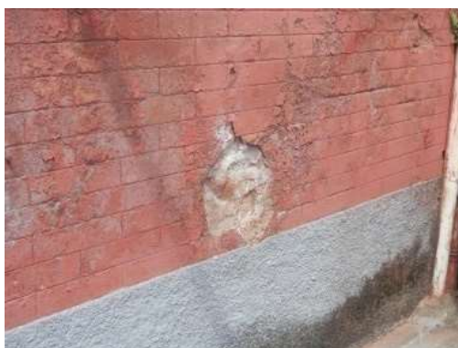
Figura 3: Manifestações patológicas decorrente de umidade. (Fonte: autores)
