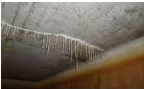
Figura 10: Pontos de estalactites na laje do reservatório.
