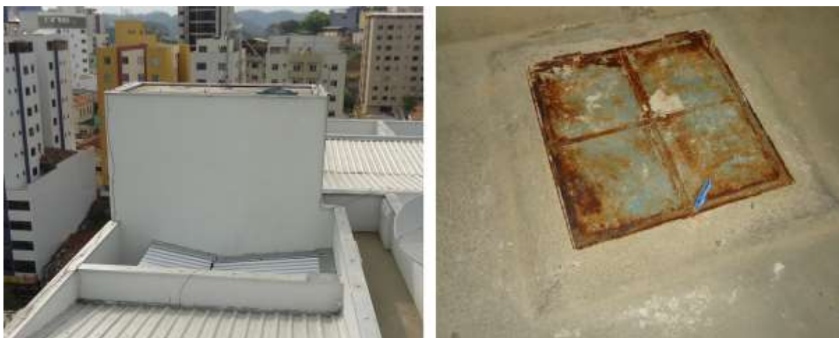
Figura 4. Reservatórios da Edificação A.
