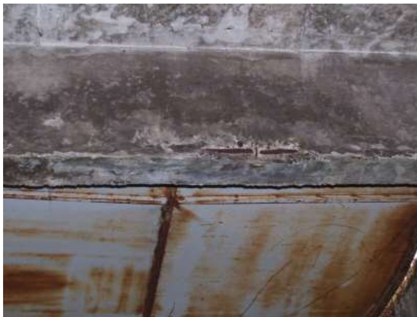
Figura 4: Armadura exposta na viga
