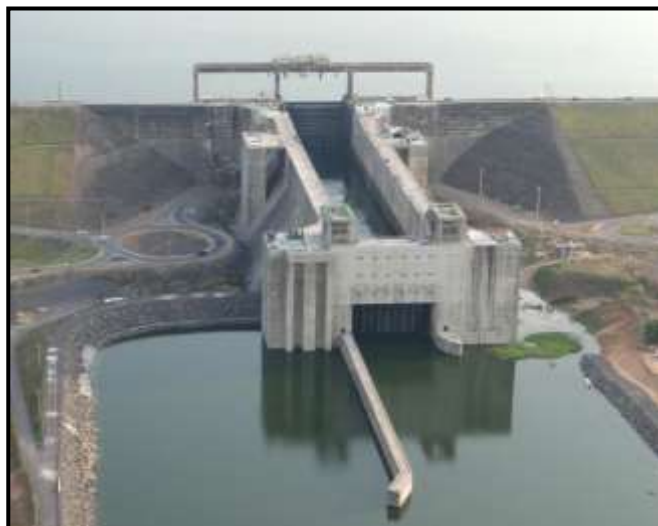
Figura 2: Eclusa 1 do Sistema de Transposição de Desnível de Tucuruí, observada de jusante para montante
