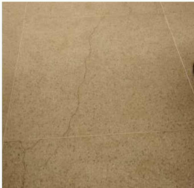
Figura 8: Fissuras no piso de granilite. Fonte: Acervo pessoal (2015)
