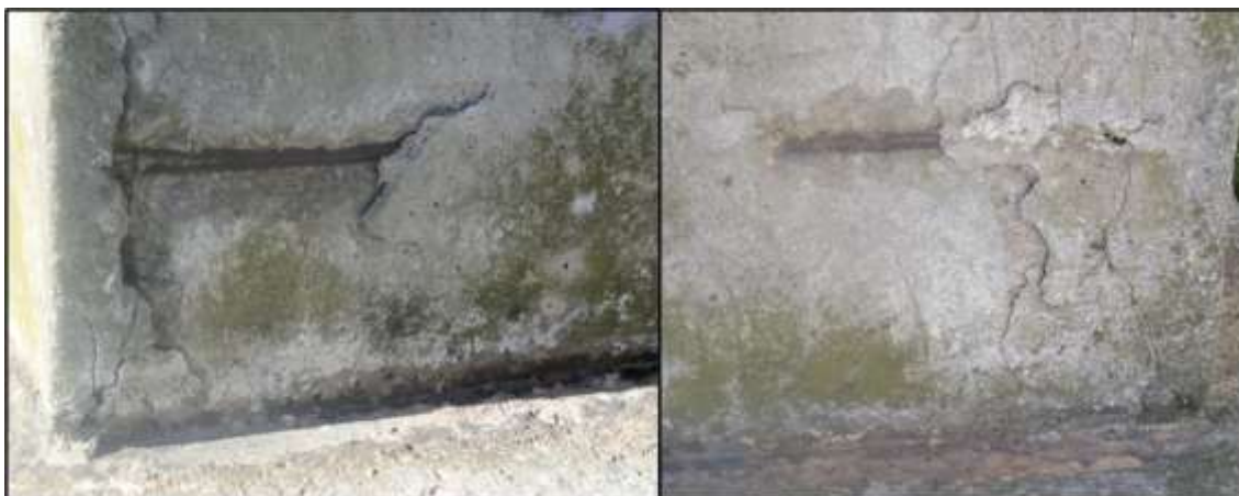
Figura 6: Manifestações patológicas nas bases dos pilares (AUTORA)
