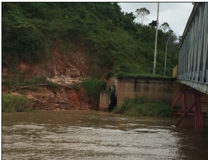
Figura 9: Necessidade de prolongação do muro de arrimo para evitar desabamento. Fonte: DNIT (2015)
