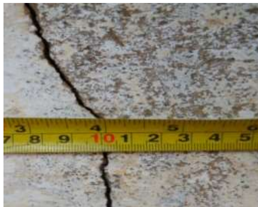
Figura 7: Trincas nas paredes na escola 3.
