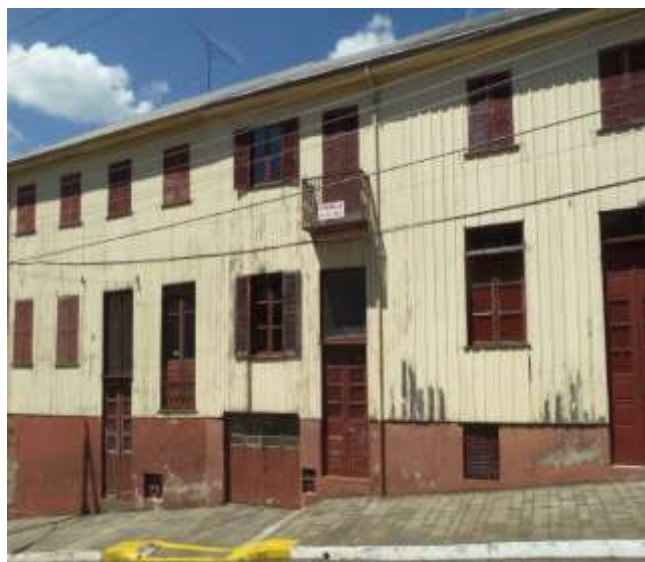
Figura 02: Fachada com ângulo da Casa Marcantônio, Camilo, sem reforma recente.
