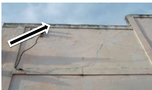
Figura 12: Mofo em parede externa da residência
