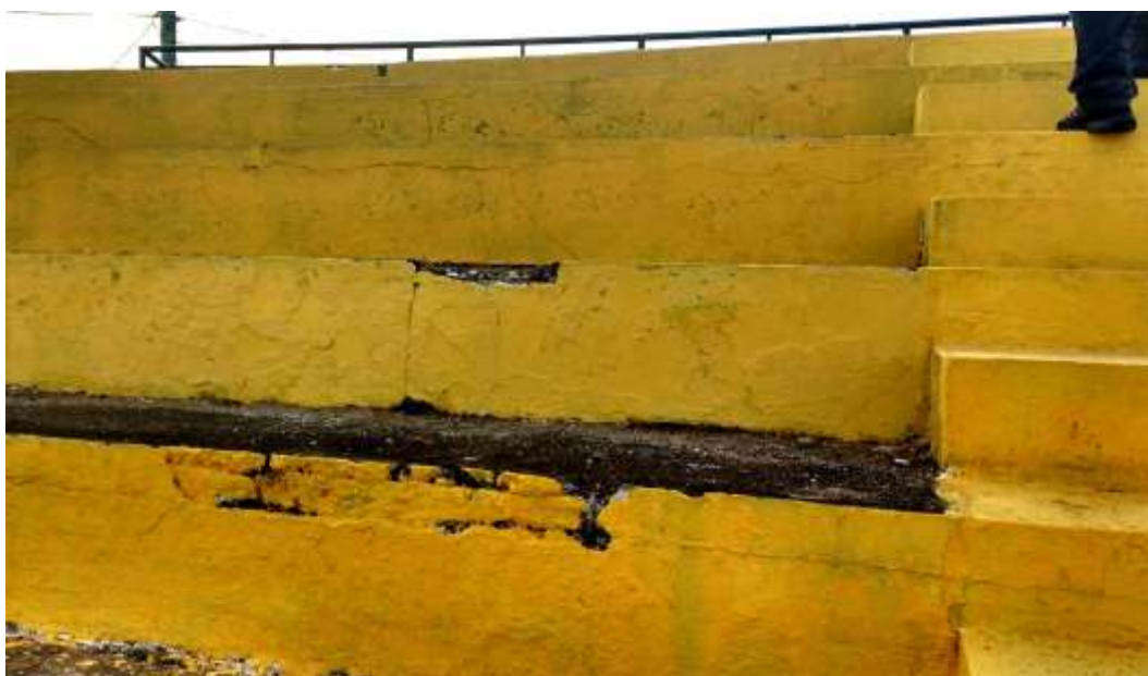
Figura 9: Fissuras nos degraus da arquibancada do estádio
