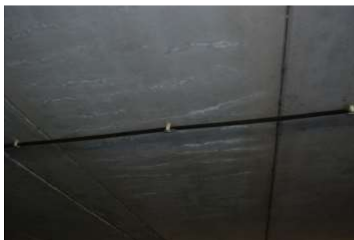
Figura 8: Laje fissurada e com eflorescência no sentido transversal
