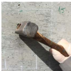
Figura 9: Utilização da picareta para remoção do revestimento.
