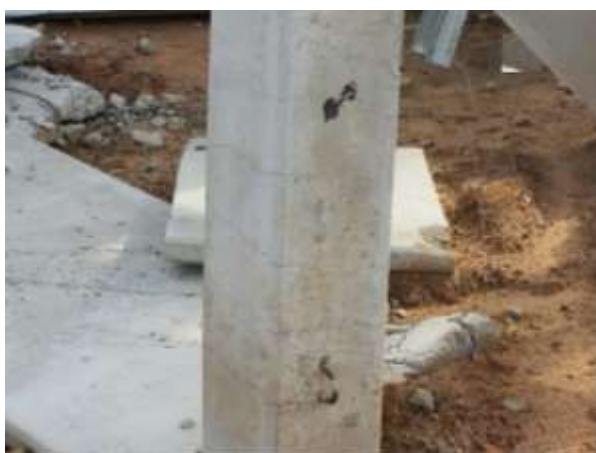
Figura 23: Pilar deformado e com fissuras com abertura acima da máxima permitida.
