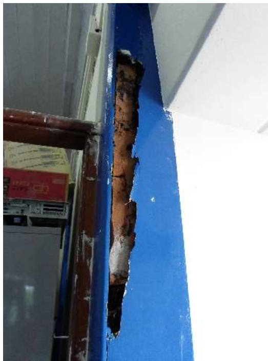
Figura 39: Esquadrias deterioradas
