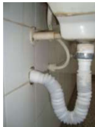
Figura 6: Vazamento em pia de banheiro masculino no AT5
