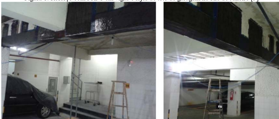
Figura 1: Reforço com PRFC em vigas e lajes de teto de garagem no Rio de Janeiro [9]
