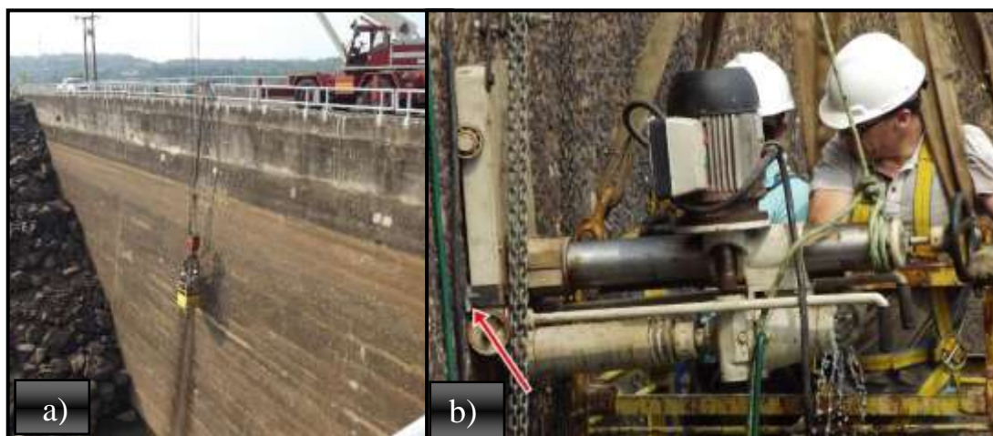
Figura 6: a) Gaiola sustentada pelo guindaste durante o posicionamento e manipulação da extratora; b) Extração de testemunhos do paramento, destacando a fixação da extratora
