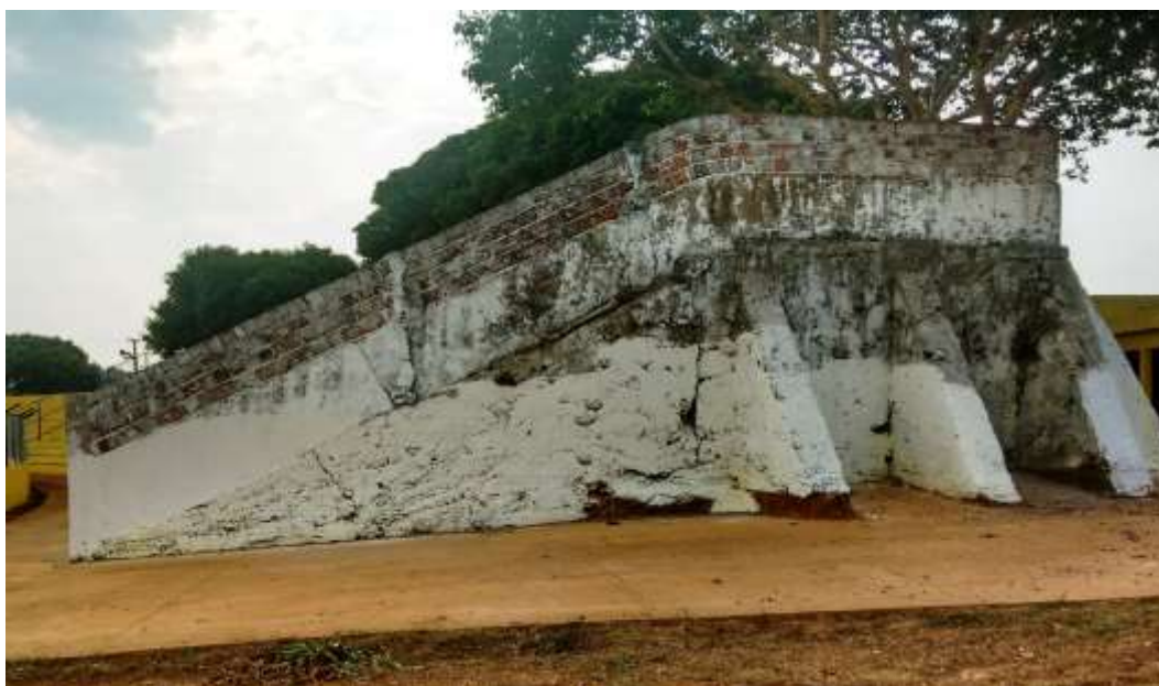
Figura 7: Acabamento externo em concreto da arquibancada
