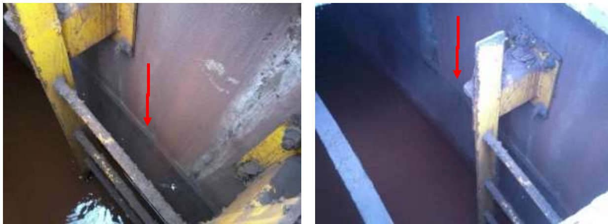
Figura 8: Término da impermeabilização interna aproximadamente 60 cm abaixo do topo da estrutura. Observa-se ainda a coloração da água
