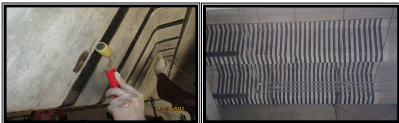
Figura 13 – Camada de saturação de resina epóxi sobre a manta de fibra de carbono.
