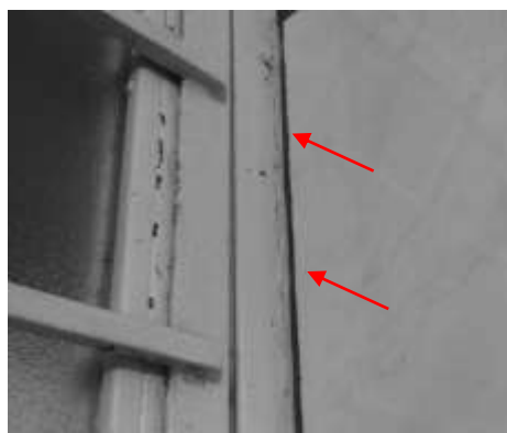
Figura 8: Caso de fissura na interface
