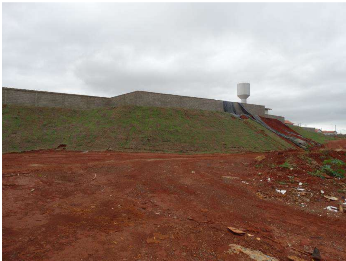
Figura 8a: Vista da altura do aterro onde a edificação foi construída
