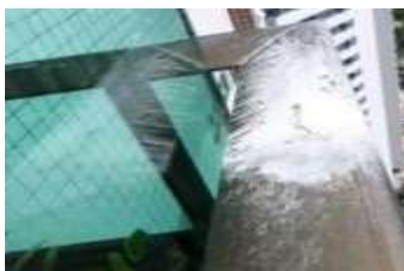
Figura 23: Esquadria manchada pela eflorescência.
