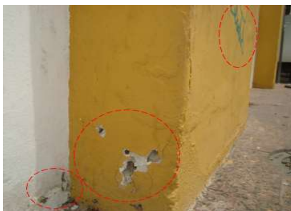
Figura 13 : Fachada A - Manifestações patológicas do revestimento e outras.
