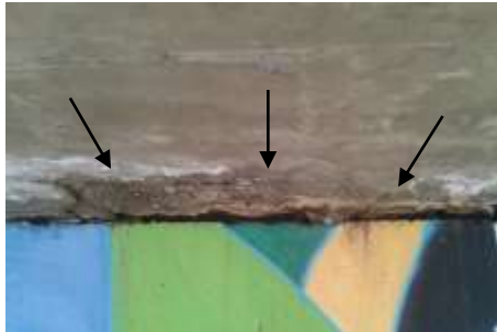
Figura 5: Laje do tabuleiro após o teste de carbonatação
