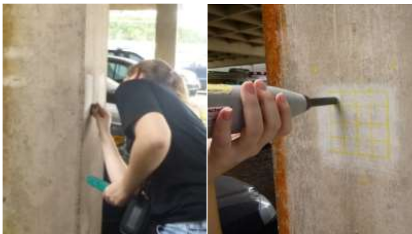
Figura 4: Execução do ensaio de esclerometria
