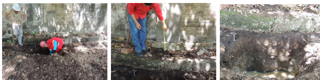
Figura 5: Detalhe da prospecção das fundações existente fachada posterior - rotunda (Acervo: Multitech, 2013)
