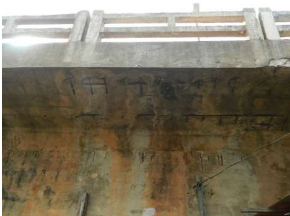
Figura 6: Exposição e corrosão da armadura inferior do tabuleiro rodoviário.
