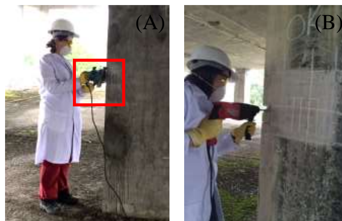
Figura 1: Corte de um pilar com a serra (A) e o martetele (B)
