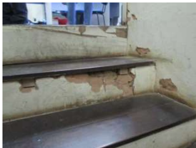
Figuras 42 e 43: Estrutura da escada de madeira deteriorada.
