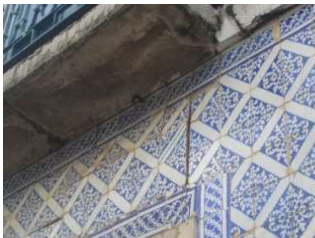
Figuras 36 e 37: Manifestações patológicas no revestimento em azulejo da fachada
