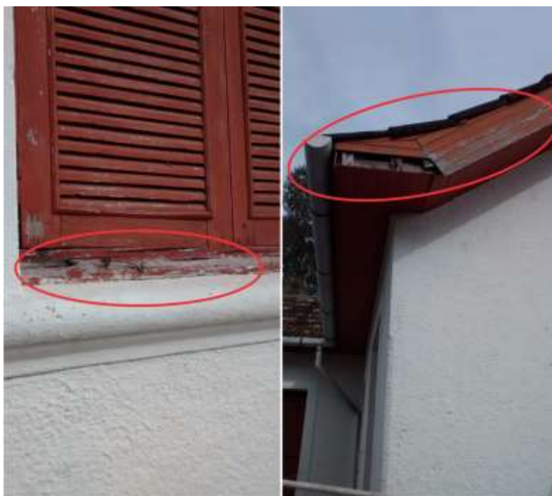
Figura 4: Deterioração de elementos de madeira das esquadrias e beirais
