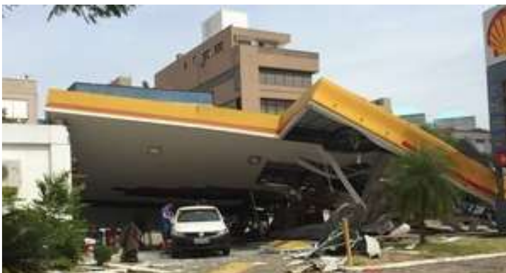
Figura 02: Posto de gasolina destruído no Bairro Praia de Belas (Foto: Diego Guichard /G1)
