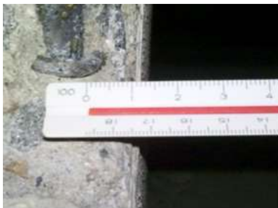
Figura 14: Cobrimento inadequado
