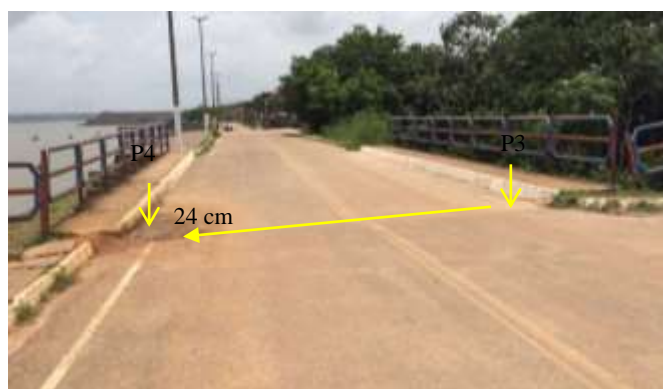
Figura 7. Localização dos Pontos: P3 e P4 no tabuleiro da ponte.
