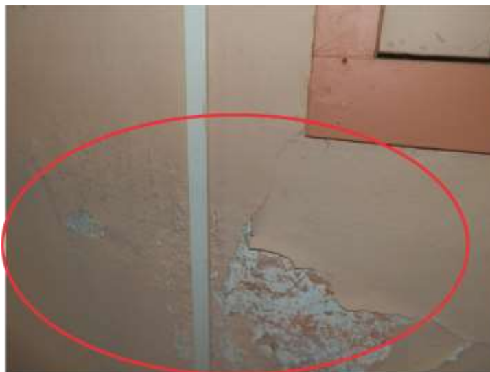
Figura 12: Descolamento de película de tinta por infiltrações nas janelas
