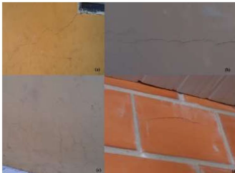
Figura 2: Ocorrência de fissuras: (a) Fissura em parede externa próxima a esquadria (b) Fissura horizontal em parede externa (c) Fissuras mapeadas em parede externa próxima ao rodapé (d) Fissuras em bloco, internamente Fonte: Acervo fotográfico dos autores (2012)
