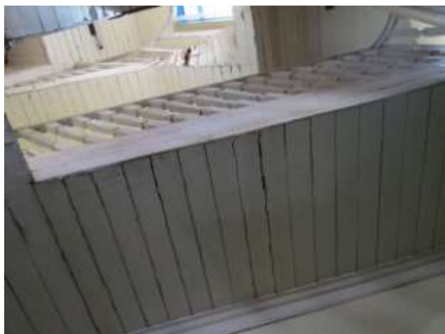
Figuras 42 e 43: Estrutura da escada de madeira deteriorada.
