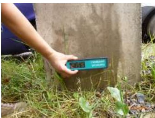
Figura 6: Medição da resistividade do concreto
