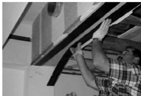
Figura A08: Reforço de viga. Fonte: Machado e Machado [1].
