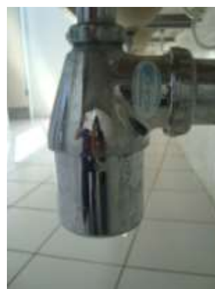
Figura 11: Vazamento de água pelo sifão da pia
