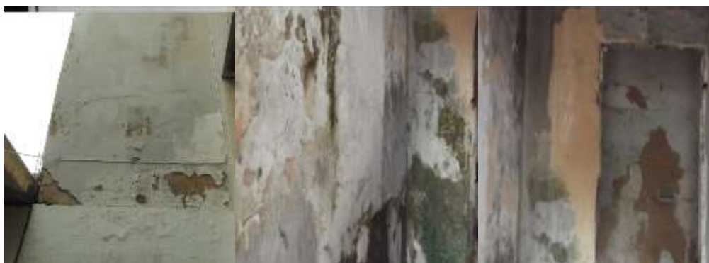
Figura 9: Pulverulência Fonte: Acervo pessoal (2015).
