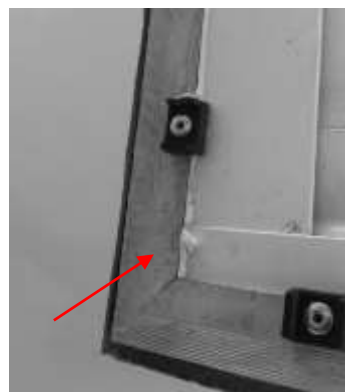
Figura 25: Vedação no perímetro entre contramarco e janela
