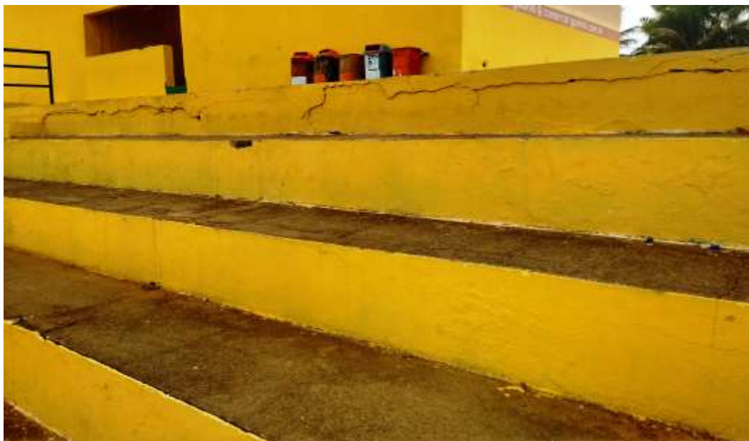
Figura 10: Fissuras nos degraus da arquibancada do estádio
