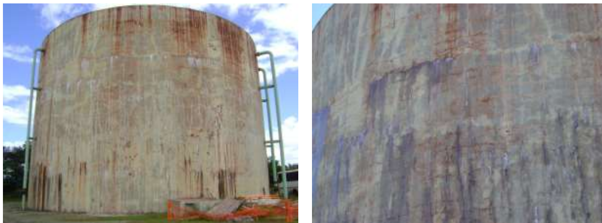
Figura 3: Vista geral (a) e vista parcial (b) do reservatório – 2009
