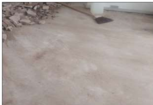
Figura 8 – Laje sem revestimento cerâmico.
