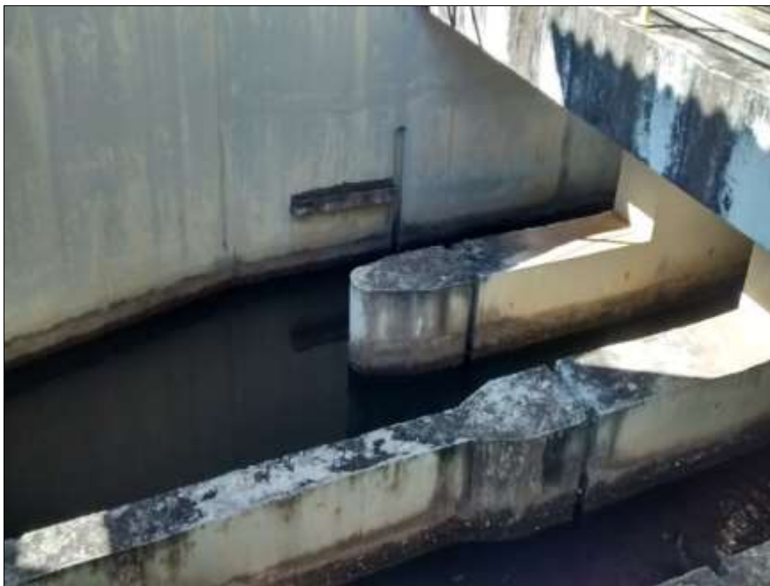
Figura 1: Superfície de concreto do sistema de captação com manchas de mofo e bolor. (Fonte: Autor, 2015)
