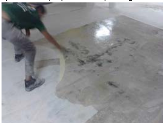
Figura 13 – Aplicação de argamassa de impermeabilização por cristalização integral.
