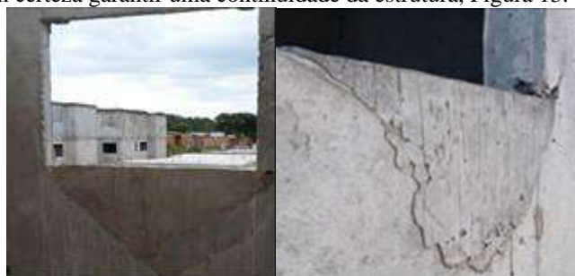
Figura 13: Falha de concretagem tipo D
