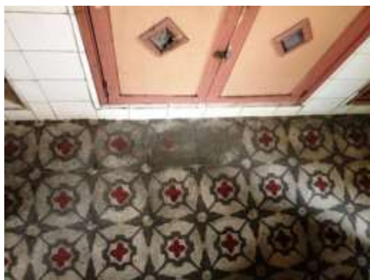
Figura 59: Piso em ladrilho hidráulico com desgaste superficial. Fonte: (PEREIRA, 2015, p.65)
