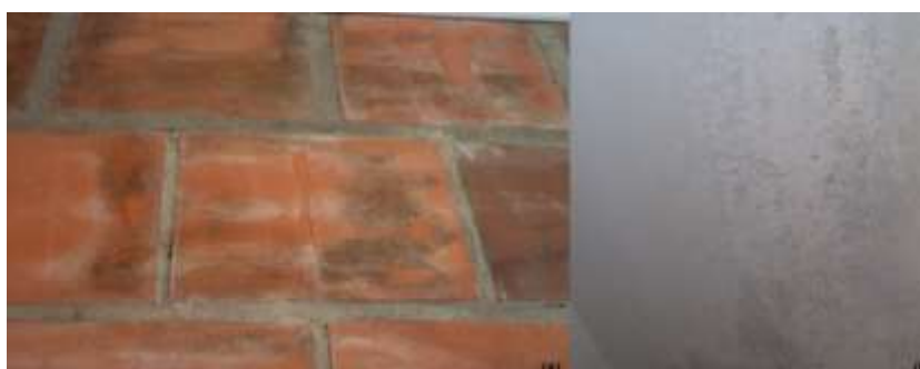
Figura 3: Evidências de mofo e bolos em paredes das residências Fonte: Acervo fotográfico dos autores (2012)
