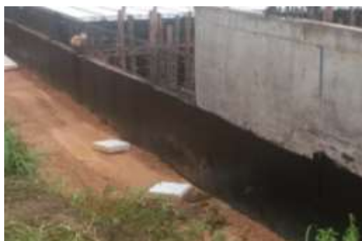
Figura 1 - Emulsão asfáltica aplicada.
