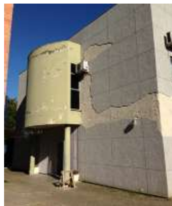
Figura 2: Foto da fachada principal marcado por volume arredondado sem capeamento
