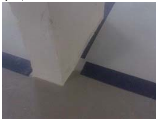
Figura 16 – Aplicação de primer acrílico antes da aplicação do revestimento autonivelante cimentício.
