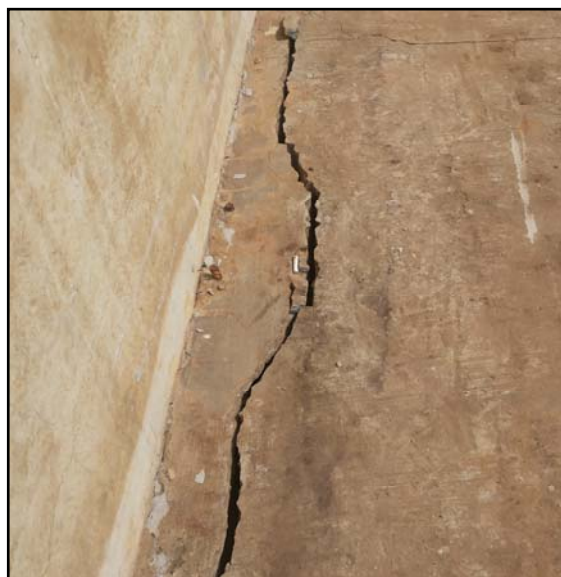
Figura 3: Trinca localizada em fundações do terminal de cargas. Fonte: DNIT (2014)
