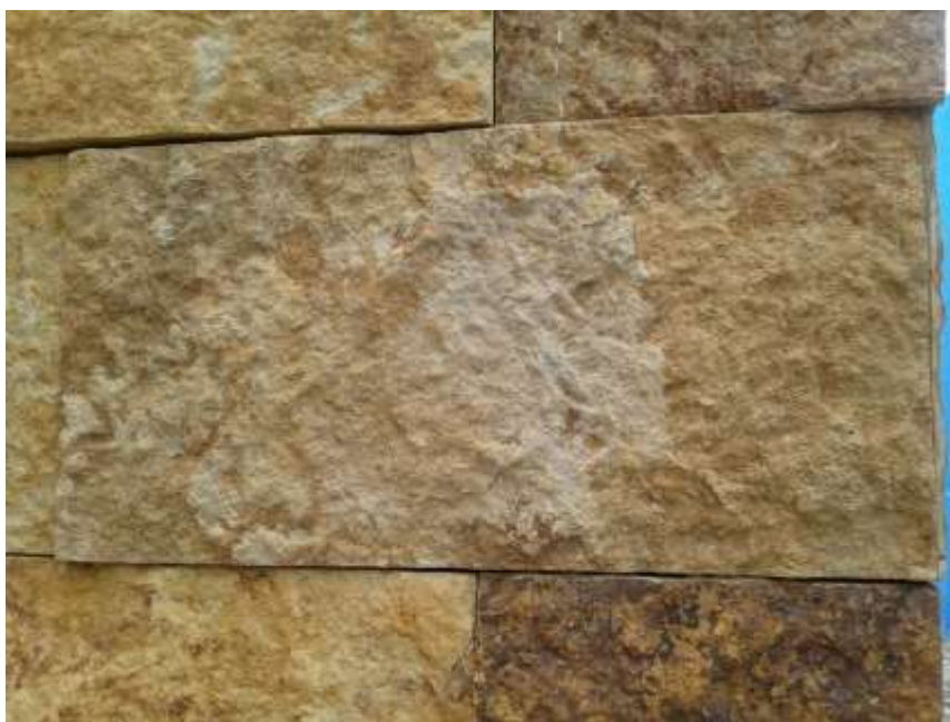
Figura 04: Juntas de movimentação da fachada da igreja Fonte: Acervo dos autores
