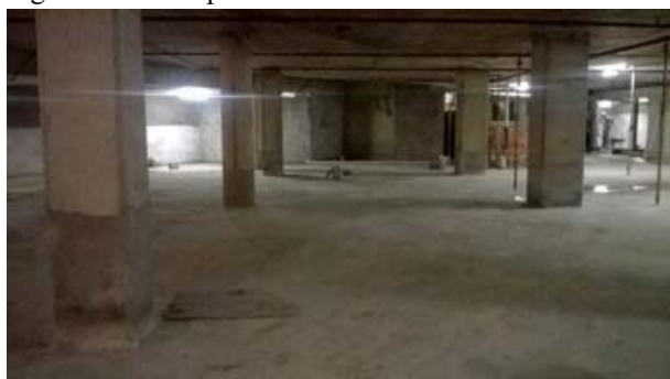
Figura 33 – Aplicação de argamassa de impermeabilização por cristalização integral na laje e nos pilares.
