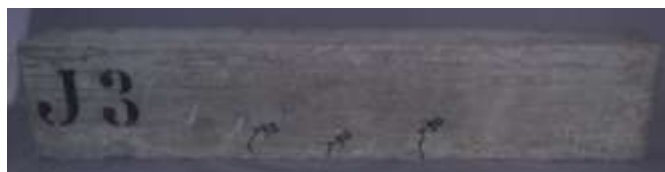
Figura 15: Viga J3 após Pré-Fissuração
