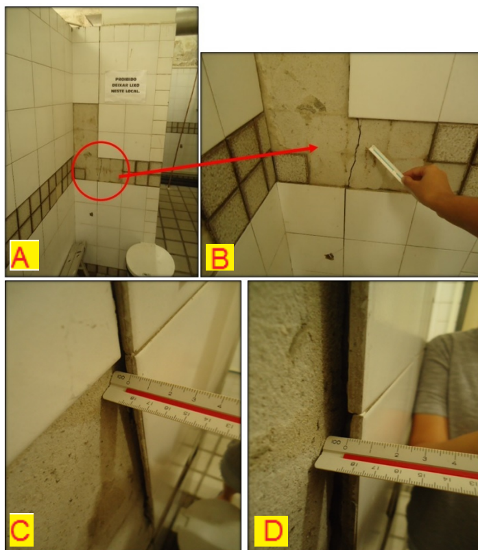
Figura 10: Descolamento de revestimento cerâmico em um pilar fissurado.
