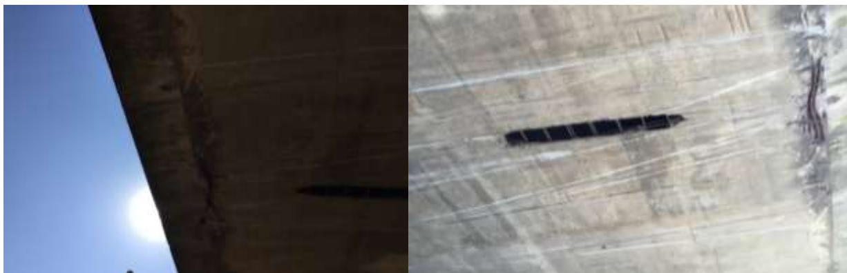
Figura 6: Armaduras expostas.
