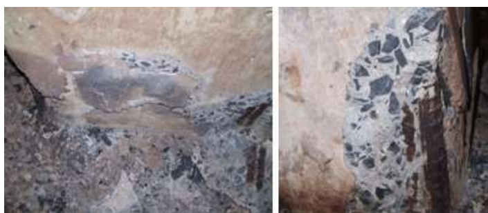
Figura 6: Deslocamento do cobrimento basal dos pilares e armadura exposta
