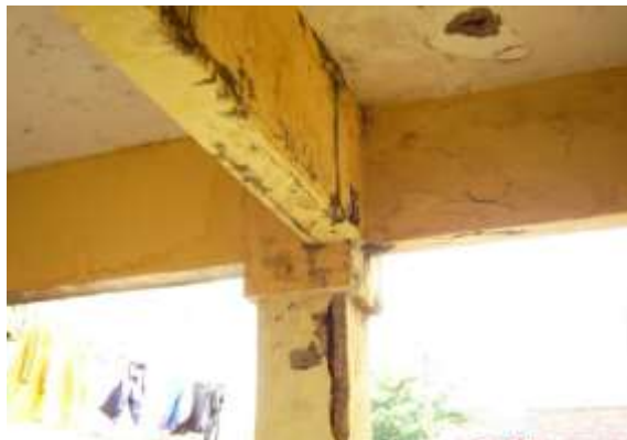
Figura 2 Deslocamento do cobrimento da viga lado A.
