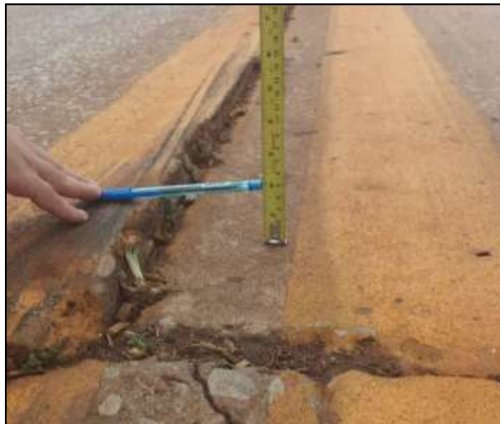
Figura 8: Desnível da pista de rolamento
