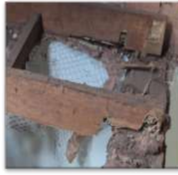
c) Danos próximos ao apoio
