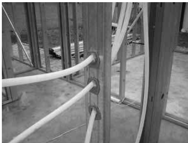
Figuras 8 e 9: Passagem de tubulação em montantes com proteção [19]
