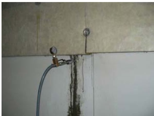
Figura 8 – Injeção de argamassa de alta fluidez e baixa viscosidade com cristalizante.
