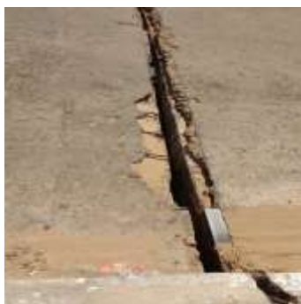
Figura 10: Falha nas juntas de dilatação
