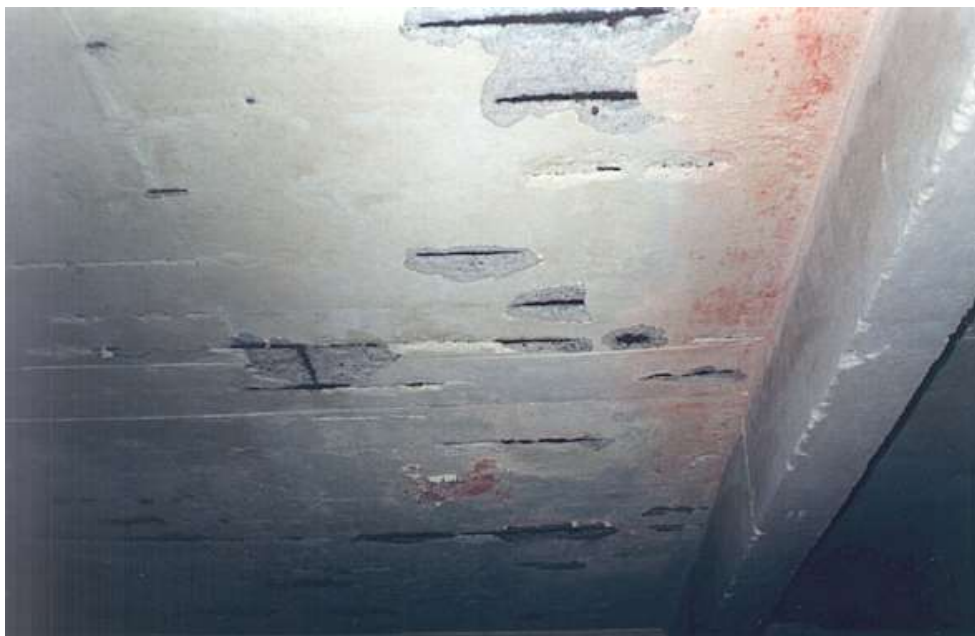
Figura 6: Lascamento do concreto devido à expansão dos produtos de corrosão nas armaduras da laje
