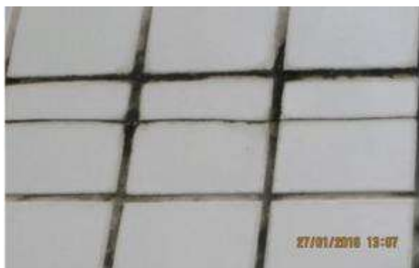
Figura 24: Revestimento da fachada fissurado.
