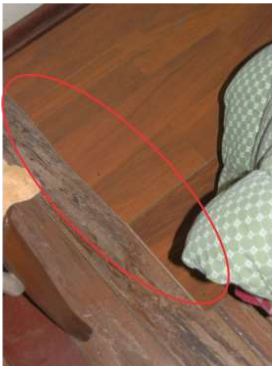
Figura 11: Reforço no piso improvisado por usuários
