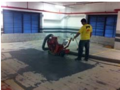
Figura 1 – Jato captivo de granalha para remoção de pinturas
