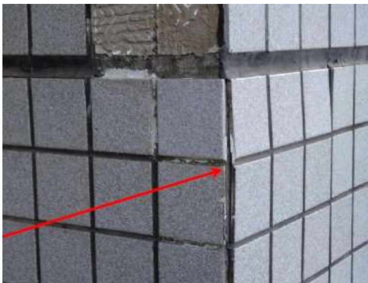
Figura 4: Deslocamento do revestimento cerâmico dos pilares do pilotis
