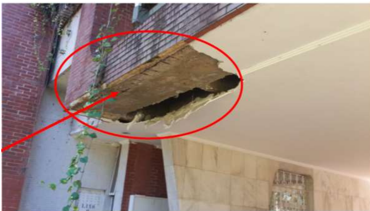
Figura 3a: Armaduras de aço corroídas
