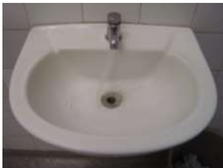
Figura 7: Fluxo de água irregular na torneira devido à entupimento
