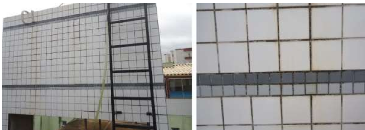
Figura 17. Sujidade no Reservatório C1.
