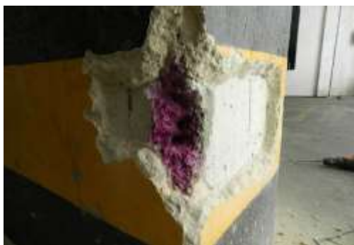
Figura 9 – Ensaio de profundidade de carbonatação no pilar recuperado
