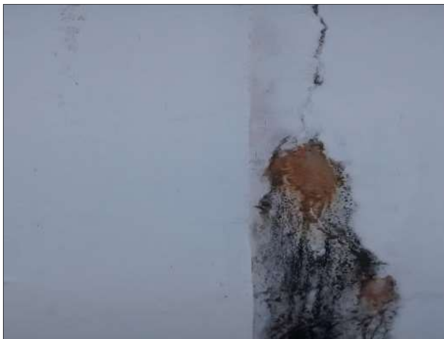
Figura 8: Parede do reservatório com sinais de eflorescências e manchas de bolor. . (Fonte: Autor, 2015)
