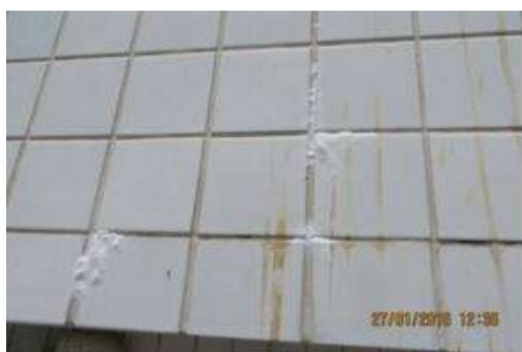
Figura 22: Manchas de eflorescências na fachada.
