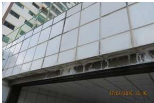
Figura 5: Manchas de eflorescência na viga de entrada da casa de gás.
