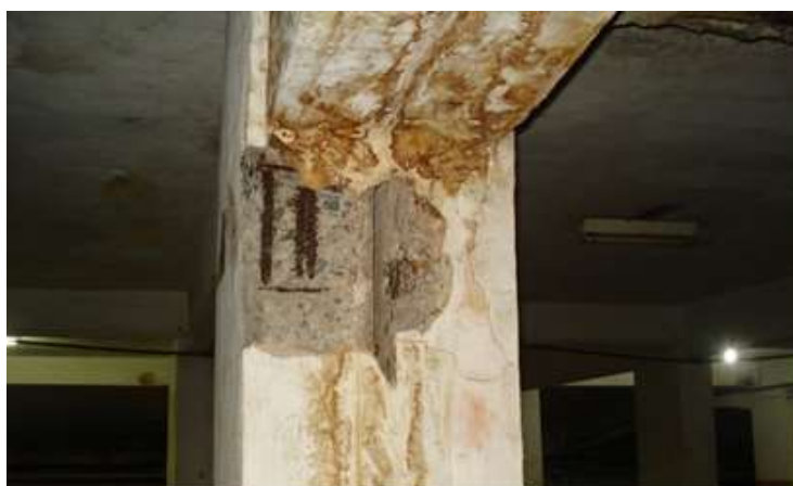
Figura 9: Manchas de corrosão e destacamento do revestimento.
