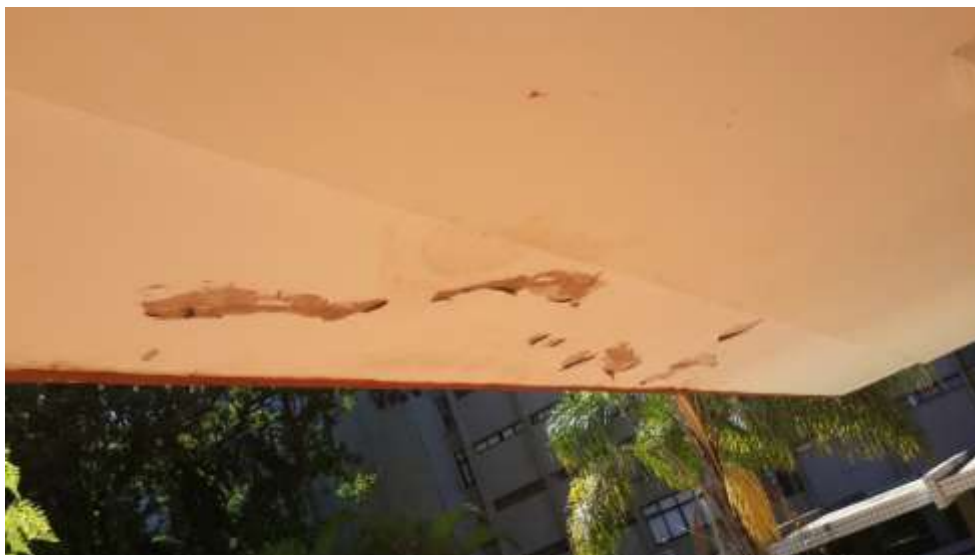
Figura 1: Pintura do teto do pilotis danificada por causa da infiltração
