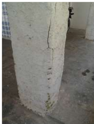
Figura 3: Fissura em aresta. (Fonte: Ricardo Dolabella)
