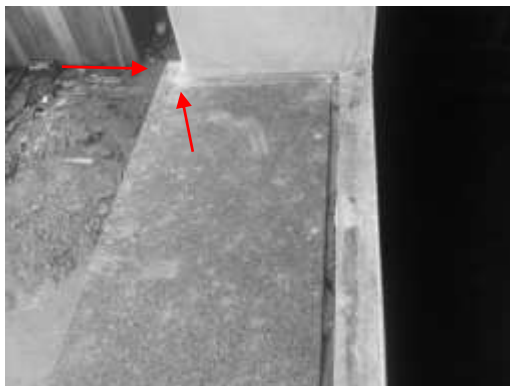
Figura 21: Prolongamentos da pingadeira insuficiente
