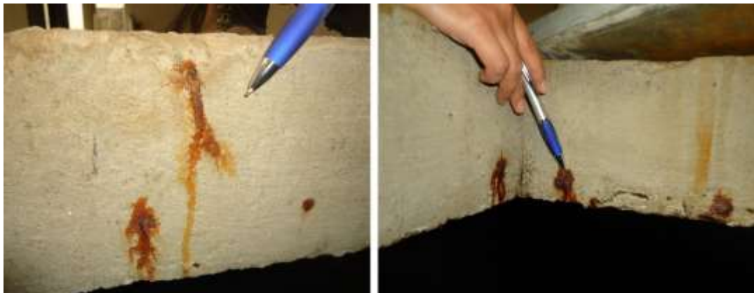
Figura 20. Pontos de corrosão de armaduras no Reservatório C2.
