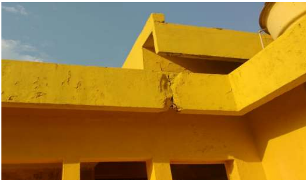
Figura 5: Armadura exposta
