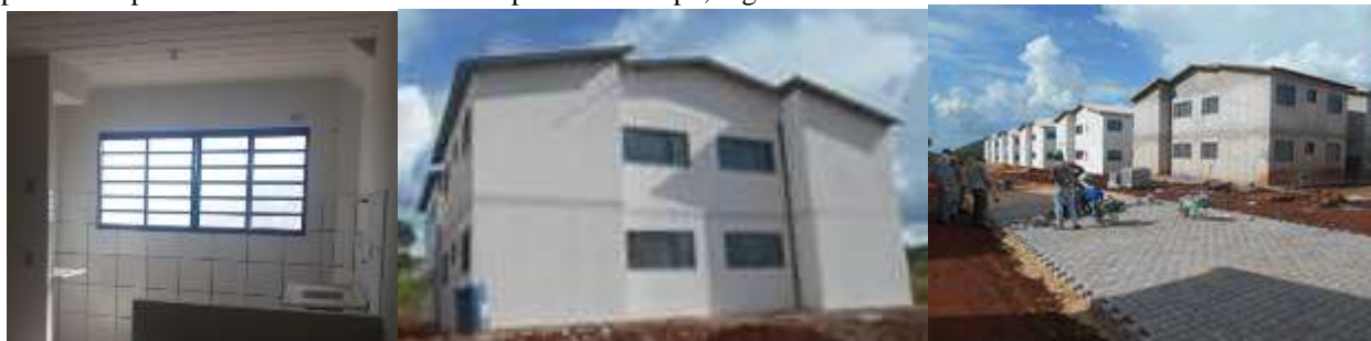
Figura 17: Aspectos finais da obra
