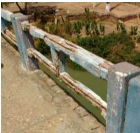
Figura 9: Deterioração no guarda-corpo
