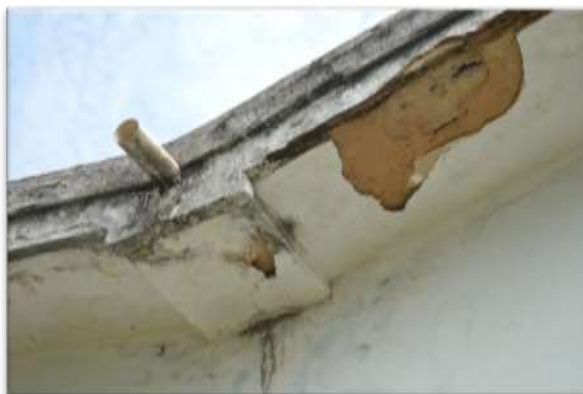
Figura 3: Bolor e descolamento em placas encontrado na fachada da Casa “G” (próximo à calha).
