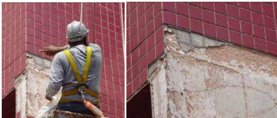
Figura 8 – Retirada de revestimento com risco de queda iminente.
