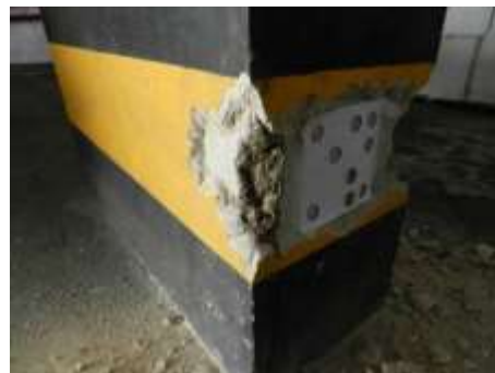
Figura 2 – Ensaio de presença de cloretos no Pilar 2 (reforçado)
