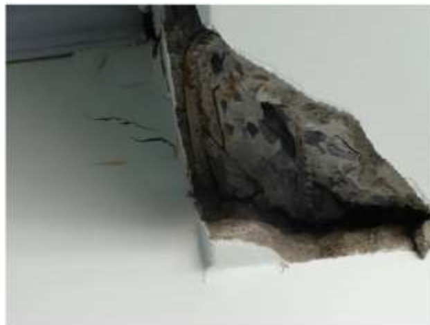
Figura 2b: Ruptura da viga VC02 de concreto armado
