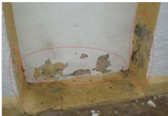
Figura 8: Fachada D – Manifestações patológicas no revestimento e outras.
