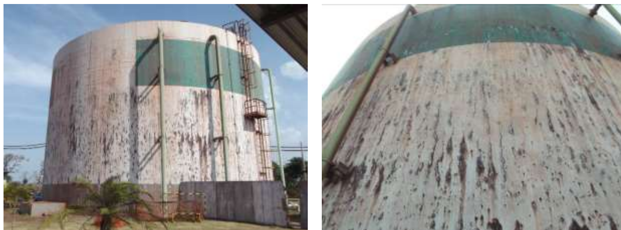
Figura 1: Vista geral (a) e vista parcial (b) do reservatório - 2013
