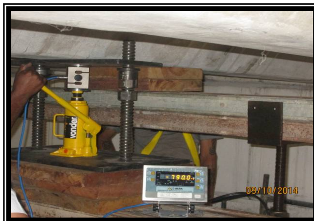
Figura 11 – Escoramento e alívio na telha detalhe com macaco hidráulico e célula de carga para controle dos esforços.
