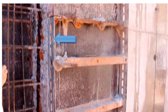
c) Detalhe do primer (tom laranja) para fixação da fita hidroexpansiva na junta das cortinas.
