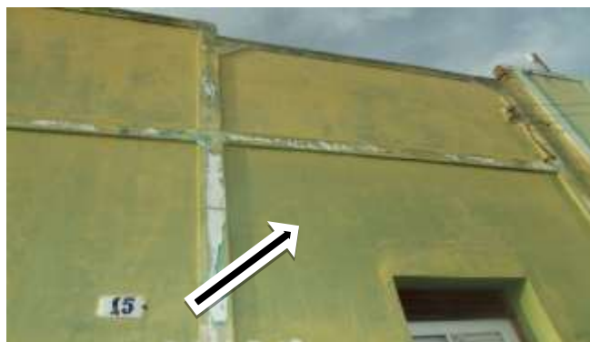
Figura 4: Fissuras mapeadas em paredes externas
