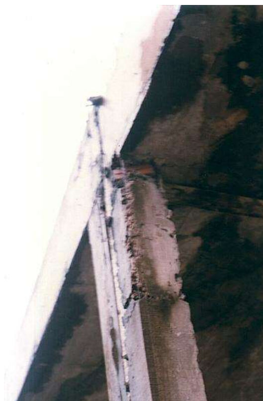
Figura 2: Ninhos de concretagem no encontro do pilar com a viga
