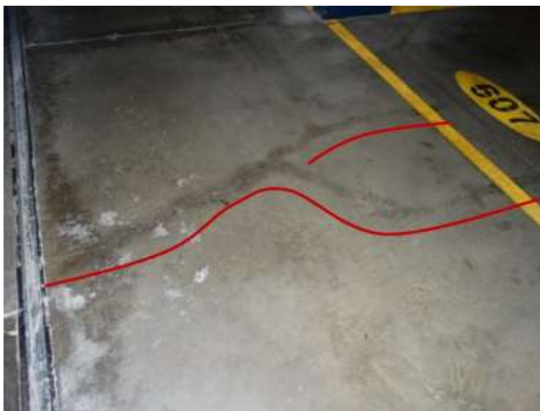
Figura 5 - Trincas e fissuras no piso da garagem.
