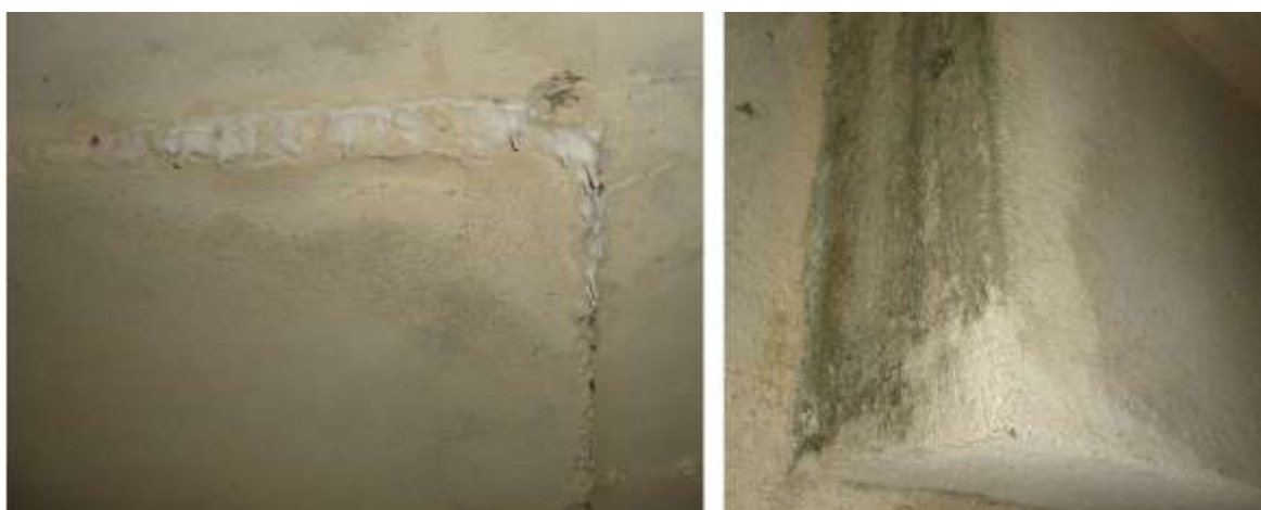
Figura 14. Eflorescências e bolor na área abaixo do Reservatório B1.
