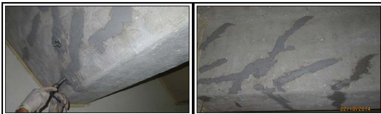
Figura 12 – Colmatagem e injeção de resina epóxi nas fissuras.
