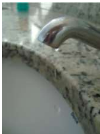
Figura 12: Pingos constantes devido à falha no fechamento da torneira
