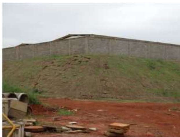
Figuras 8b e 8c: Vista da altura do aterro onde a edificação foi construída
