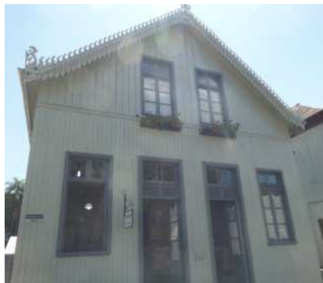
Figura 04: Fachada com ângulo da Casa Zanella, Luciano, tombada com reforma recente.
