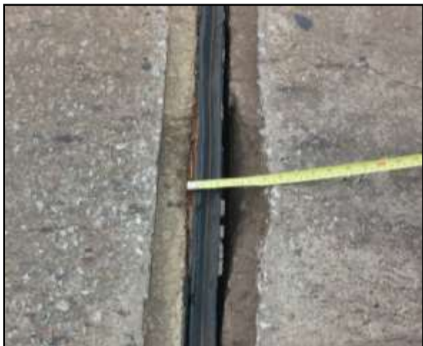
Figura 5: Junta de dilatação desgastada e ineficaz
