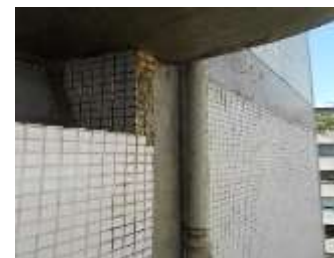
Foto 07 – Deslocamento de pastilhas
