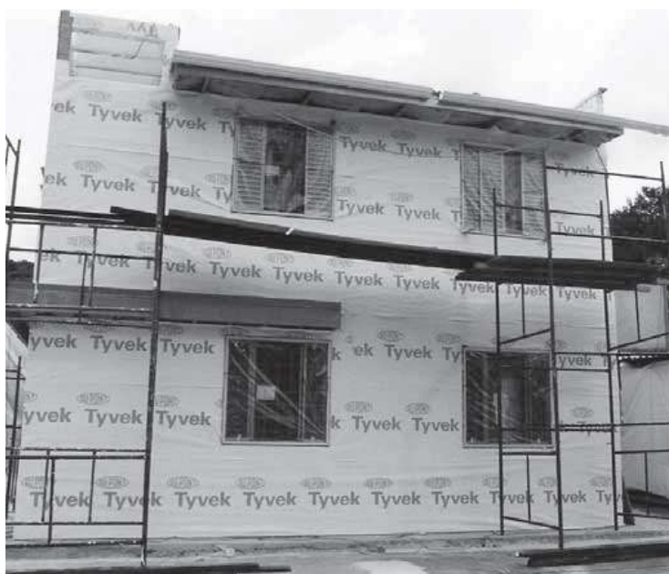
Figura 4: Impermeabilização das placas de OSB da fachada da foto anterior com membrana de polietileno [1]
