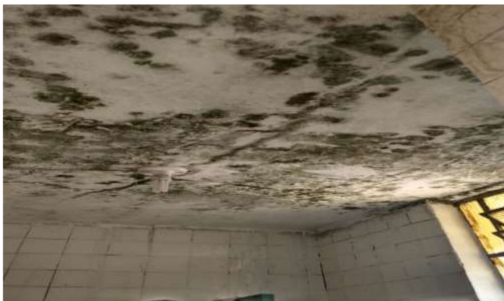
Figura 2: Patologia causada por umidade
