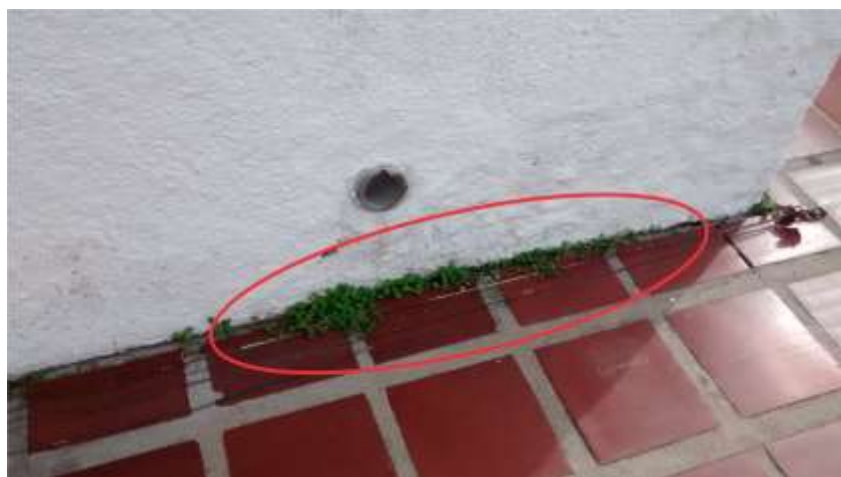
Figura 6: Vegetação parasitária entre piso externo e parede
