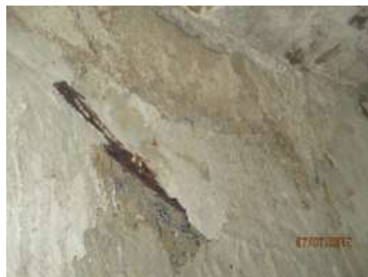
Figura 9: Armaduras expostas e corroídas em pontos das paredes internas das células 2 e 1, na região “gasosa”. Notam-se resquícios de reparos anteriores, sem efetividade.
