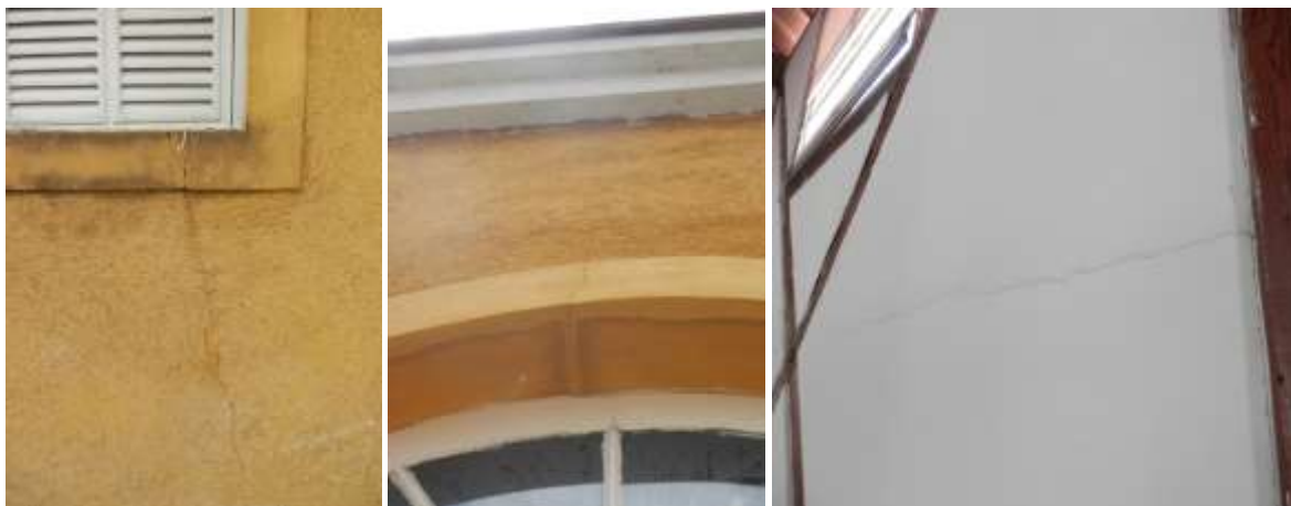
Figura 10: Fissuras (Fonte: autores)
