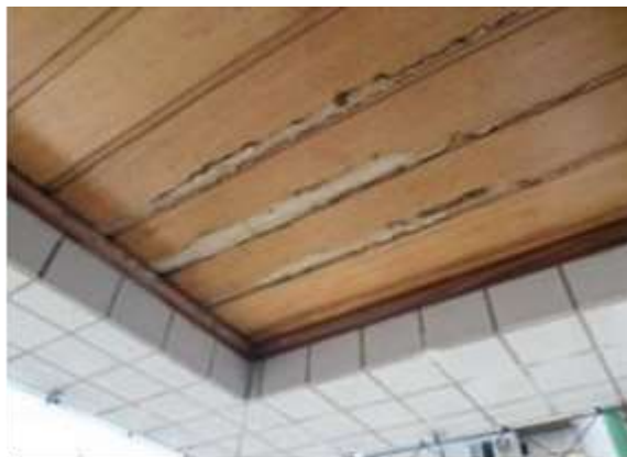
Figura 29: Infiltração no teto da varanda.
