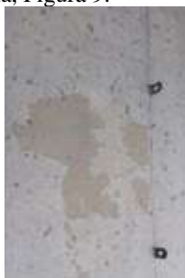
Figura 10: Manifestação patológica (9): deslocamento da camada superficial do concreto
