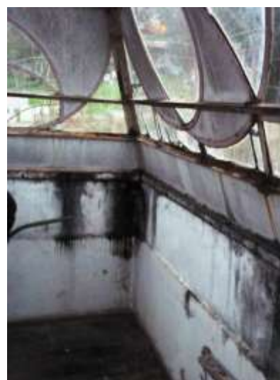
Figura 61: Oxidação da estrutura metálica no interior da torre, infiltração descendente e presença de microrganismos. Fonte: acervo pessoal, 2015.
