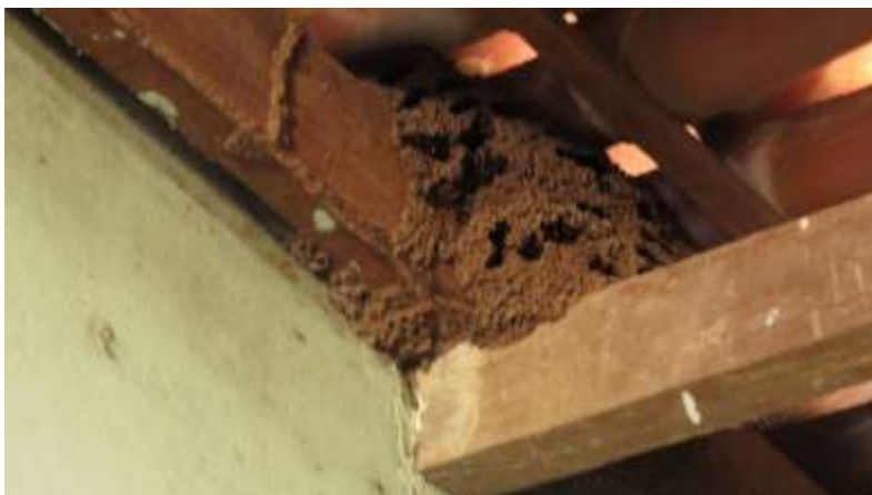
Figura 6: Ataque de cupim em estrutura de cobertura [18]
