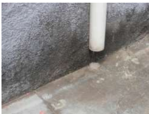
Figura 2: Manifestações patológicas decorrente de umidade. (Fonte: autores)
