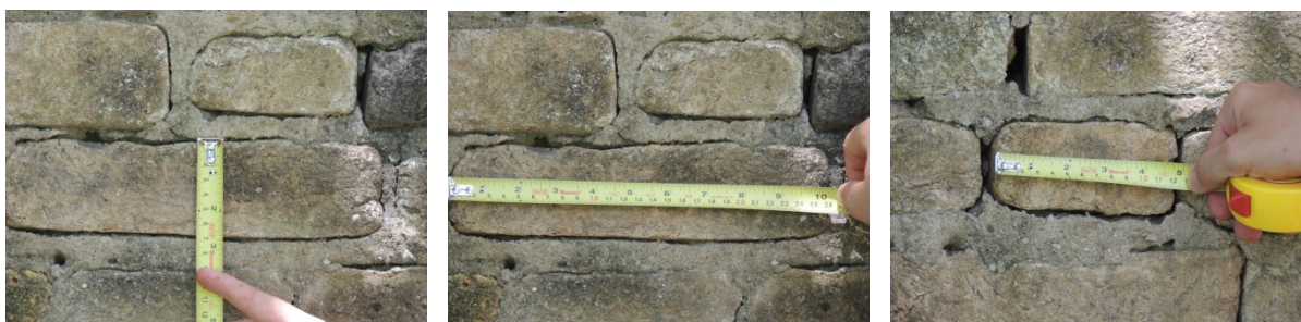
Figura 7: Detalhe da observação das características visuais da argamassa e da tijoleira existente fachada externa/posterior – rotunda, fraturas existentes (acervo Multitech, 2013).
