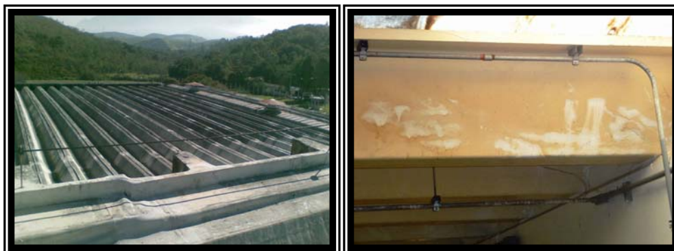
Figura 07: (a) Vista face superior das telhas de concreto; (b) Vista das Manifestações Patológicas próximos do apoio das Telhas de Concreto Armado Protendida.
