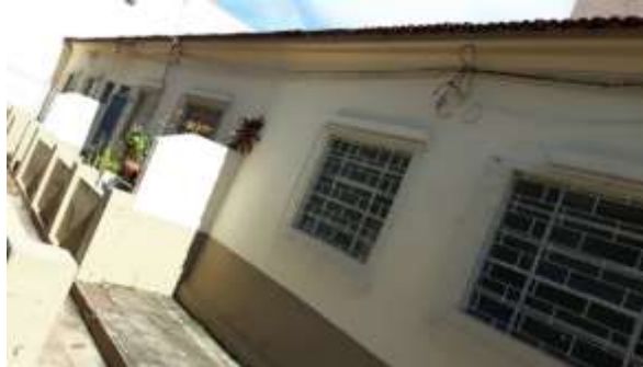
Figura 3: Vista da fachada da edificação em que o forro sofreu colapso.
