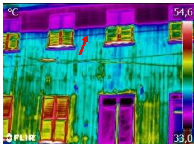
Figura 08 b) Diferenças de coloração e indicativo de regiões sombreadas na fachada de madeira da Casa Marcantônio, Camilo.
