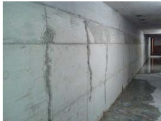
Figura 27 – Infiltração por junta entre laje e parede.
