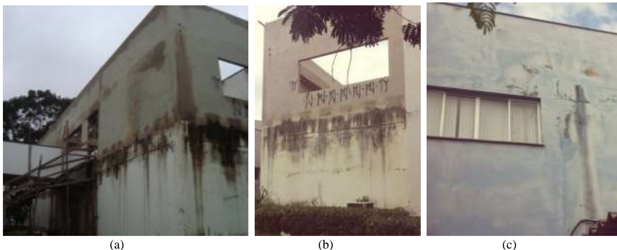
Figura 11: (a) Manchamentos, bolores e fissuras na horizontal – fachada nordeste, (b) Manchamentos, bolores e fissuras na horizontal – fachada noroeste, (c) Fissuras e incidência de vazamento – fachada noroeste.
