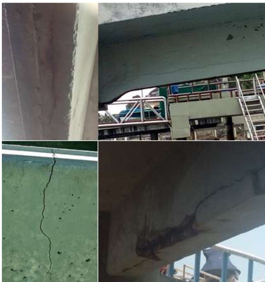
Figura 8 – Fissuras nos elementos estruturais do Píer A (canto superior esquerdo), B (canto superior direito), C (canto inferior esquerdo) e D (canto inferior direito).
