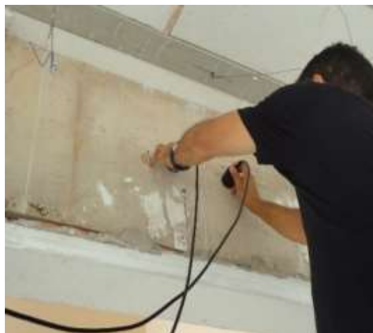
Figura 13: Ensaios de ultrassom para a determinação da profundidade das fissuras
