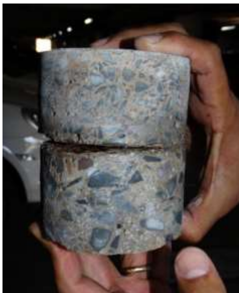
Figura 17 - Testemunho de área com som cavo.
