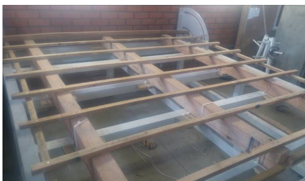
Figura 2 – Estrutura de caibros e ripas
