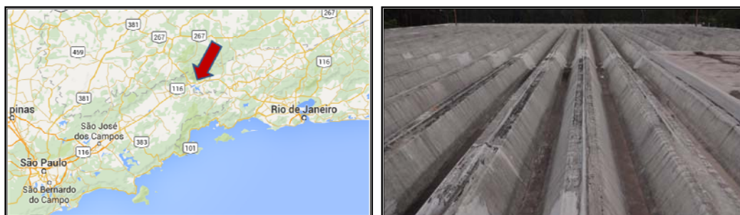
Figura 01 – (a) localização da Fábrica (fonte: Google maps); (b) foto do telhado da fábrica.
