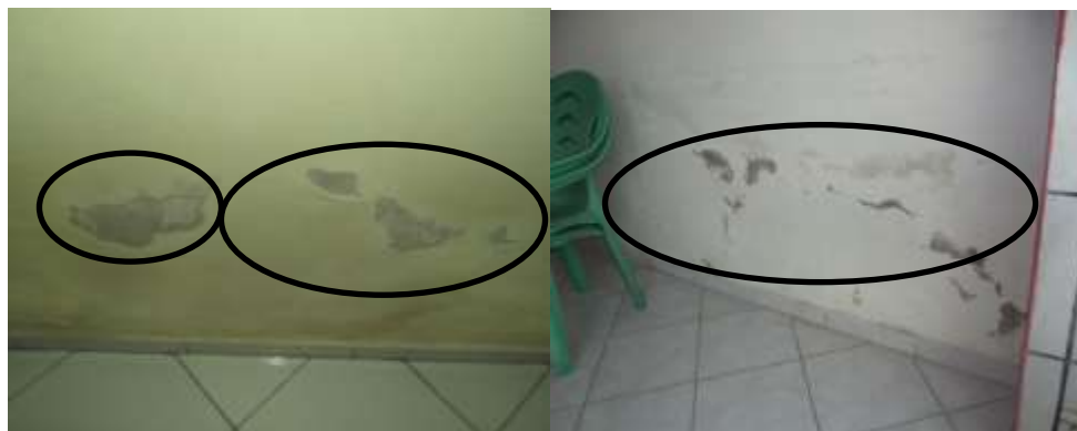
Figura 7: Eflorescência nas paredes internas da residência Fonte: Acervo pessoal (2014).
