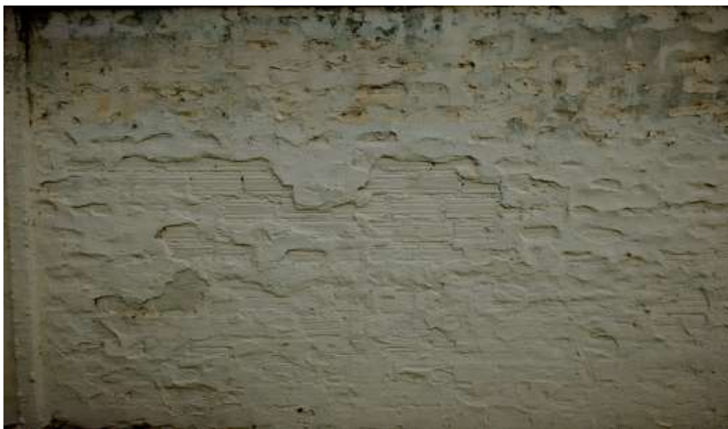
Figura 8: Destacamento do revestimento e formação de mofo no muro do estádio
