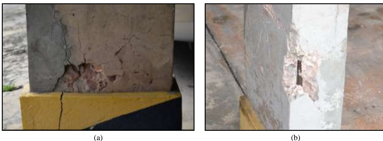
Figura 1: (a) Ocorrência de trincas na base de pilar e (b) Exposição das armaduras.
