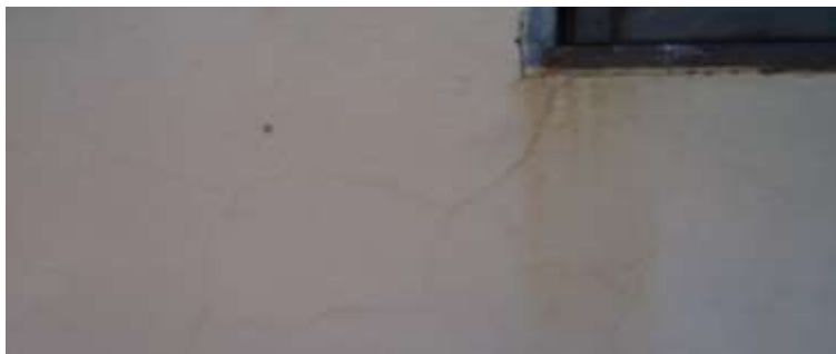
Figura 5: Oxidação de janelas com consequente manchamento de pintura Fonte: Acervo fotográfico dos autores (2012)
