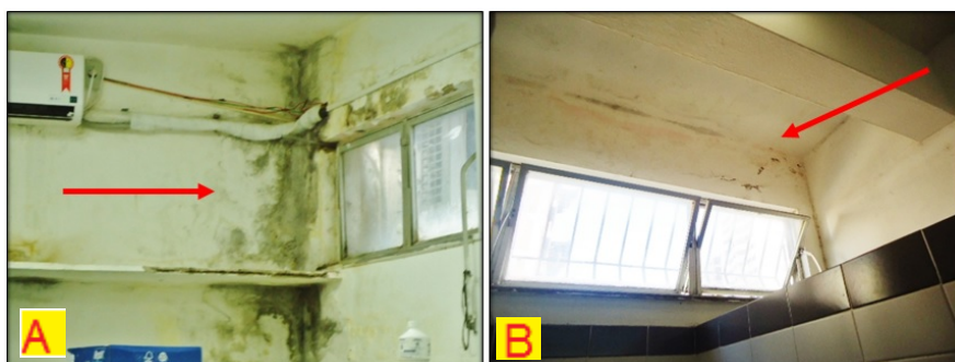
Figura 12: Proliferação de mofo e fungo nas paredes.
