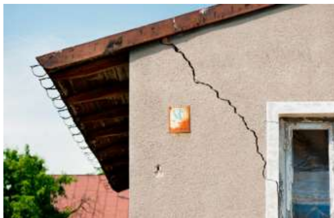
Figura 1: Verificação de fissura em uma parede [11].
