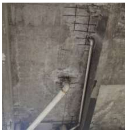
Figura 6: Corrosão das armaduras Fonte: Acervo pessoal (2015).
