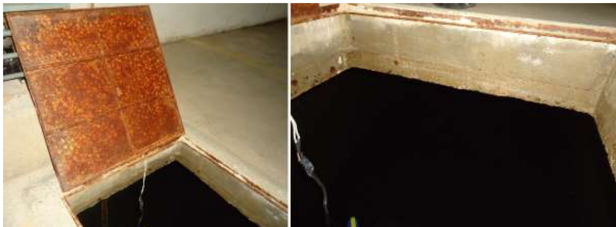
Figura 10. Corrosão na tampa e em pontos localizados do Reservatório A3.
