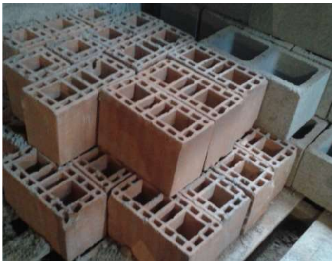
Figura 2 – Armazenamento de blocos na obra A.
