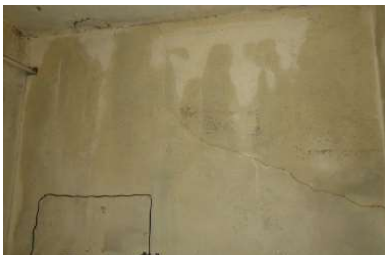
Figura 13. Infiltrações na base do Reservatório B1.
