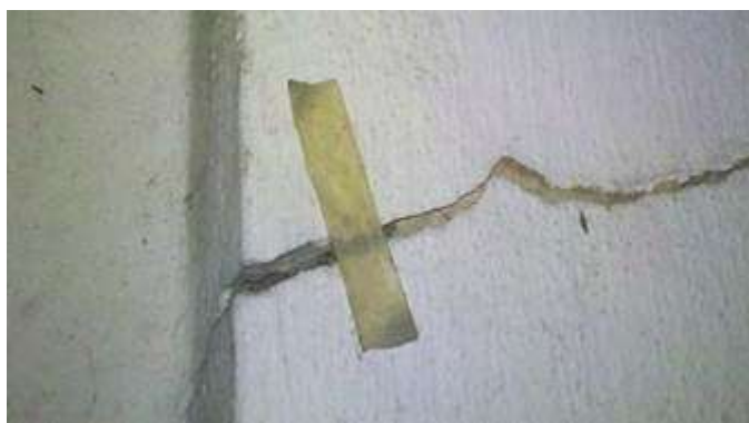
Figura 2: Avaliação de movimentação de fissuras.
