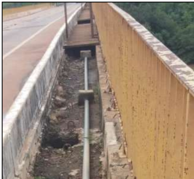
Figura 14: Ausência das placas de concreto na área de passagem de pedestres
