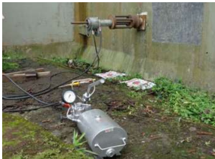
Figura 5 - Preparo de tirante para realização de ensaios de tração do tipo recebimento
