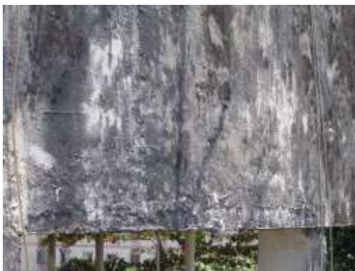
Figura 5 Eflorescência presente no Reservatório superior Lado B
