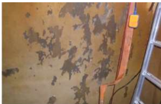
Figura 8: Destacamento do concreto na parede interna do reservatório inferior.
