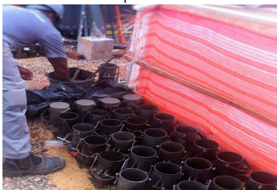
f) Controle tecnológico do concreto realizado em todos os caminhões, antes do lançamento.
