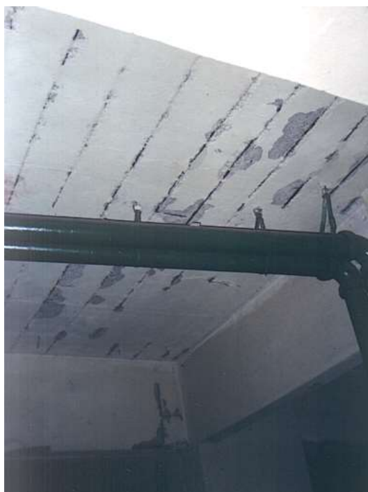
Figura 8: Lascamento do concreto devido à expansão dos produtos de corrosão nas armaduras da laje e viga
