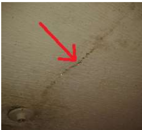
Figura 3: Infiltração proveniente de problemas na impermeabilização de calha na cobertura
