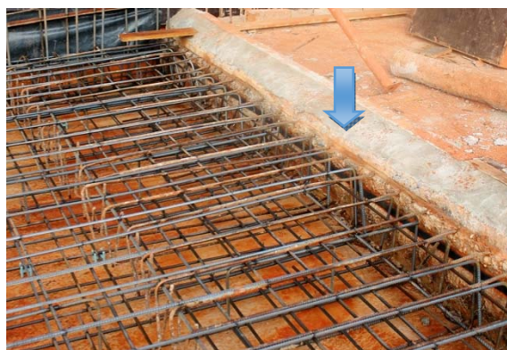
b) Detalhe da fita hidroexpansiva flexível instalada na interface da junta.
