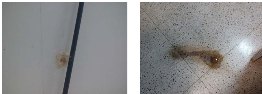
Figura 8. Gotejamento e estalactite
