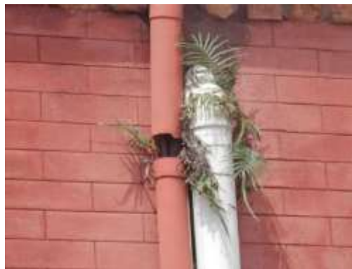
Figura 5: Desenvolvimento de microflora e vegetação de pequeno porte. (Fonte: autores)
