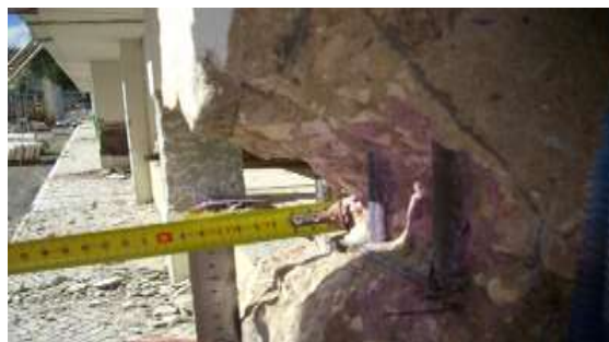
Figura 2: Identificação e profundidade da carbonatação.
