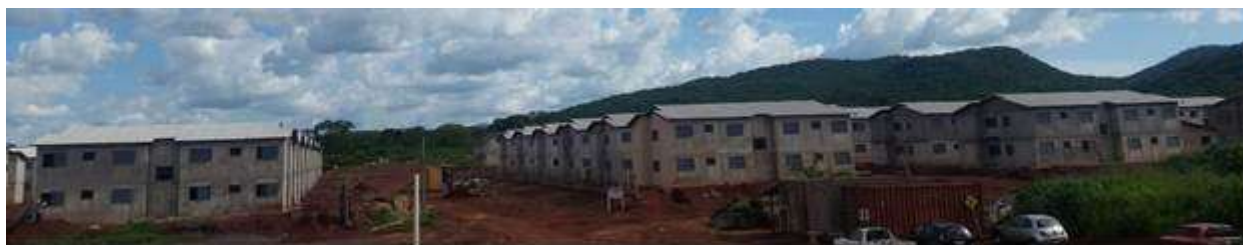
Figura 1 : Vista geral das obras Flamboyant III e II
