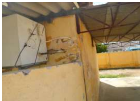
Figura 2: Manchas de umidade na escola 2.
