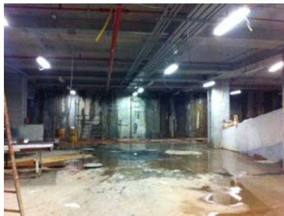
Figura 23 – Vista dos fundos do quinto subsolo com infiltrações e empoçamento de água.
