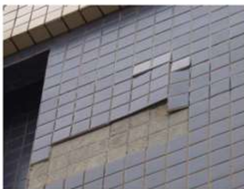
Figura 2: Deslocamento de revestimento cerâmico de fachada – fonte: [13]
