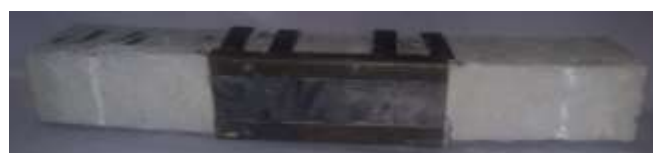
Figura 23: Face Inferior da Viga J4 após Ruptura
