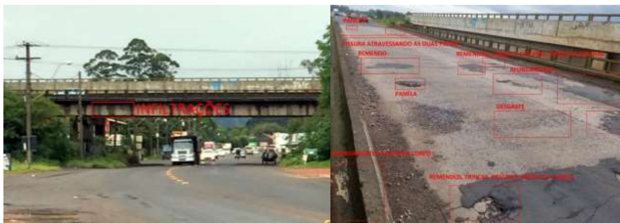
Figura 2: a) Visualização lateral do viaduto. b) Visualização superior do viaduto.
