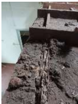
a) Antes da demolição;
