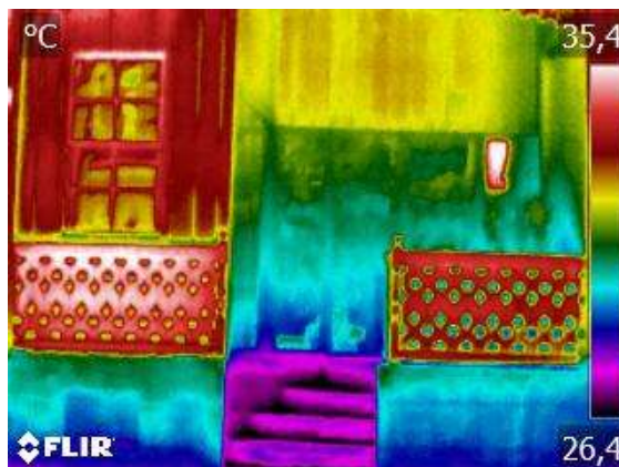
Figura 07: Degradação de uma fachada de madeira.
