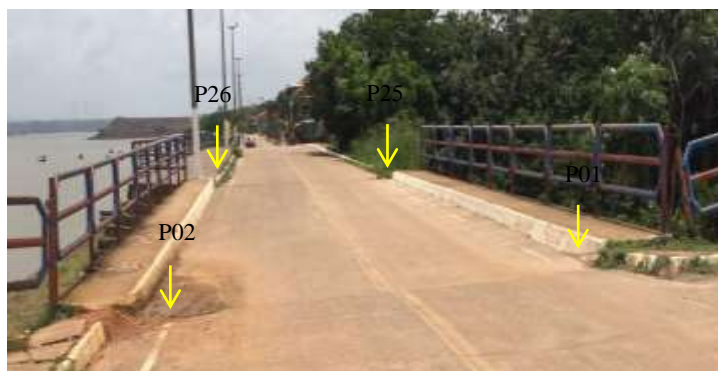
Figura 8. Tabuleiro da ponte onde foram realizadas as medições topográficas.
