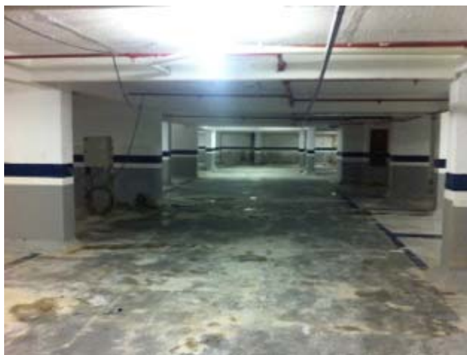
Figura 10 – Piso do terceiro subsolo com infiltração. Notar pintura existente de epóxi.
