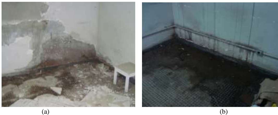
Figura 7: (a) Manchamento e deslocamento de revestimento - sala 202, (b) Empoçamento e piso danificado- sala 204.
