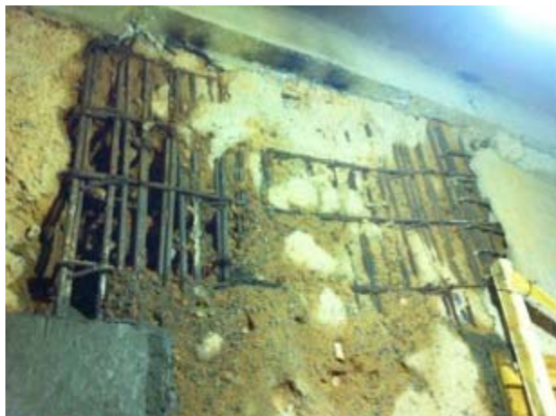
Figura 20 – Detalhe de concreto segregado na parede diafragma.
