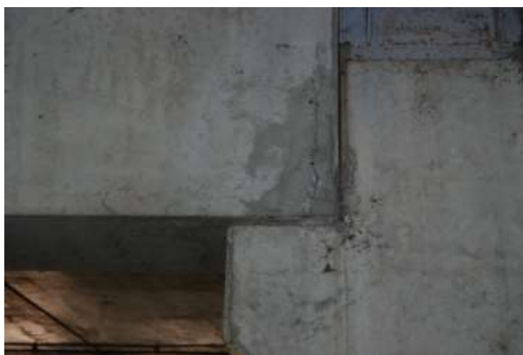
Figura 4: Fissura no canto inferior da viga
