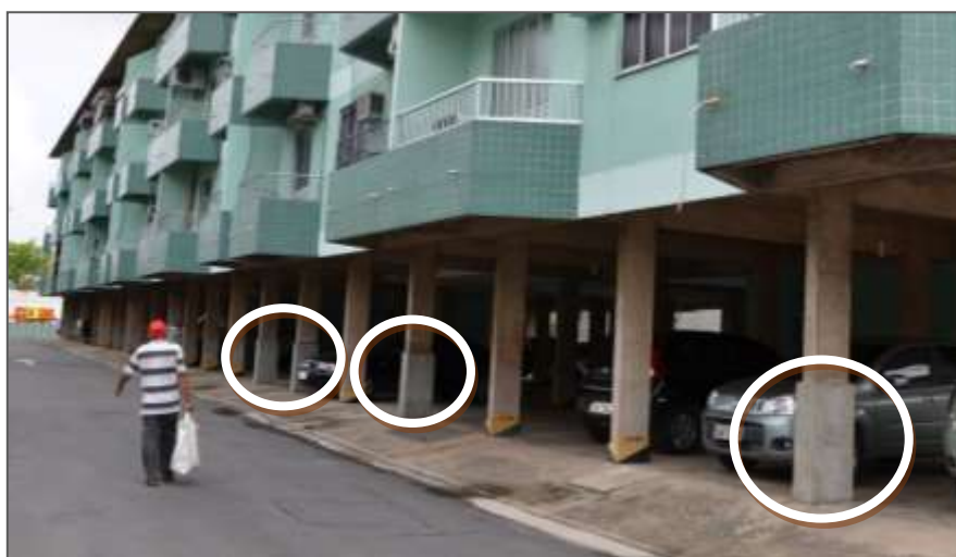
Figura 8: Panorama geral da edificação após reparo dos pilares carbonatados.
