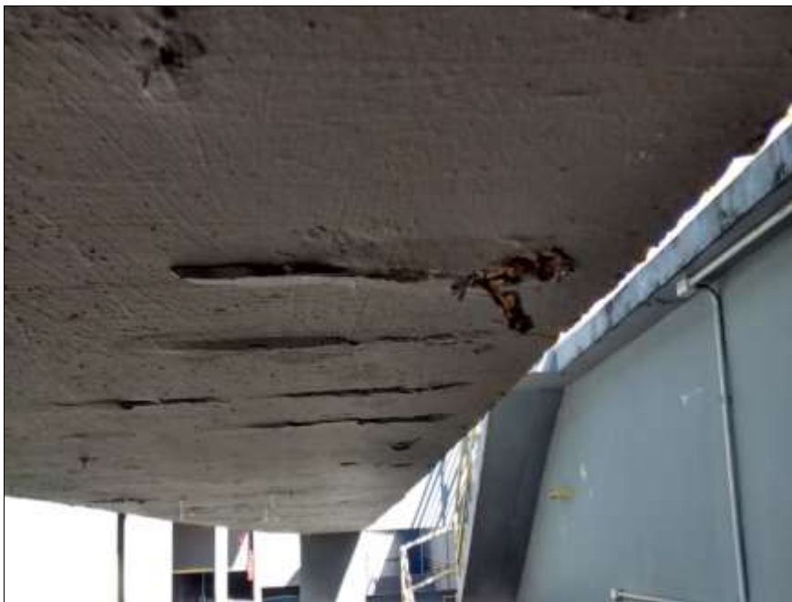
Figura 6: Corrosão de armadura evoluindo para deslocamento de concreto em laje de câmara de flocculação. . (Fonte: Autor, 2015)
