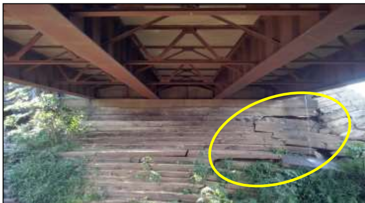
Figura 4. Vista das trincas e brechas nas peças estruturais
