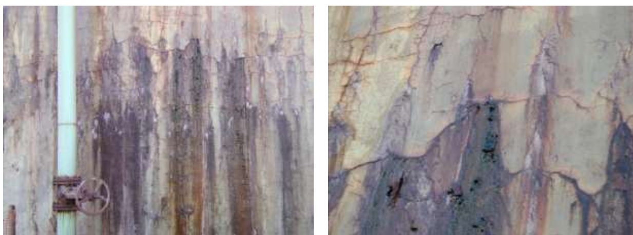
Figura 4: Detalhes da parede do reservatório apresentando fissuração e percolação de água
