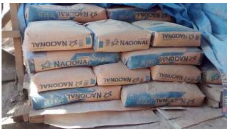
Figura 13– Estocagem de cimento na obra B.
