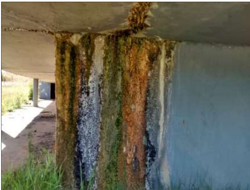
Figura 9: Fundo de reservatório com manchas de bolor, sinais de eflorescência e corrosão de armaduras. (Fonte: Autor, 2015)
