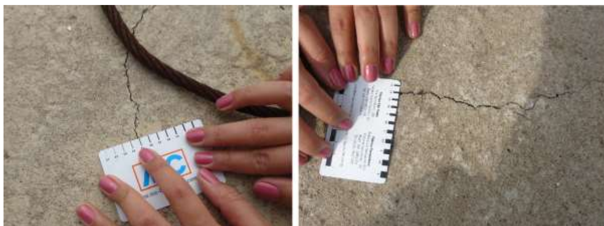
Figura 8. Lajes de cobertura dos Reservatórios A1 e A2, respectivamente.
