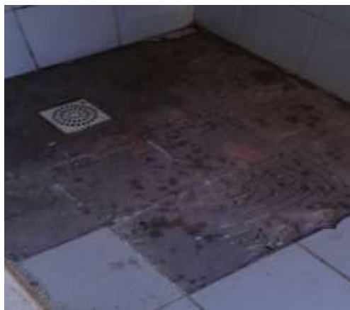
Figura 2: Descolamento de revestimento cerâmico
