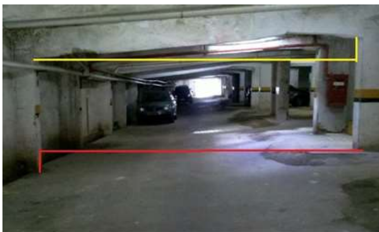
Figura 11: Recalque dos pilares secundários
