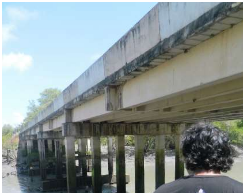
Imagem 5: Ponte sobre o Furo do Chato
