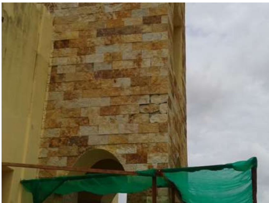
Figura 07: Deslocamento de pedra na fachada Fonte: Acervo dos autores
