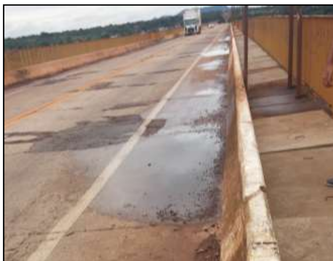
Figura 4: Falha do Sistema de Drenagem – Ponte Sobre o Rio Tocantins
