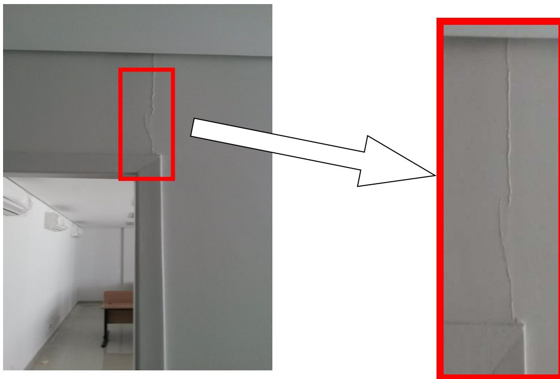
Figura 3 – Patologia na junta de porta.
