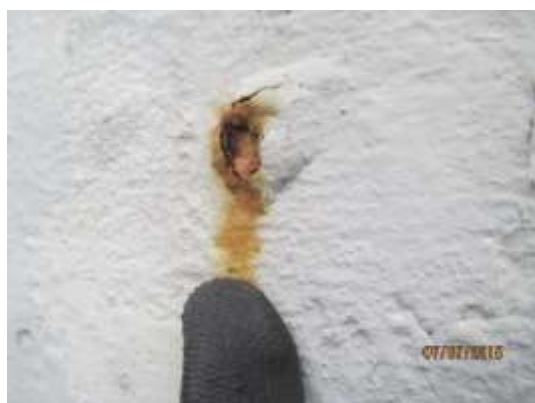
Figura 4: Pite de corrosão na parede externa, indicando possível corrosão por ação de cloretos.
