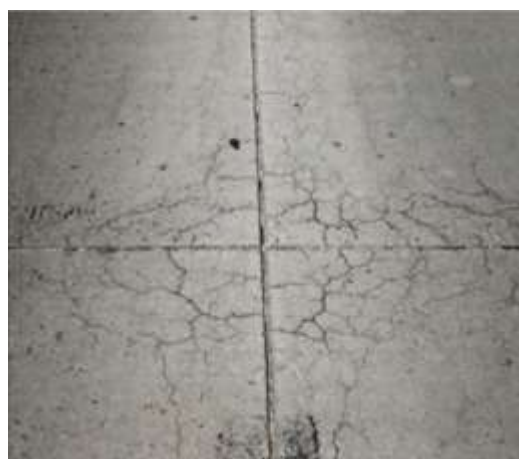
Figura 4b - Reação álcali-silica em um piso de concreto [5]
