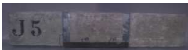
Figura 26: Viga J5 após Aplicação de Reforço
