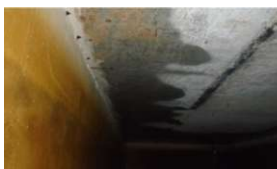
Figura 11: Manchas de infiltração na laje do reservatório inferior.
