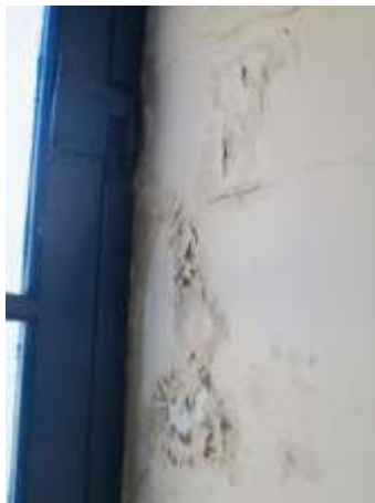
Figura 34: Manifestação patológica na parede em diversos pontos da edificação
