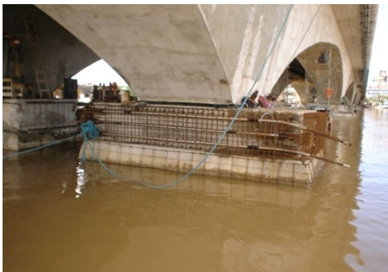
Figura 4: Armaduras da estrutura de confinamento de bloco atingido pela RAA.
