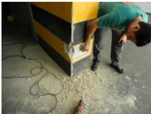
Figura 4 – Limpeza da superfície
