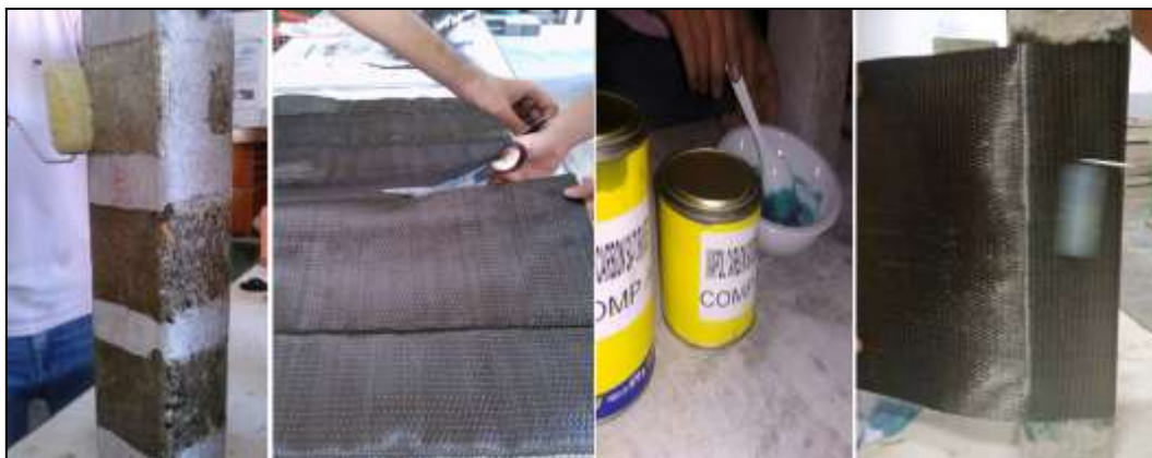
Figura 2: Processo de reforço dos pilares
