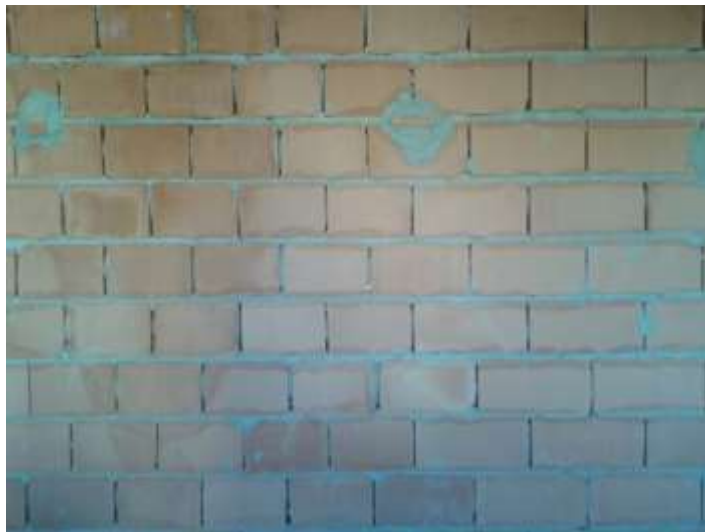
Figura 8 – Alvenaria executada na Obra A.
