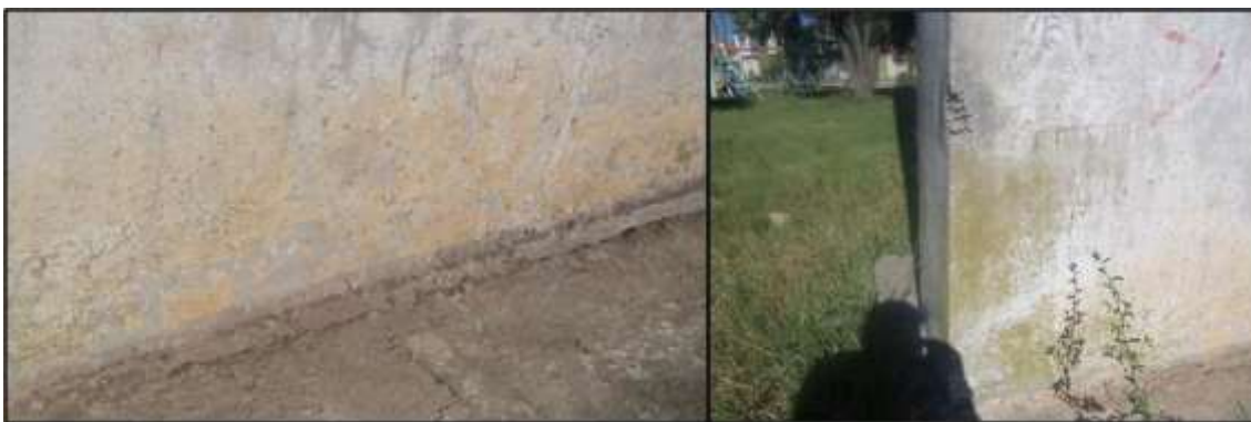
Figura 7: Manifestações patológicas nas bases dos pilares (AUTORA)
