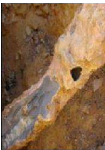
Grau 4 tendendo ao Grau 5 (exumação estaios torres transmissão)
