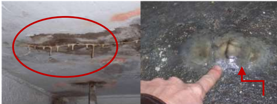
Figura 3: Aparecimento de concreções calcárias devido a perda de pasta do concreto
