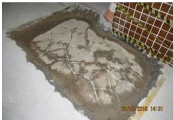
Figura 1: Blocos de coroamento da fundação.
