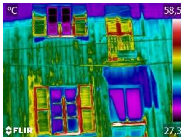
Figura 08 c) Imagem termográfica da fachada de madeira da Casa Marcantônio, Camilo.
