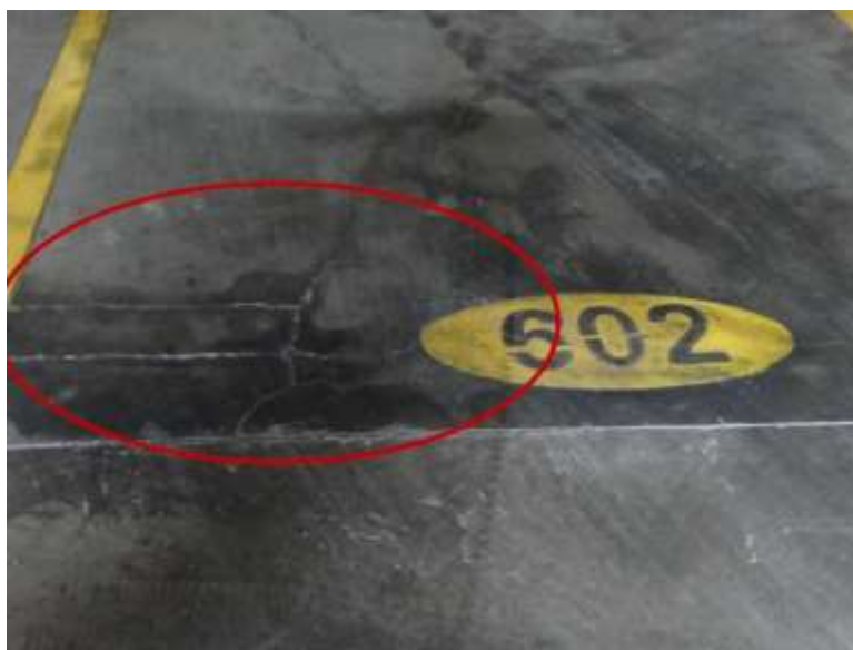
Figura 4 - Trincas e fissuras no piso da garagem.
