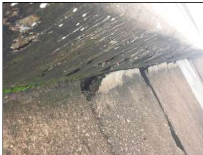
Figura 9: Deslocamento de concreto e exposição de armaduras
