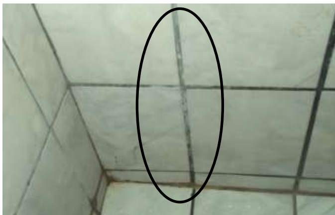
Figura 9: Eflorescência no rejunte do revestimento cerâmico Fonte: Acervo pessoal (2014).
