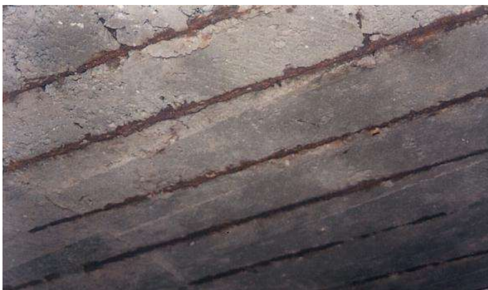
Figura 5: Laje executada sem o mínimo de cobrimento provocando corrosão generalizada
