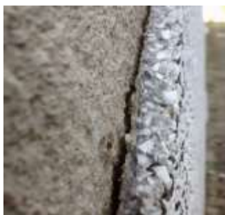
Figura 5:45 Descolamento na interface emboço/revestimento
