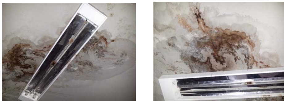
Figura 4. Manchas e sinais de corrosão da armadura
