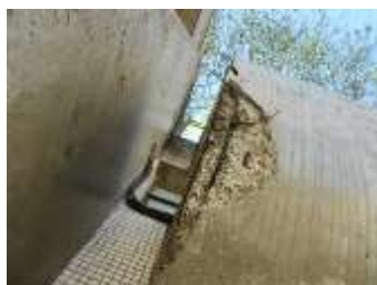
Foto 06 – Corrosão de armadura
