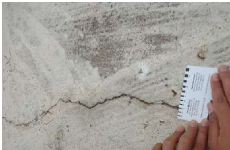
Figura 12. Fissuração de 1,6 mm na laje da cobertura do Reservatório B1.
