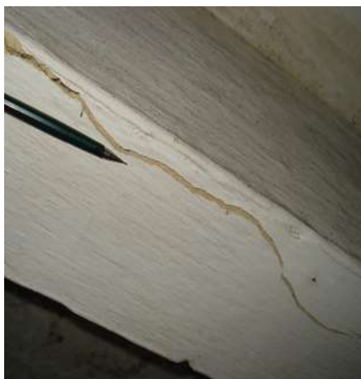
Figura 12: Viga com fissura devido à corrosão.
