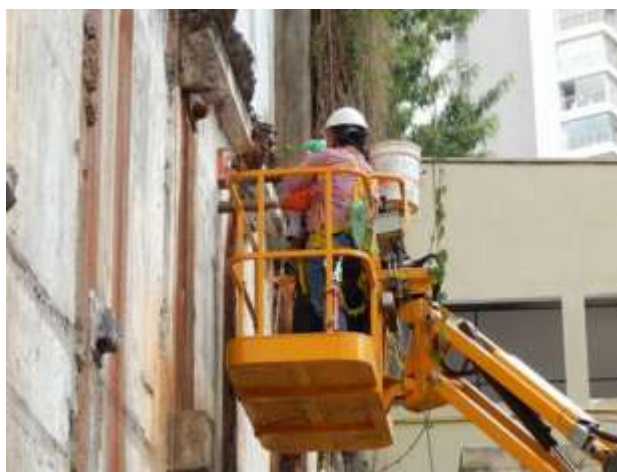
Figura 10 - Extração de corpo de prova em concreto da parede diafragma.
