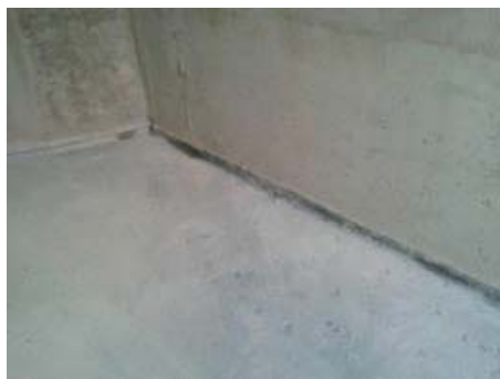
Figura 30 – Abertura de canaleta na junta entre parede e laje.
