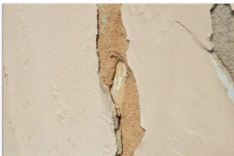
Figura 10: Descolamento em placa encontrado na fachada da Casa “J” (cano de PVC exposto).
