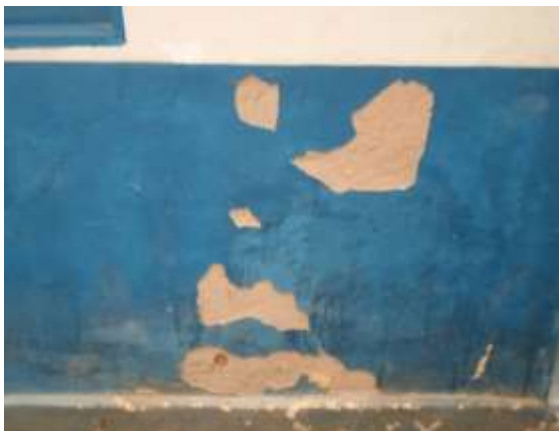
Figura 12: Descamação da pintura na escola 3.
