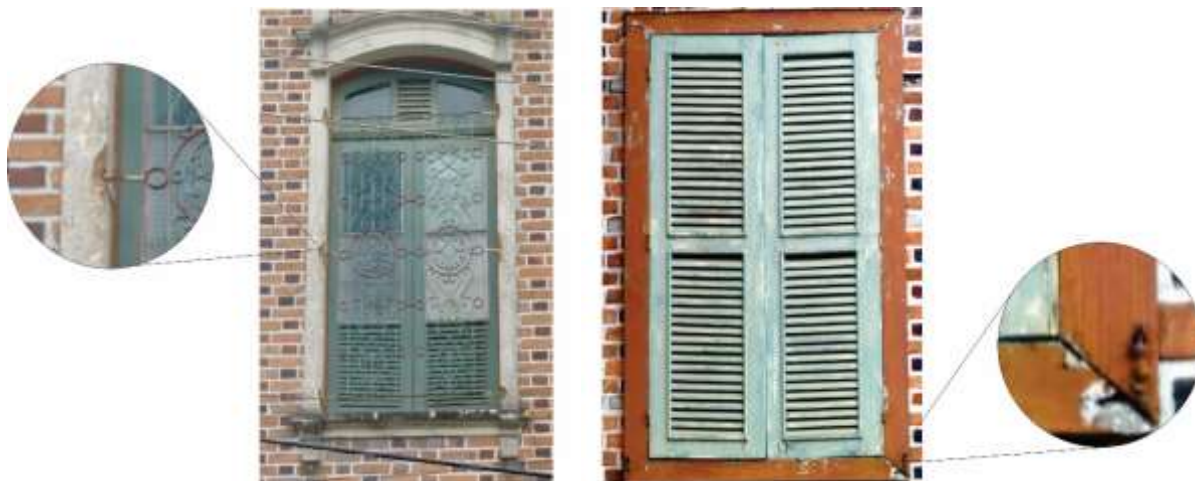
Figura 55: Perda de seção devido à colocação de gradil. Fonte: acervo pessoal, 2015.
