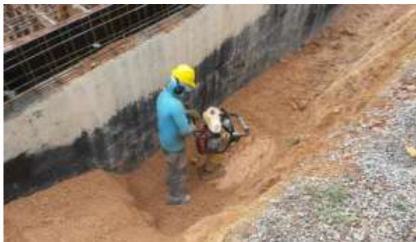
Figura 3 (a)- Compactação das paredes de contenção Figura 3 (b) - Aterro da parte externa da parede de contenção
