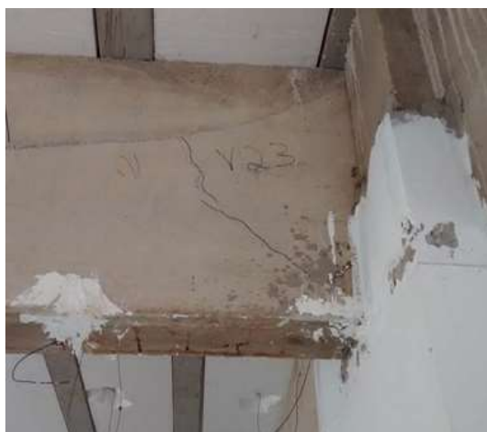
a) Fissuras de Cisalhamento
