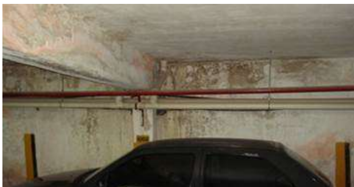
Figura 7: Lixiviação e manchas de umidade.
