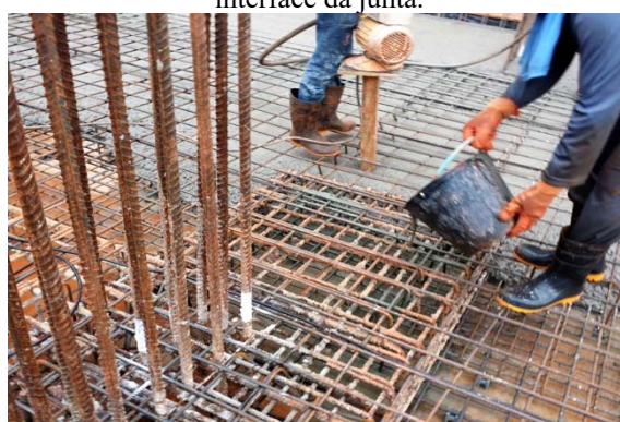
d) Aplicação do aditivo autocicatrizante na base dos pilares.
