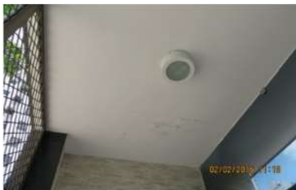
Figura 12: Infiltração na laje da guarita.
