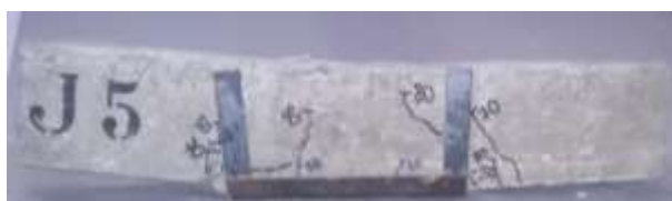
Figura 27: Viga J5 após Ruptura
