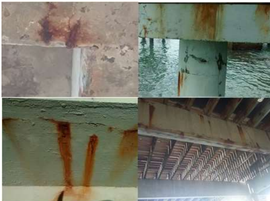
Figura 4 – Corrosão da armadura do Píer A (canto superior esquerdo), B (canto superior direito), C (canto inferior esquerdo) e D (canto inferior direito).
