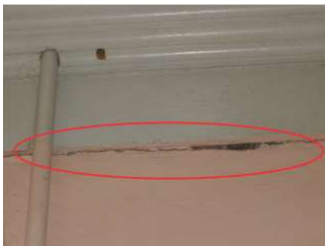
Figura 10: Deterioração de rodaforno de madeira
