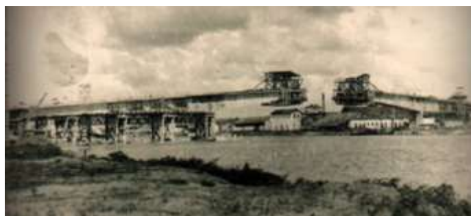
Figura 1: Construção da ponte Simplício Dias.
