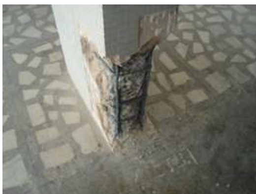
Figura 12: Aplicação de primer rico em zinco. (Fonte: Reitec)
