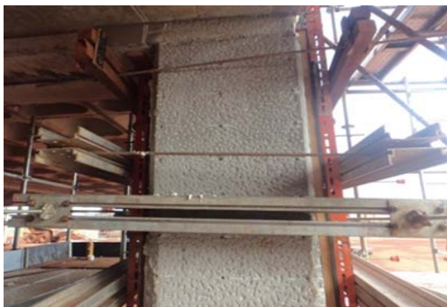
Figura A01: Preparação do substrato. Fonte: arquivo pessoal
