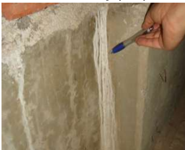
Figura 6. Eflorescências na base do Reservatório A1.
