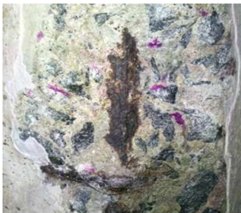
Figura 15: 1º pilar totalmente carbonatado.
