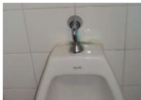
Figura 4: Vazamentos nos mictórios do AT4
