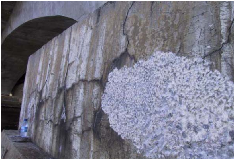
Figura 3: Bloco com fissuração excessiva do tipo “mapa”.
