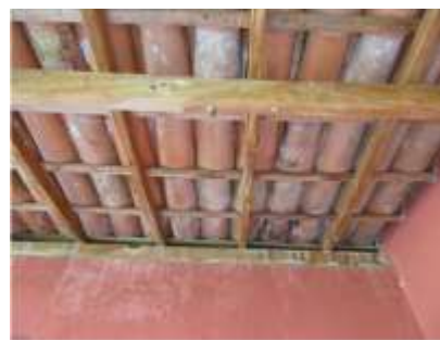
Figura 8: Vista inferior da cobertura sobre a varanda em frente ao subsolo. Notam-se manchas nas telhas e na estrutura de madeira [14].
