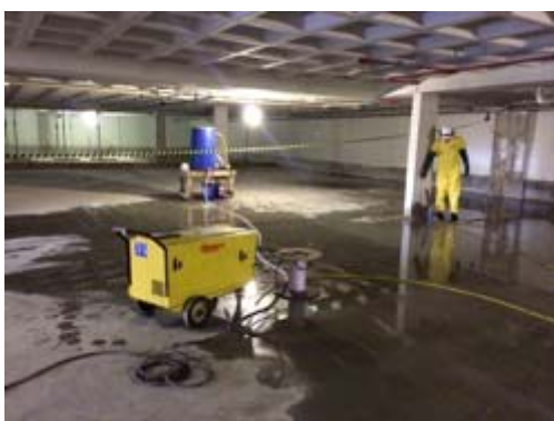
Figura 3 – Jato de alta pressão para abertura de poros do concreto (> 250 bar)
