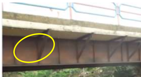
Figura 9. Corrosão da estrutura metálica.
