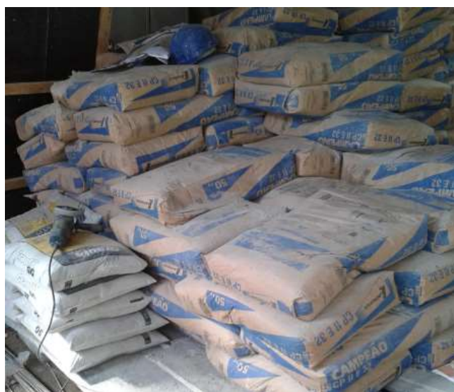
Figura 3 – Estocagem de cimento na obra A.
