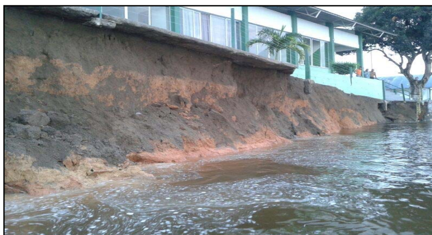
Figura 12: Fundação suspensa após rompimento do talude. Fonte: DNIT (2014)
