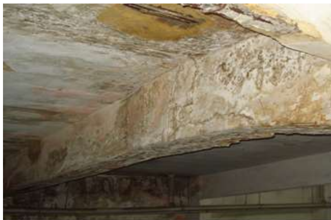
Figura 8: Manchas de corrosão e lixiviação do saibro
