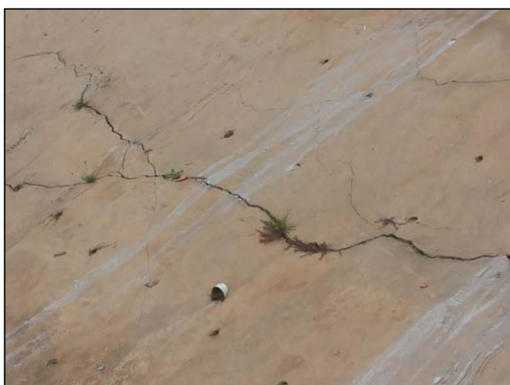
Figura 2: Detalhe da vista de fissuras na estrutura de contenção. Fonte: DNIT (2014)
