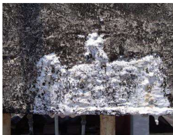
Figura 3 Eflorescência presente no Reservatório superior Lado A
