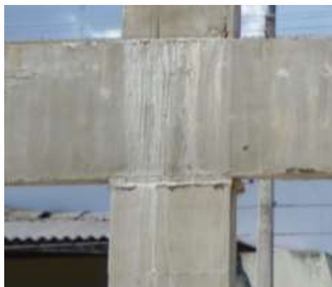
Figura 14 – Lixiviação de compostos hidratados nas áreas de contato pilar-viga do anexo A
