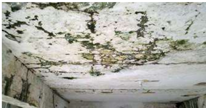
Figura 5: Presença de logo e fungos entre as fissuras.
