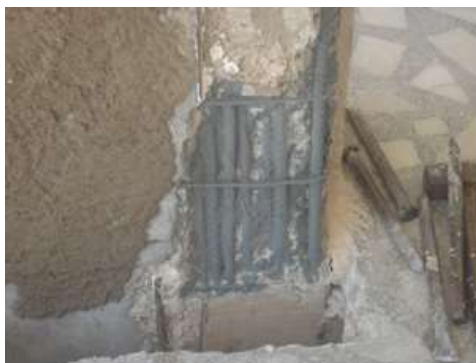
Figura 9: Alta densidade de armadura no pé do pilar. (Fonte: Prezi)
