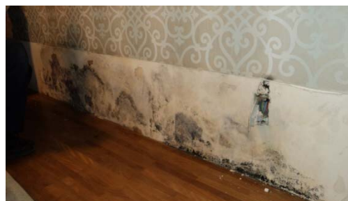
Figura 5: Mancha de umidade
