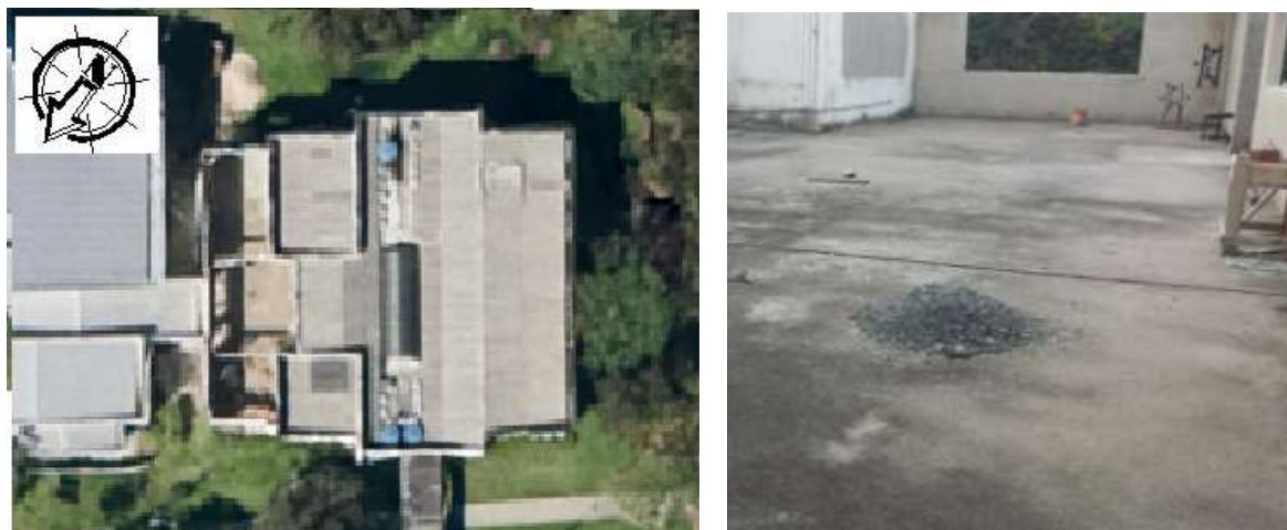
Figura 3: (a) Imagem por satélite da cobertura, (b) Laje de piso sem impermeabilização da área descoberta.
