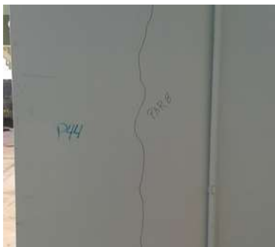
a) Fissuras em pano de alvenaria sem qualquer tipo de fissura
