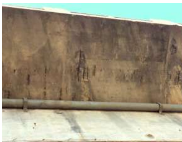
Figura 9: Desplacamento.
