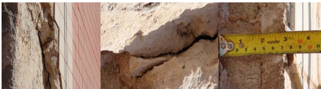
Figura 5- Patologias apresentadas no edifício B em 2008.
