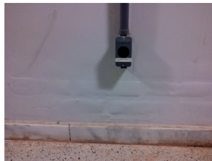
Figura 3. Bolhas na pintura
