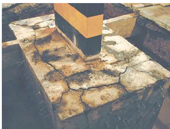
Figura 11 - Fissuras, em formato de mapa, decorrentes da RAA em uma fundação [4]
