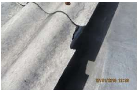
Figura 16: Telha quebrada na cobertura.
