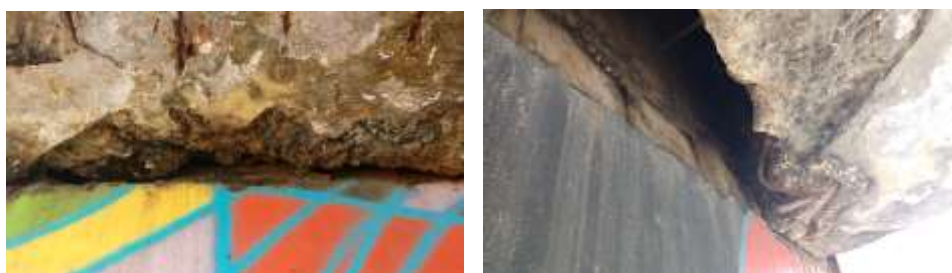
Figura 4: Deterioração do concreto sob a ponte
