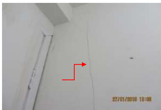
Figura 14: Fissura vertical na parede do estacionamento.
