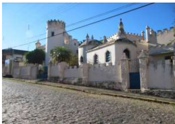
Figura 1: Vista parcial da fachada frontal do Castelinho (BI-1) [11].
