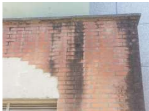
Figura 13: Biodeterioração e eflorescência na fachada Noroeste
