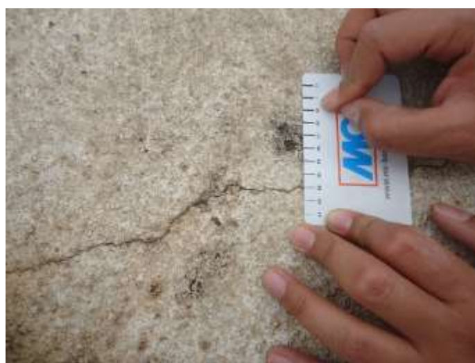
Figura 18. Fissuração máxima no Reservatório C1.
