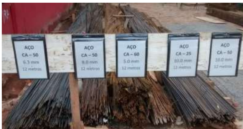
Figura 15 – Estocagem de aço.
