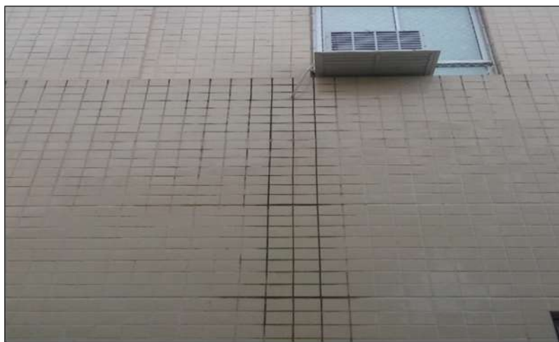
Figura 9 – Fachada desgasta pelo acúmulo de água proveniente do ar condicionado.
