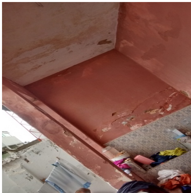
Figura 2 – Eflorescência nas Paredes Internas Fonte: Própria, 2015.
