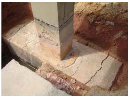
Figura 3: Fissura em bloco sobre duas estacas, com dimensões 1 x 2,5 m [20].
