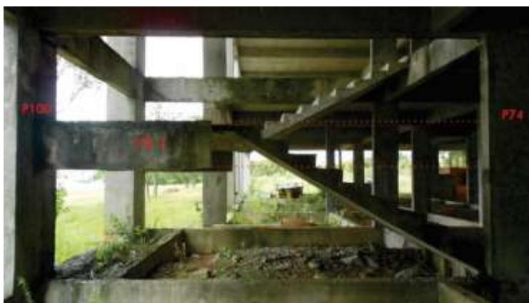
Figura 77: Vigas da escada executadas em balanço
