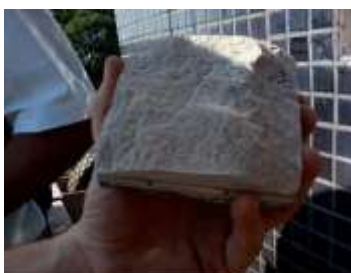
Figura 3: Rompimento no interior da argamassa de substrato (argamassa industrializada)
