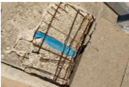
Figura 7: Corrosão nas armaduras do piso sobre o passeio
