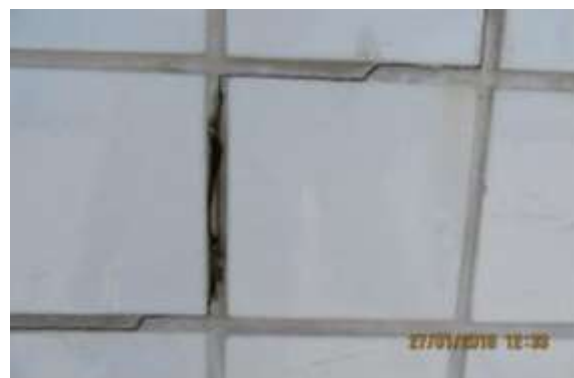
Figura 25: Rejuntamento da fachada fissurado.
