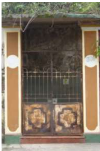
Figura 51: Vista do portão de acesso, com oxidação e corrosão. Fonte: (MOREIRA, IUNES, PINHEIRO, 2013, p.60)
