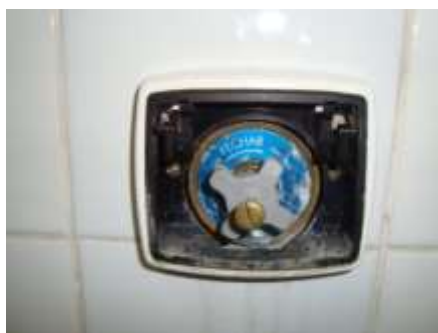
Figura 5: Válvula de descarga sem canopla protetora e com sinais de vazamento no AT5
