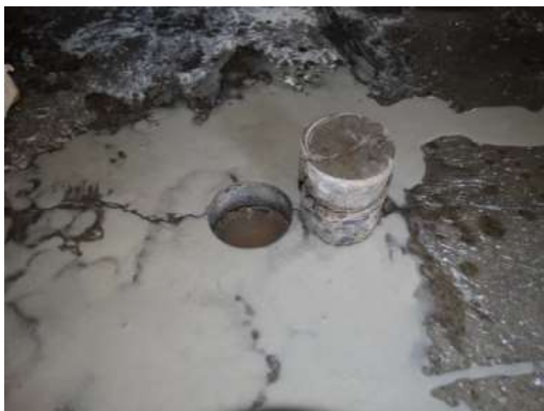
Figura 12 - Testemunho de áreas com som cavo.
