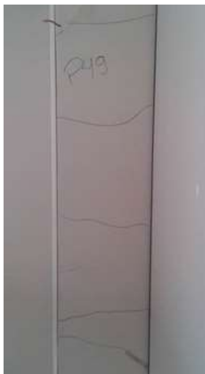
a) Fissuras de Flexão
