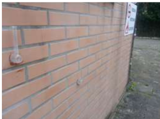
Figura 3: Ensaio de permeabilidade de água
