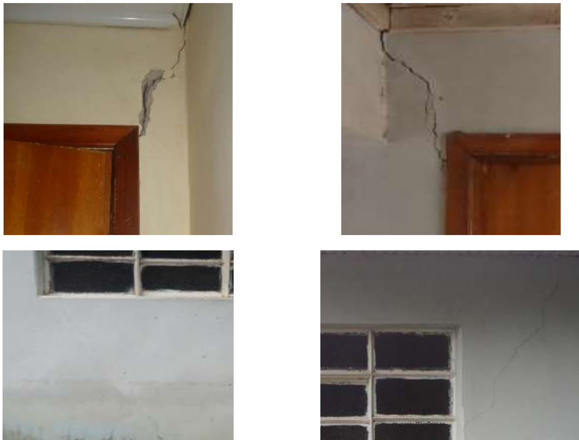
Figura 6 – Manifestações patológicas encontradas na ampliação do dormitório
