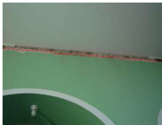
Figura 11: Área interna - Fissuras, manifestações patológicas do revestimento e umidade.
