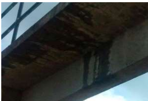
Figura 6 – Presença de fungos na superfície do concreto do Píer A.
