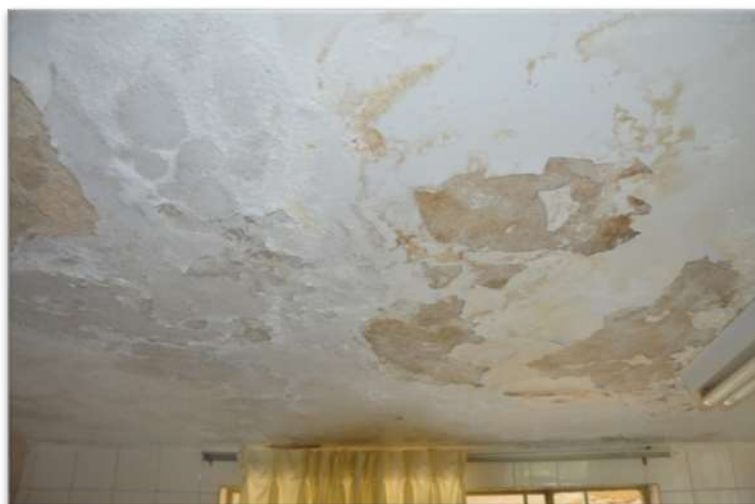
Figura 13: Eflorescências e descolamento com empolamento encontrados no teto da cozinha da Casa “J”.
