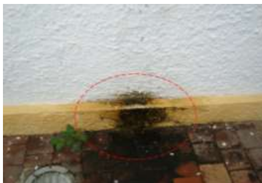
Figura 7: Fachada B - Umidade.
