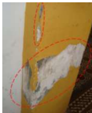
Figura 18: Área interna - Manifestações patológicas do revestimento.
