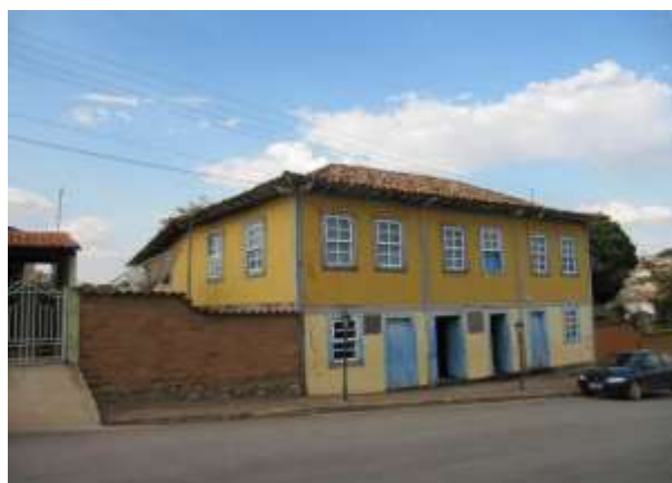
Figura 2: Vista das fachadas frontal e lateral esquerda do Sobrado Geralda Campos Romero (BI-2) [12].
