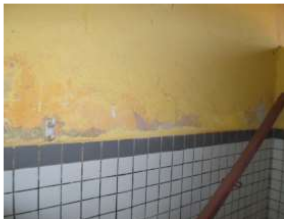
Figura 13: Descamação da pintura na escola 2.
