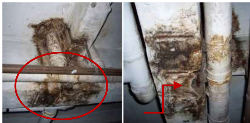
Figura 5: Vazamento em tubo de queda causando deterioração do concreto e armaduras
