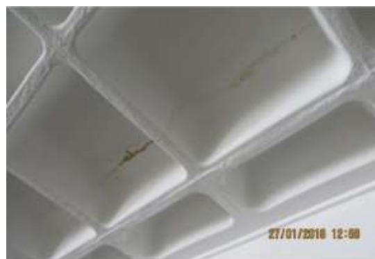
Figura 13: Manchas de corrosão e fissuras no estacionamento.
