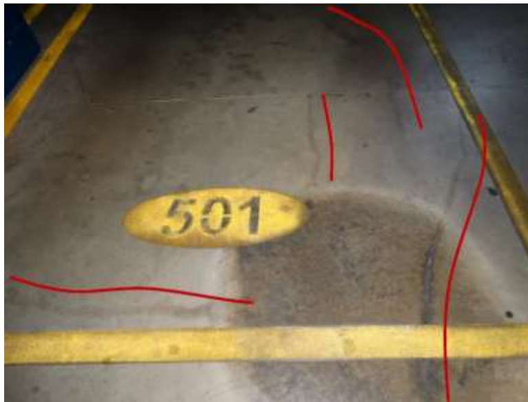
Figura 2 - Trincas e fissuras no piso da garagem.
