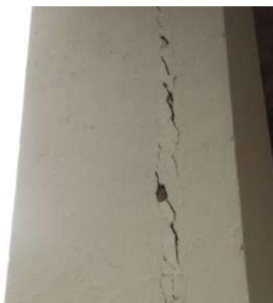
Figura 7: Fissuras Fonte: Acervo pessoal (2015).
