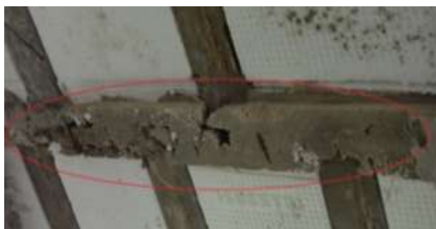
Figura 7 – Vazios de concretagem em viga do anexo B..
