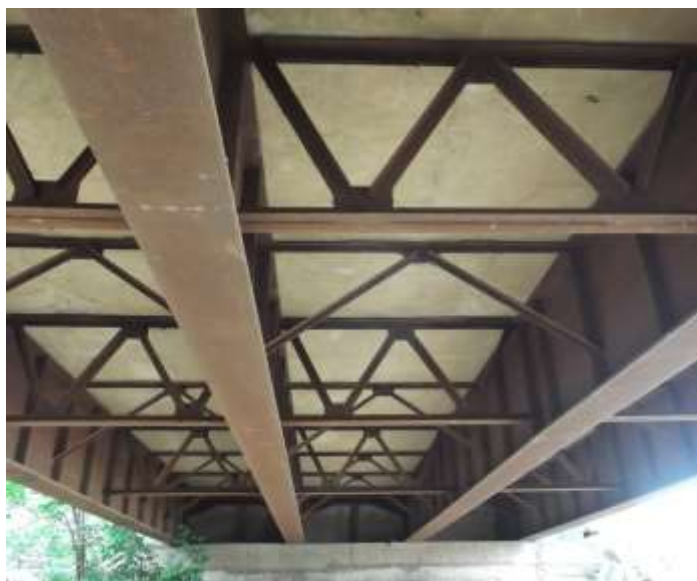
Figura 2: Superestrutura da ponte, vista inferior.
