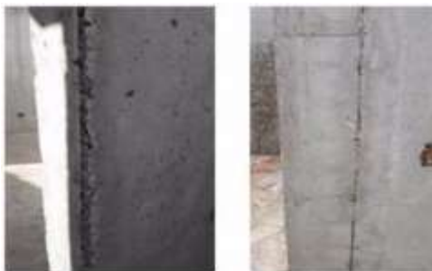
Figura 11: Manifestação patológica (10): vazamento de argamassa
