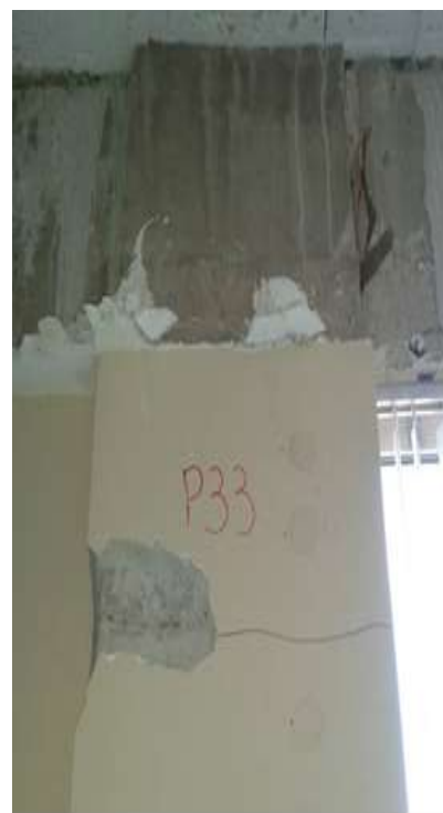
c) Deslocamento do Concreto
