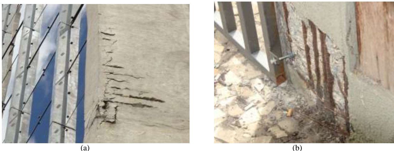
Figura 3 – Armaduras corroídas e deslocamento de concreto na fachada da edificação
