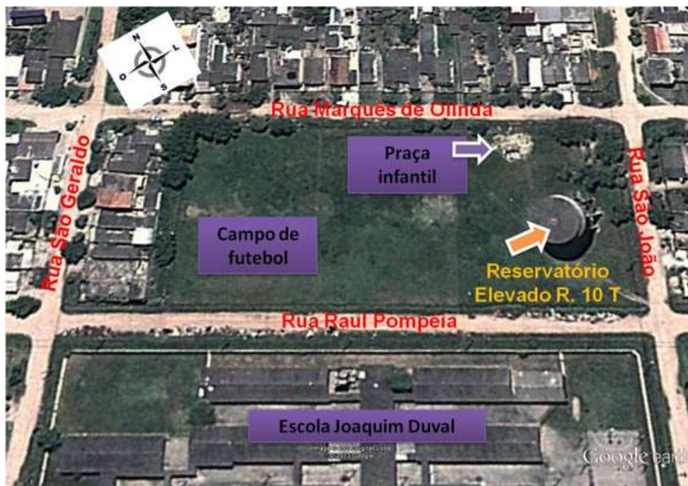
Figura 2: Localização do reservatório R10 T (GOOGLE EARTH - 2014)
