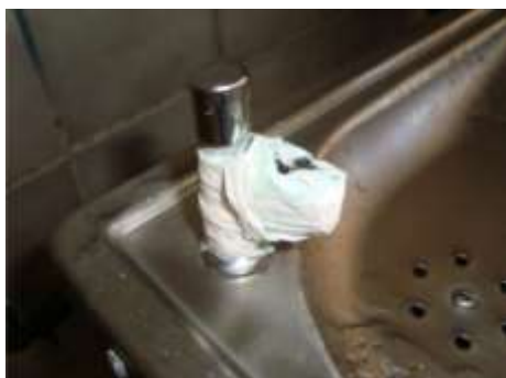
Figura 1: Torneira com presença de fita veda-rosca no AT4
