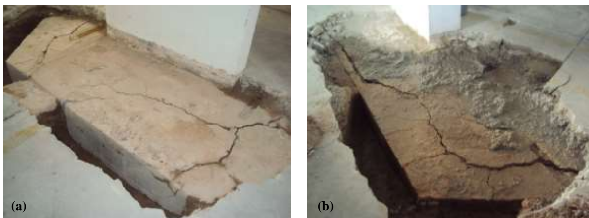
Figura 2: Fissuras características de expansão de grau 2 – F.EXP - G2 (a) e (b)
