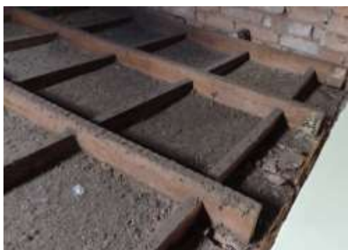
Figura 6: Vista da face superior de forro existente, evidenciando as extremidades dos sarrafos 1"x4" apoiadas na parede.
