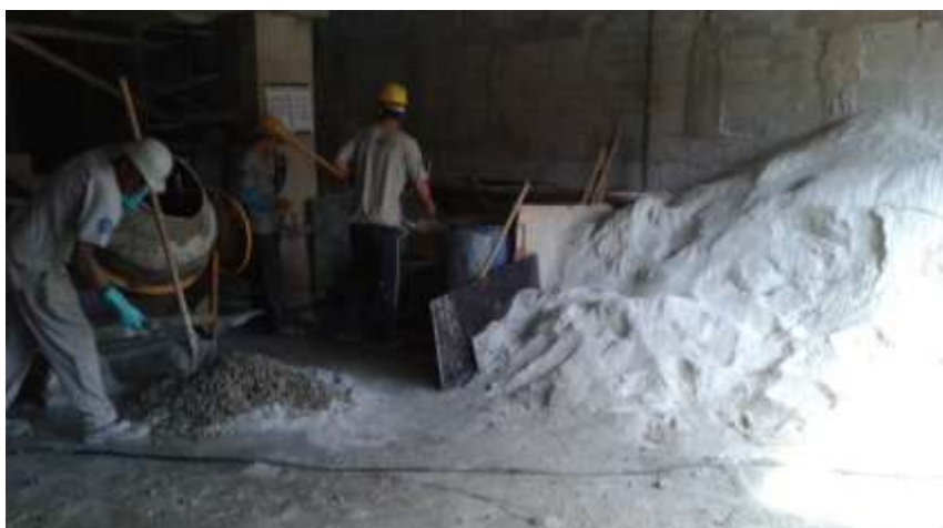
Figura 5 – Mistura de argamassa.
