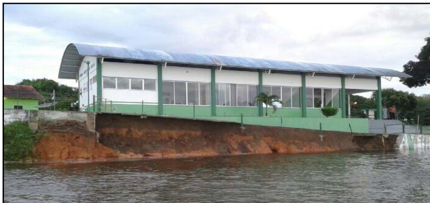
Figura 11: Vista do muro após desmoronamento. Fonte: DNIT (2014)
