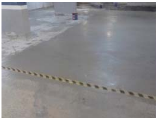
Figura 13 – Aplicação de argamassa de impermeabilização por cristalização integral.
