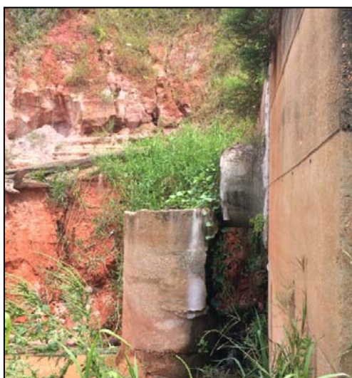
Figura 10: Vista em detalhe da erosão em área do retroporto. Fonte: DNIT (2015)
