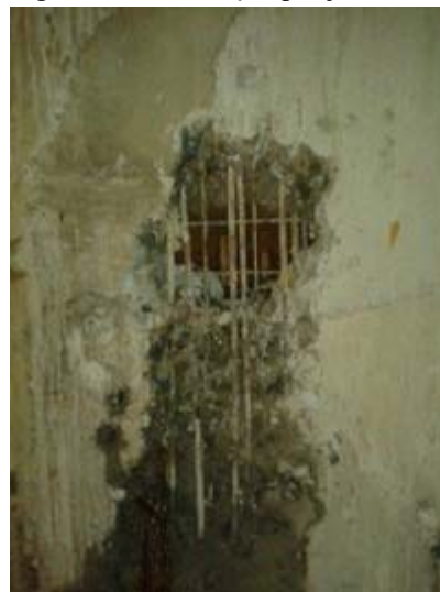
Figura 29 – Segregação do concreto na parede.
