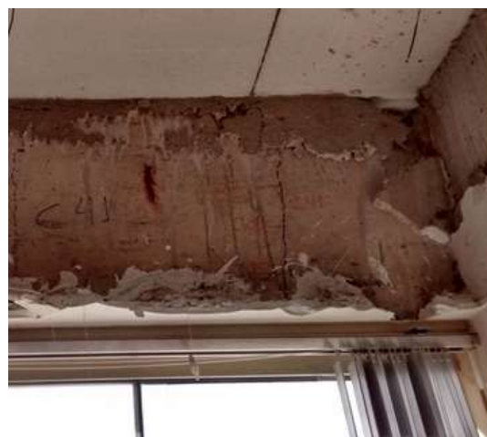
b) Nicho de Concretagem
