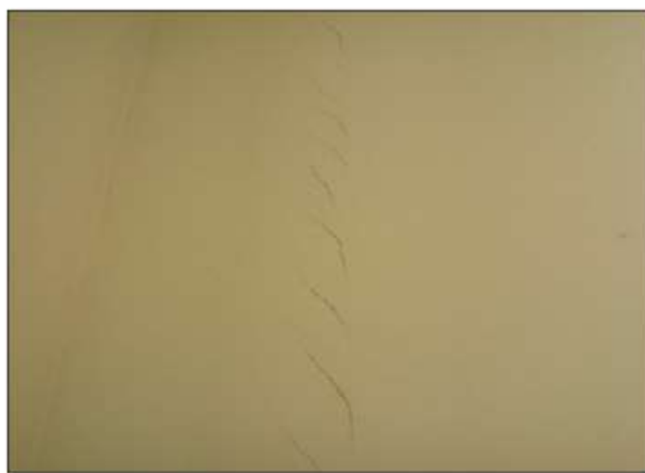
Figura 10 – Fissuras em direções aleatórias.
