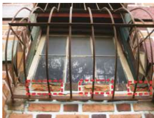
Figura 53: Perda de seção nos tijolos próximos à balsa banheiro. Fonte: (PEREIRA, 2015, p.65)
