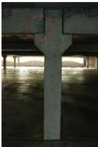
Figura 3: Fissura no canto inferior da viga – Localização
