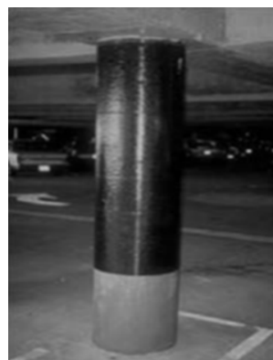
Figura A07: Reforço de pilares circular. Fonte: Machado e Machado [1].
