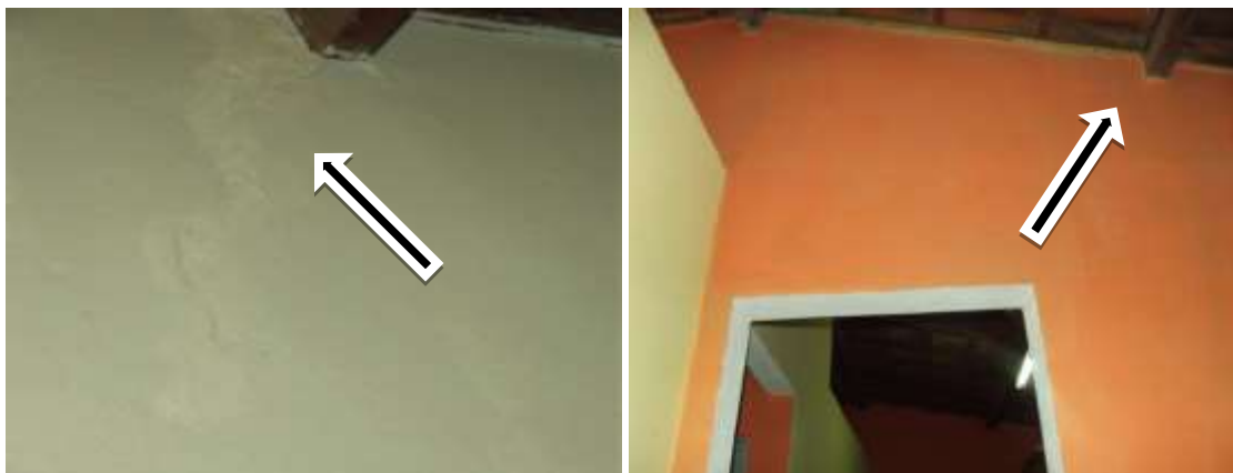
Figura 5: Fissuras ocasionadas na ligação entre estrutura - alvenaria Fonte: Acervo pessoal (2014).
