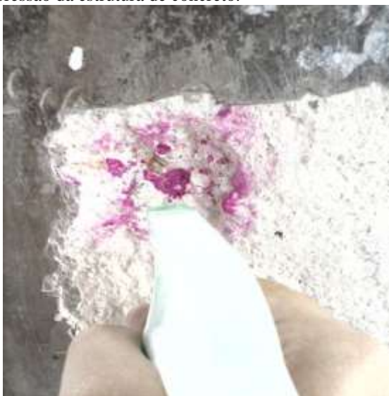
Figura 9: Peças de concreto durante a aplicação da solução de fenolftaleína
