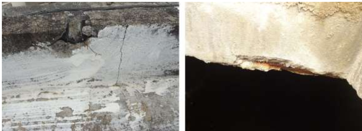
Figura 15. Desagregação do concreto e armadura em processo de corrosão no Reservatório B1.
