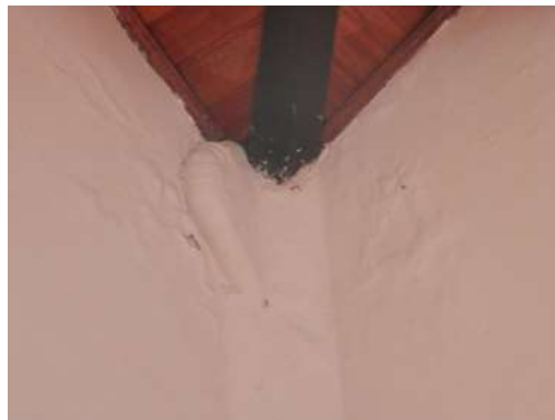
Figura 4: Manifestações patológicas decorrente de umidade. (Fonte: autores)
