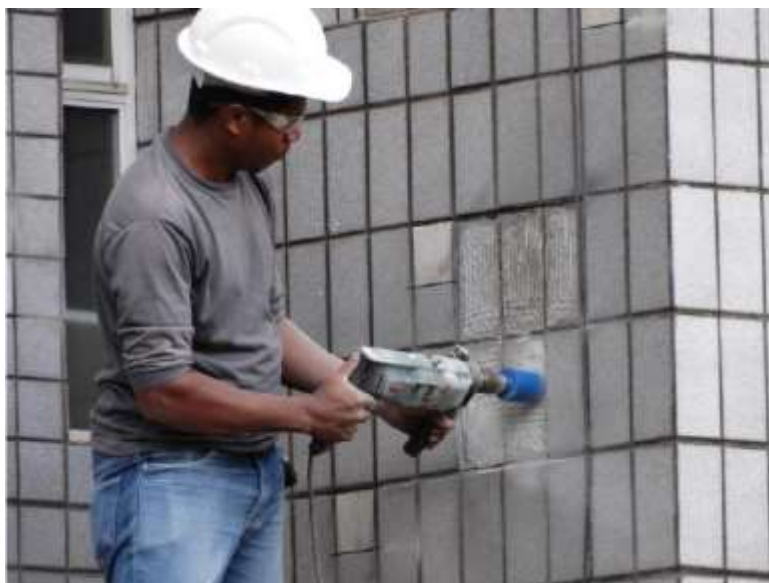
Figura 5: Execução do corte do substrato para a realização do ensaio de aderência à tração
