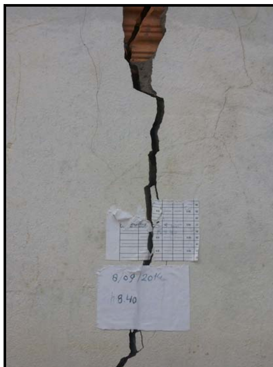
Figura 6: Trincas na parede do galpão de cargas. Fonte: DNIT (2014)
