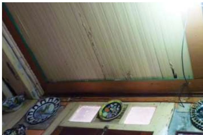
Figura 58: Forro de madeira com perda de seção devido à presença de organismos xilófagos; perda da camada pictórica; fiação exposta. Fonte: arquivo pessoal, 2015.
