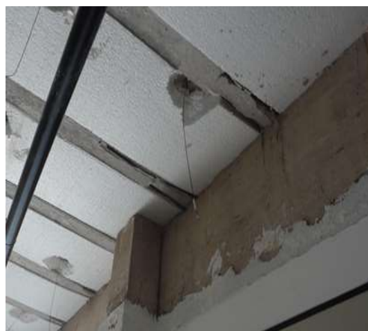
b) Armaduras da vigota exposta sofrendo corrosão.
