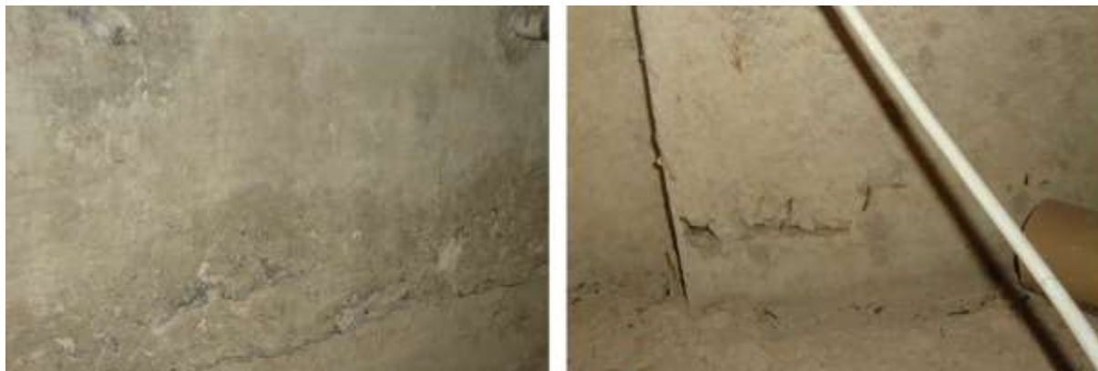
Figura 9. Ninhos de concretagem do Reservatório A2.
