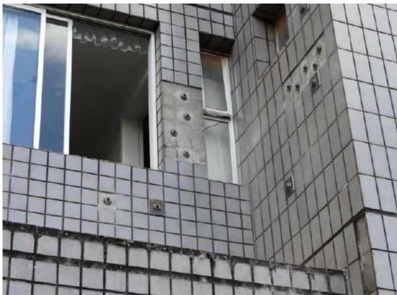
Figura 6: Execução de ensaio de aderência no reboco e no revestimento cerâmico da fachada principal - Poente 1º pavimento
