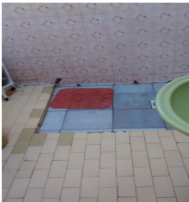
Figura 3 - Banheiro com Ação Corretiva Devido a Recalque Fonte: Própria, 2015.
