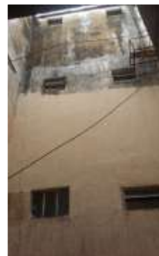
Figura 5 (a) e Figura 5 (b)- Bolores e Eflorescências.
