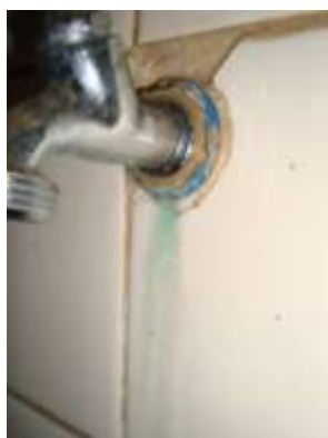
Figura 3: Torneira de limpeza com sinais de vazamento
