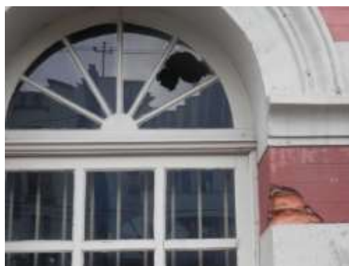
Figura 6: Perda de seção. (Fonte: autores)
