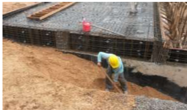
Figura 3 (a)- Compactação das paredes de contenção Figura 3 (b) - Aterro da parte externa da parede de contenção
