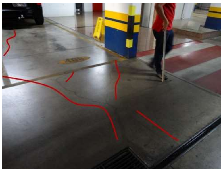
Figura 1 - Trincas e fissuras no piso da garagem.
