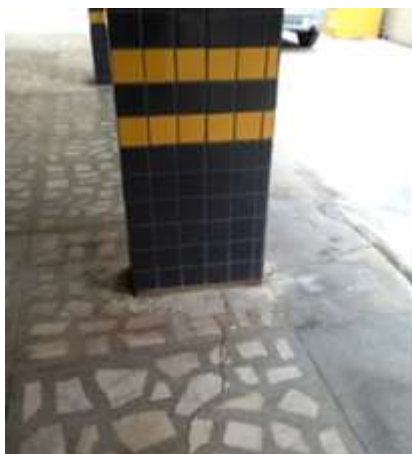
Figura 10: Fissuras radiais em torno do pilar. (Fonte: Ricardo Dolabella)
