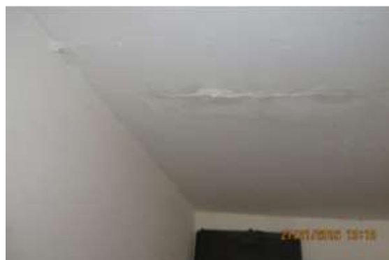
Figura 15: Fissura e infiltração na laje do estacionamento.
