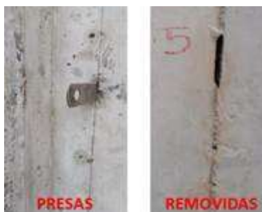
Figura 8: Manifestação patológica: danos causados pelas faquetas presas (6) e removidas (7)
