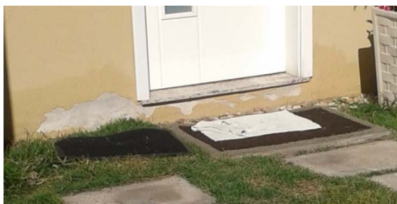
Figura 4: Desagregação da argamassa
