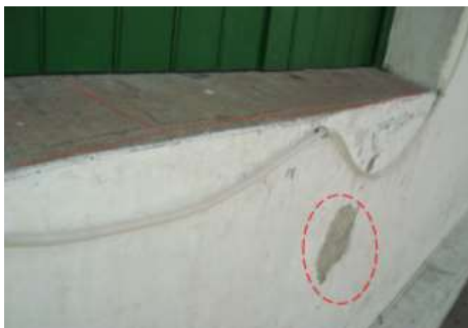
Figura 15: Fachada B – Trincas e fissuras, umidade e Manifestações patológicas do revestimento.
