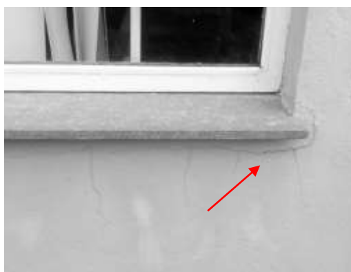
Figura 6: Caso de fissura horizontal
