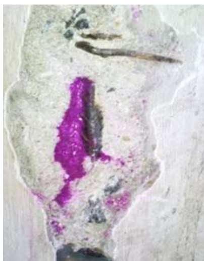
Figura 16: 2º pilar parcialmente carbonatado.
