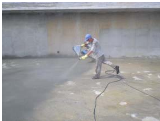
Figura 9 – Projeção da argamassa de impermeabilização por cristalização.
