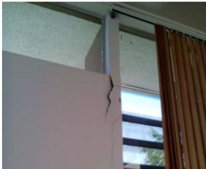
Figura 6: Fissuras no engaste dos brises de concreto. Fonte: Acervo pessoal (2015)
