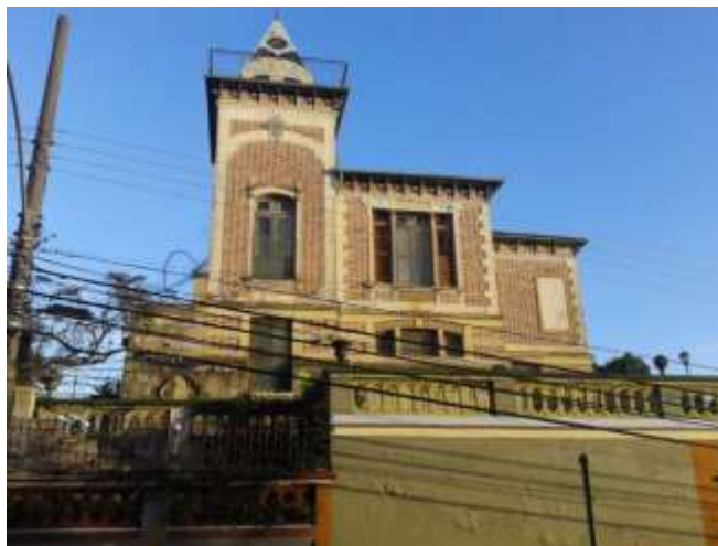
Figura 46: Fachada Frontal do Castelhinho dos Bracher. Fonte: acervo pessoal, 2015.
