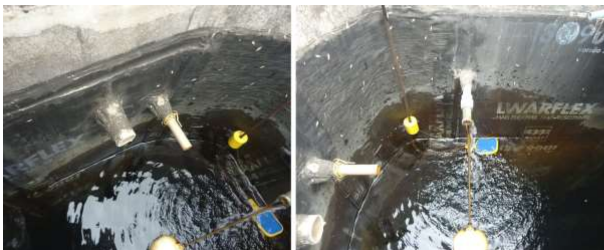
Figura 11. Impermeabilização com manta asfáltica em reservatórios.
