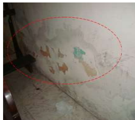
Figura 20: Área interna - Manifestações patológicas no revestimento e umidade.
