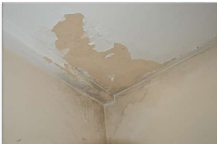
Figura 8: Bolor e descolamento com empolamento encontrados na sala da Casa “J” (próximo à calha).
