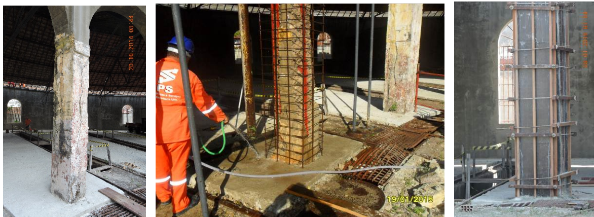
Figura 22: Processo de execução dos serviços de reparo dos pilares da rotunda.
