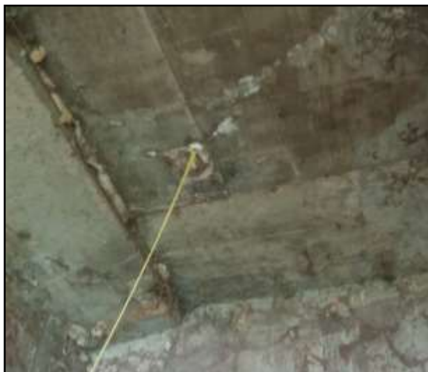
Figura 10: Eflorescência na parte inferior dos tabuleiros
