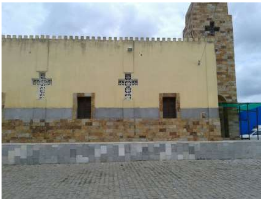
Figura 05: Alteração de coloração da pedra na fachada
