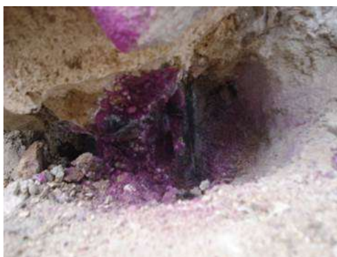
Figura 1 – Vista do ataque da frente de carbonatação na ferragem do pilar P4.
