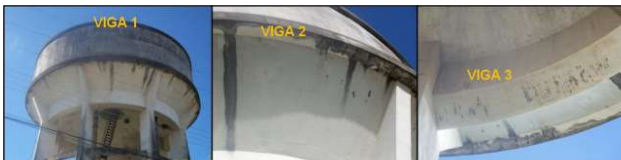
Figura 4: Manifestações patológicas nas vigas superiores (AUTORA)
