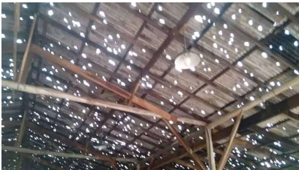
Figura 01: Telhado com telhas de fibrocimento danificado pela chuva de granizo.
