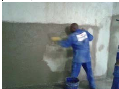
Figura 32 – Aplicação de argamassa de impermeabilização por cristalização integral.
