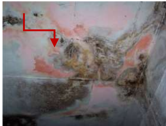
Figura 4: Local com presença de bolores
