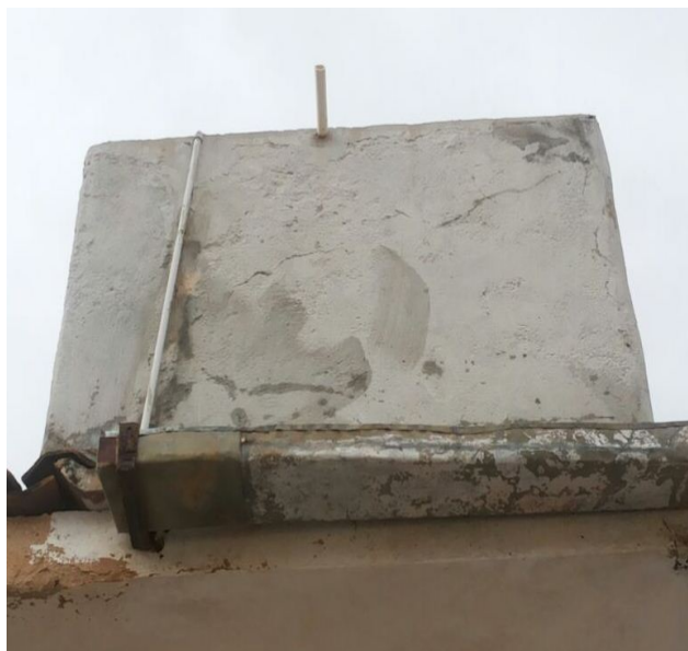
Figura 4 - Reservatório com Vazamento Fonte: Própria, 2015.
