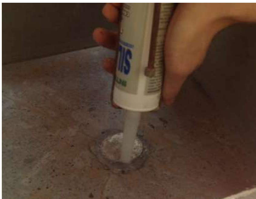
Figura 7: Vedação com silicone.
