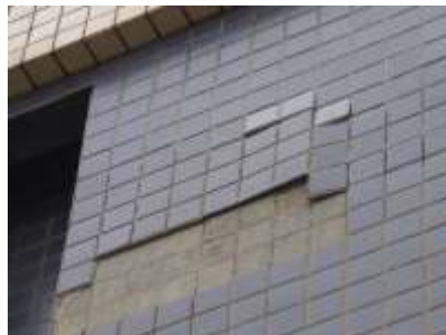
Figura 26: Deslocamento de revestimento cerâmico em fachadas [7].
