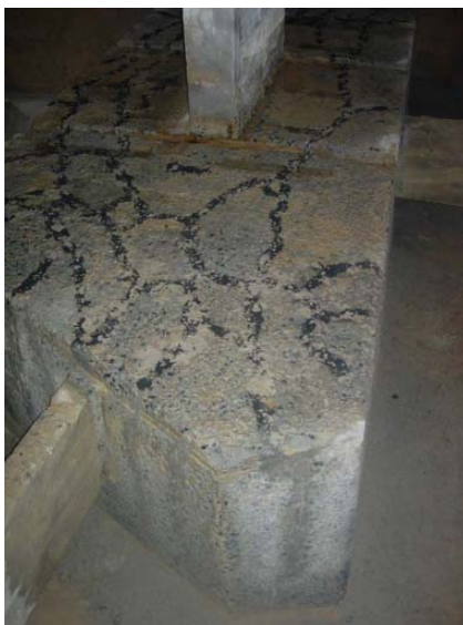
Figura 7: Bloco de fundação com fissuras já preenchidas [20].
