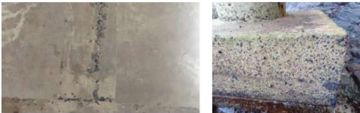
Figura 3 – Lixiviação do concreto no Píer A (esquerda) e no Píer D (direita).
