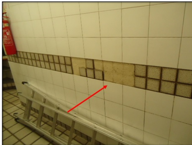
Figura 9: Descolamento de revestimento cerâmico
