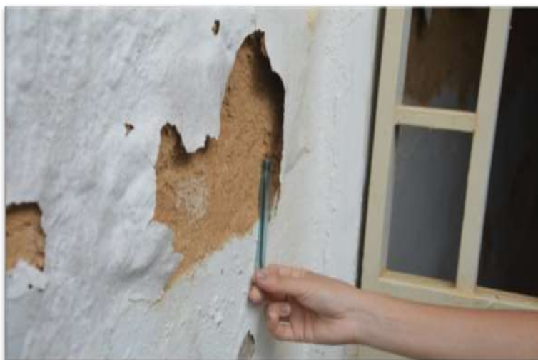
Figura 5: Descolamento com empolamento encontrado na fachada da Casa “G”.
