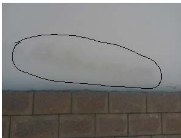
Figura 05: Mancha na igreja de Angicos/RN Fonte: Acervo dos autores
