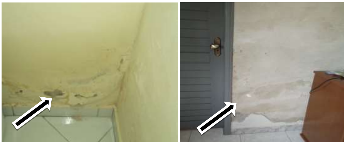
Figura 14: Desagregação de revestimento – Ascensão capilar Fonte: Acervo pessoal (2014).
