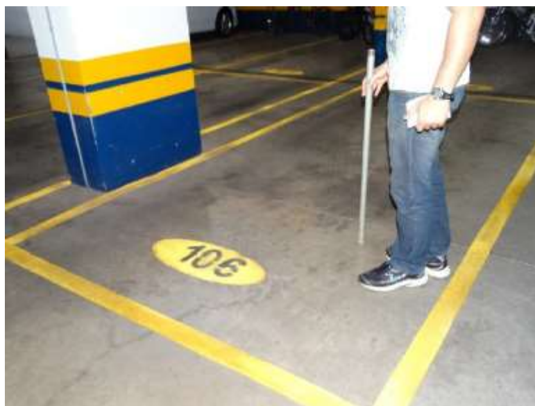
Figura 7 – Realização do ensaio de percussão.
