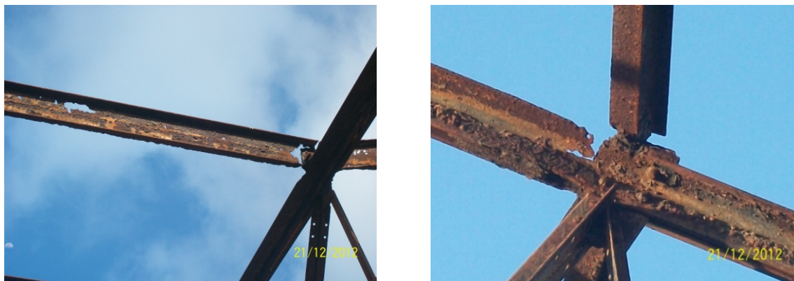
Figura 19: Detalhes de trechos com seccionamento da alma dos perfis por perda de seção do aço.
