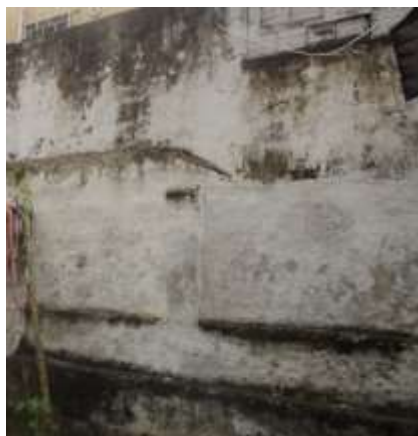
Figura 8: Manchas escuras de mofo, bolor em áreas mais expostas e encardimento da superfície Fonte: Acervo pessoal (2015).
