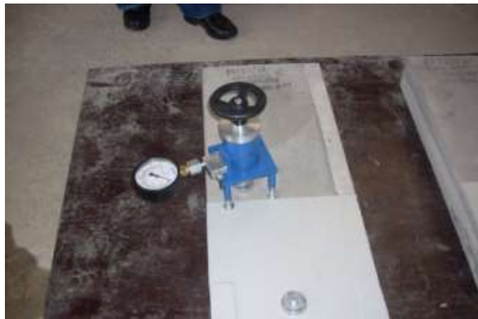
Figura 10 - Realização do teste de arrancamento (Recuperação Engenharia, 2008).
