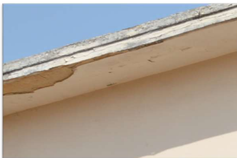
Figura 9: Descolamento em placa e bolor encontrados na fachada da Casa “J”
