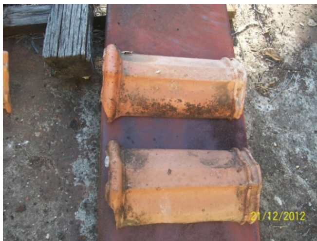
Figura 13: Detalhe de peças de cumeeira existente.
