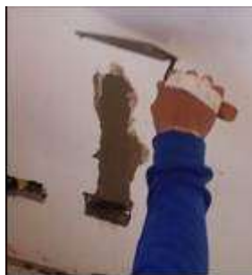
Figura 14: Aplicação do tratamento de eletroduto exposto
