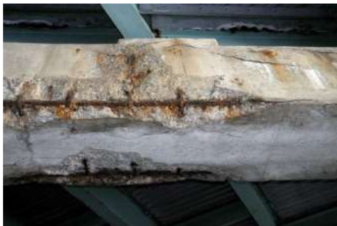
Figura 2: Verificação de corrosão causada por ataques de ions de cloreto [14]
