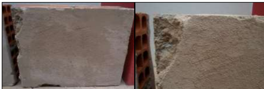
Figura 24: Desgaste das arestas da argamassa com saibro
