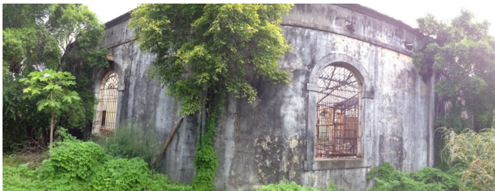
Figura 16: Vista da fachada posterior (Fonte: acervo MULTITECH, 2012).
