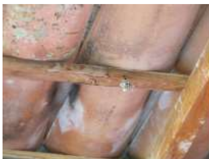
Figura 7: Detalhe da porção inferior da cobertura sobre a varanda em frente ao subsolo. Notam-se manchas nas telhas e na estrutura de madeira, além da presença de uma colmeia de inseto fixada na estrutura [14].
