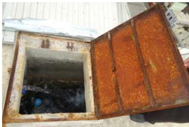
Figura 7. Corrosão da tampa do Reservatório A1.
