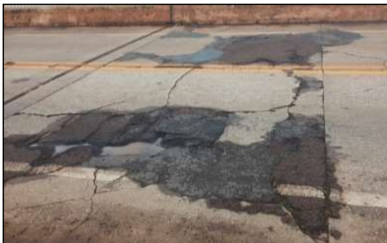
Figura 7: Irregularidades da pista de rolamento
