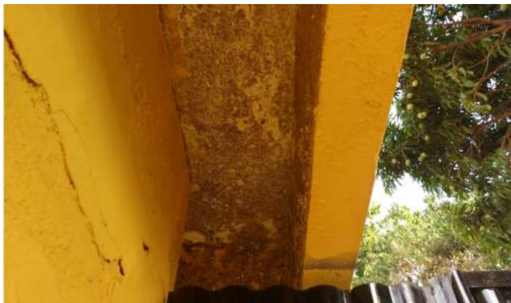
Figura 3: Patologia causada por umidade (área externa)
