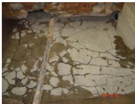
Figura 4: Fissura em bloco com 18 estacas, com dimensões 8 x 6 m [20]
