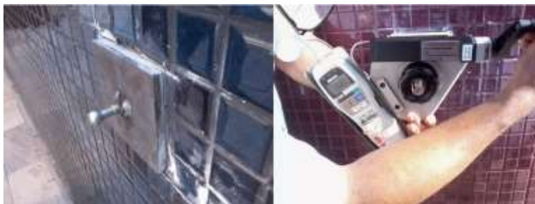
Figura 2 - Placa metálica e aparelho para ensaio de resistência de aderência
