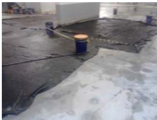
Figura 14 – Cura úmida da argamassa de impermeabilização por cristalização integral.
