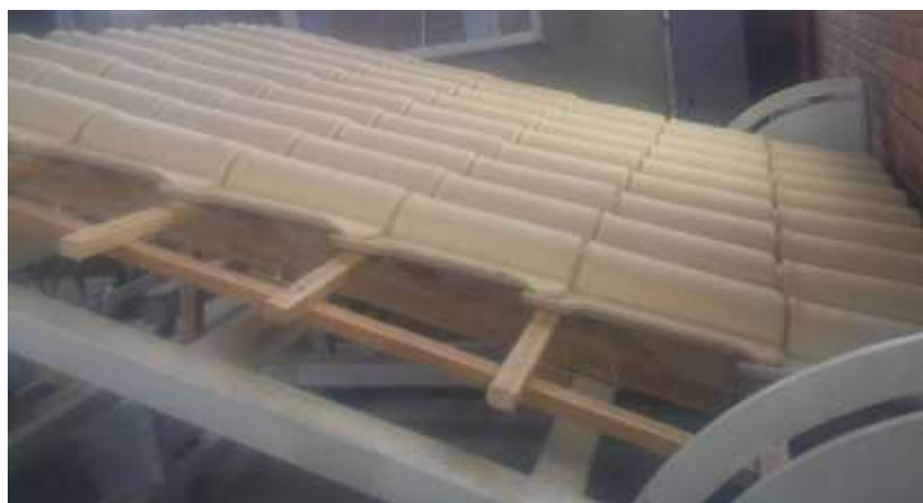
Figura 2 – Sistema de cobertura com telha cerâmica montada.
