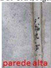
Figura 5: Manifestação patológica (3): falha de concretagem tipo C
