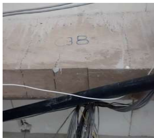
b) Fissuras de Retração
