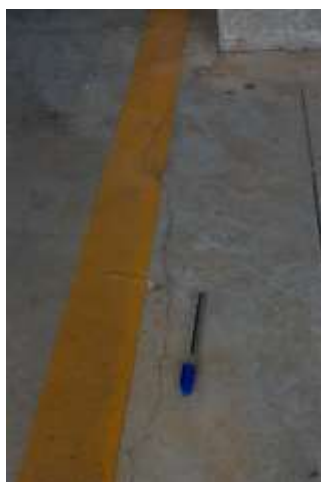
Figura 9: Fissura iniciando na extremidade do pilar
