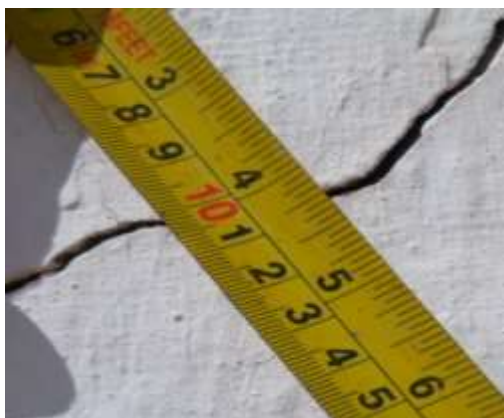
Figura 6: Trincas nas paredes na escola 1.
