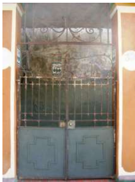
Figura 50: Vista do portão de acesso, com oxidação e intervenção na parte inferior, com a troca das folhas corroídas. Fonte: (PEREIRA, 2015, p.65)
