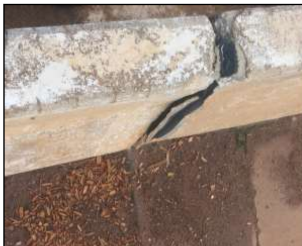
Figura 6: Acúmulo de detritos na junta de dilatação
