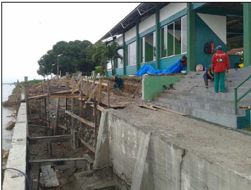
Figura 14: Reconstrução de muro de arrimo para contenção permanente do talude. Fonte: DNIT (2015)
