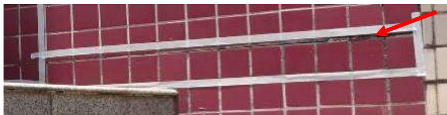
Figura 9 – Rejunte com fissura e perda de massa.
