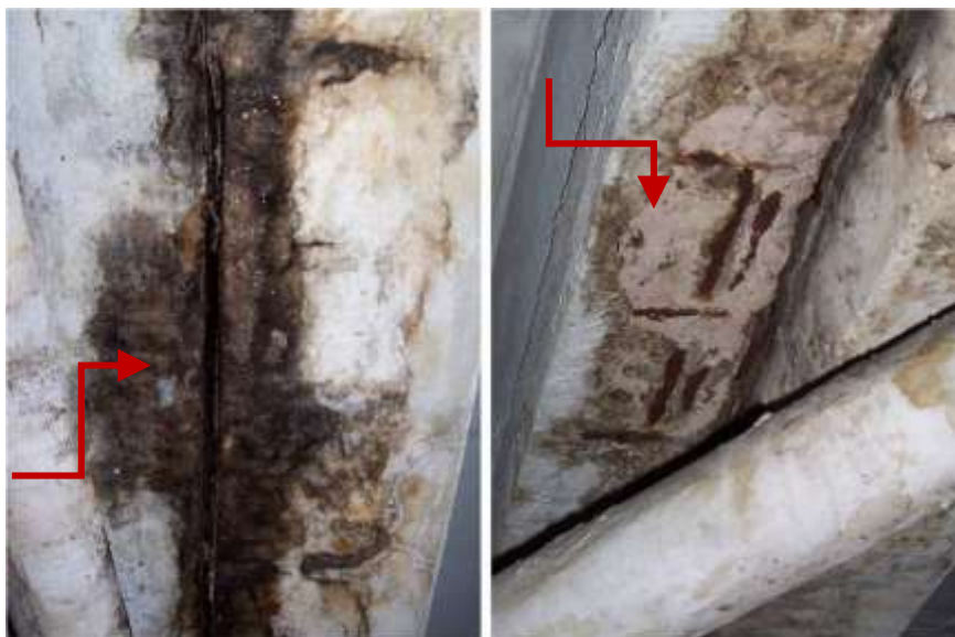
Figura 6: Presença de umidade na junta de dilatação com deterioração do concreto e oxidação das armaduras da viga
