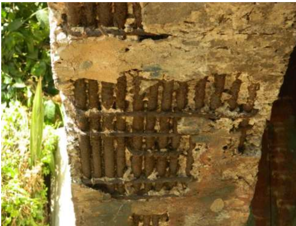
Figura 3: Exposição e corrosão de armadura longitudinal
