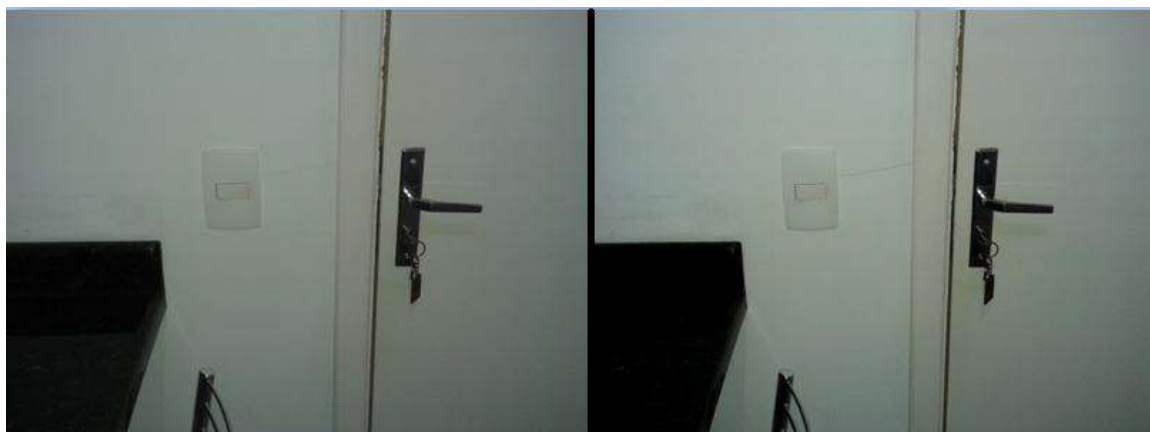
Figura 9: Fissura entre batente e interruptor Bloco 05/Apt.34
