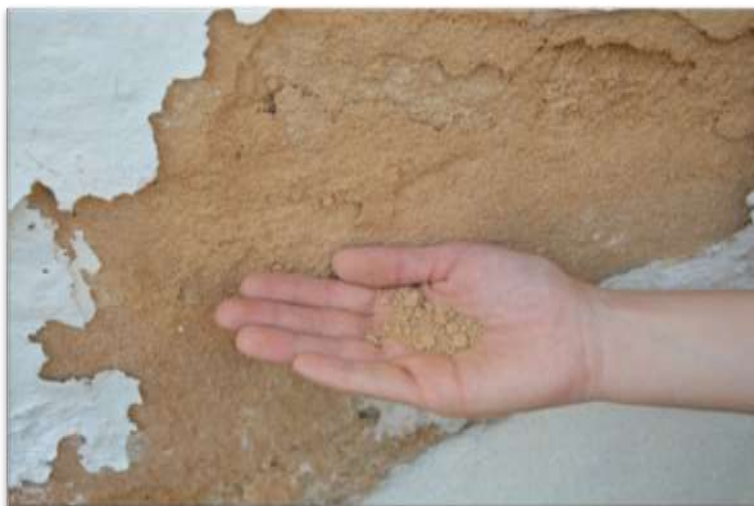
Figura 4: Descolamento com pulverulência encontrado na fachada da Casa “G”.
