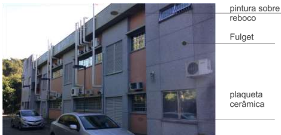
Figura 3: Especificação de revestimentos externos
