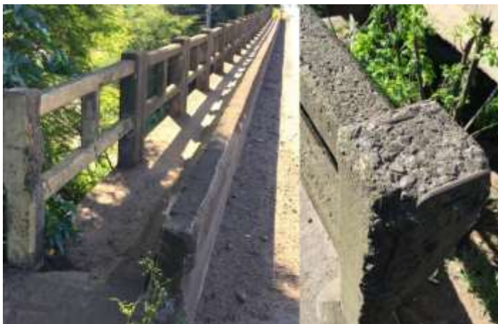
Figura 8: Deterioração do guarda corpo.
