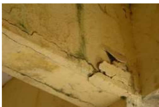
Figura 4 Corrosão da viga lado B.
