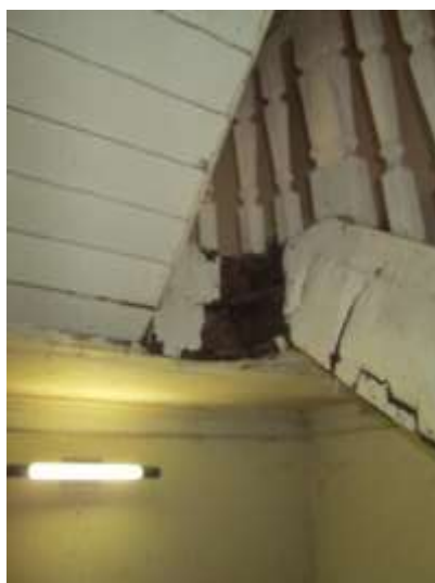
Figura 41: Estrutura da escada de madeira deteriorada.
