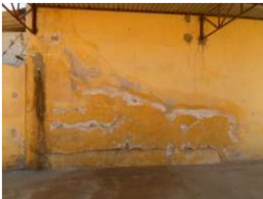
Figuras 3: Eflorescência na alvenaria da escola 2.
