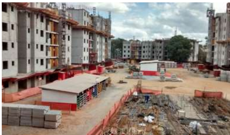
Figura 9 – Canteiro de Obras.
