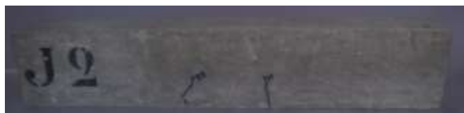
Figura 10: Viga J2 após Pré-Fissuração
