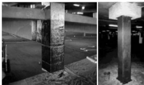
Figura A06: Reforço de pilares quadrados. Fonte: Machado e Machado [1].
