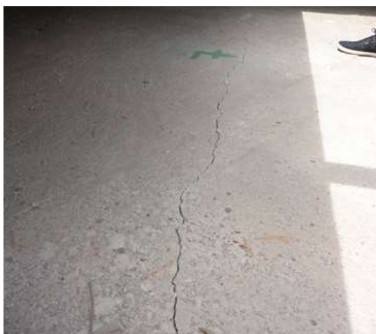
a) Fissura na região da armadura negativa entre laje e viga da cobertura.
