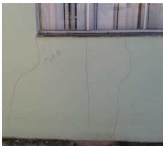
b) Fissuras no vão de janela
