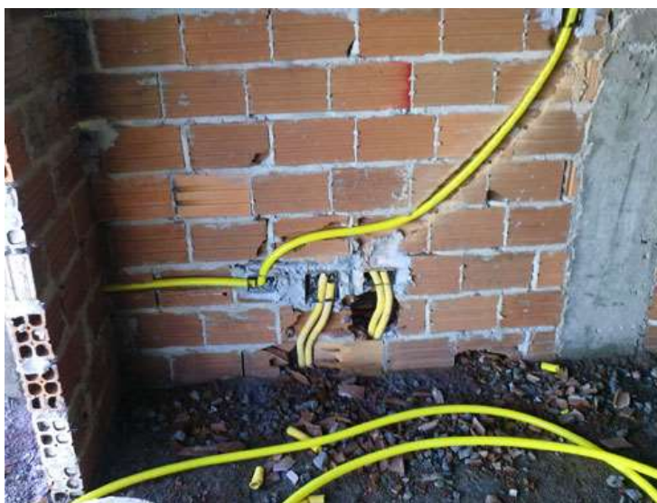
Figura 7: Rasgos para passagens de tubulações de instalações [19]
