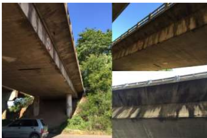
Figura 7: Infiltrações.
