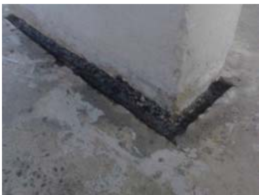
Figura 11 – Abertura de canaleta para reparo com argamassas de cristalização.
