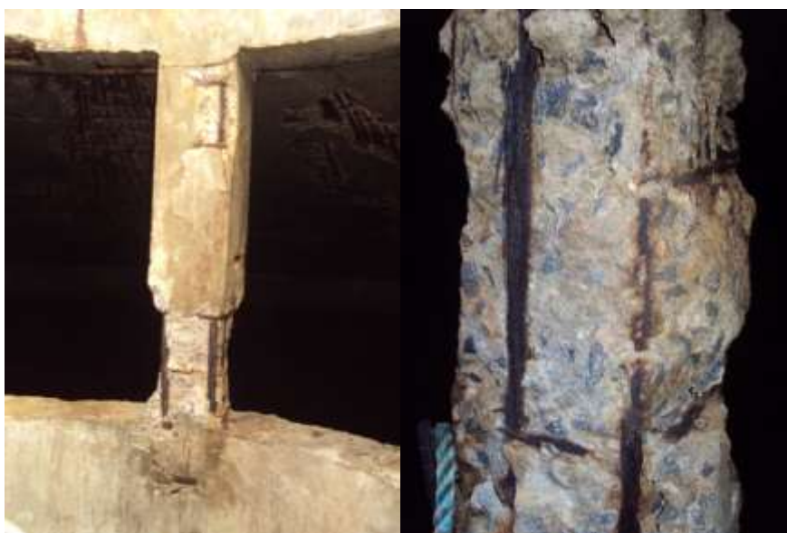
Figura 6 – Corrosão das armaduras dos pilares de sustentação da laje de cobertura do REL do SAA da cidade de Carpina denominado R-2.
