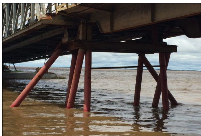
Figura 8: Apoios da ponte de acesso defeituosos e ligações soldadas foram rompidas. Fonte: DNIT (2015)
