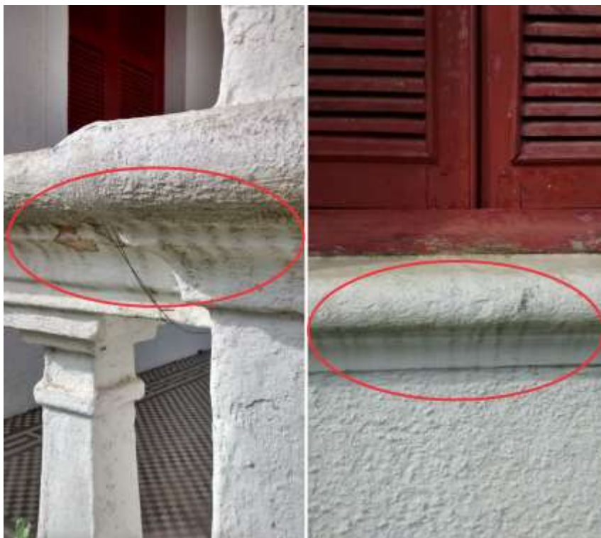
Figura 5: Sujidades no guarda-corpo da varanda e peitoril de janela
