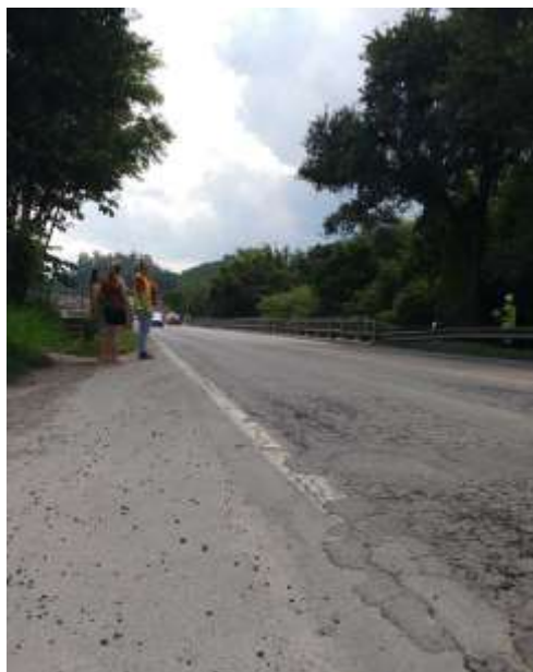
Figura 4: Registro fotográfico da pista de rolamento.
