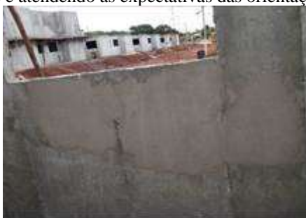
Figura 12: Aplicação do tratamento das falhas de concretagens tipos A e B
