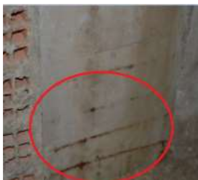
Figura 8 – Trechos em que o pilar do anexo B está com a armadura exposta por falta de cobrimento.
