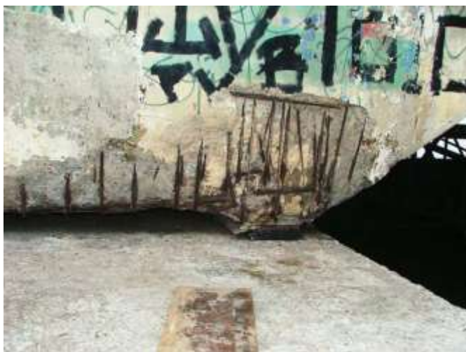
Figura 2: Armadura exposta apresentando corrosão [11]
