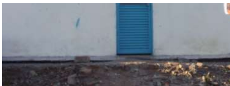
Figura 4: Fundações em radier com trechos em balanço Fonte: Acervo fotográfico dos autores (2012)
