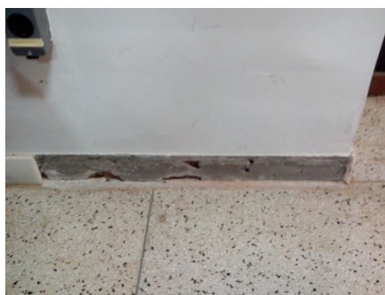
• Figura 1. Descolamento cerâmico do rodapé.
