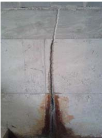
Figura 28 – Fissura com infiltração e carreamento de solo.
