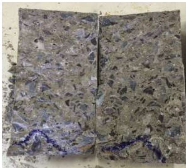
Figura 8: Penetração de água no CP de 50 MPa
