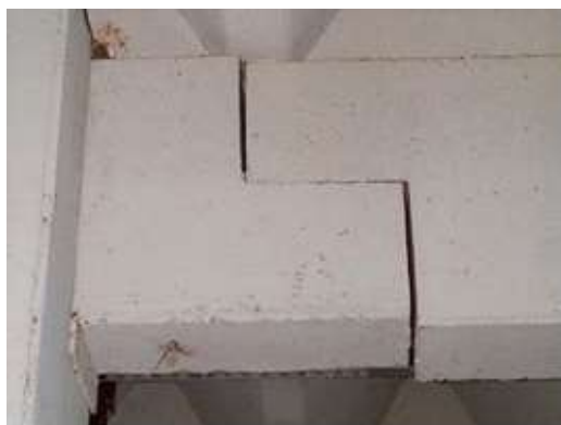
Figura 3: Viga com dente gerber
