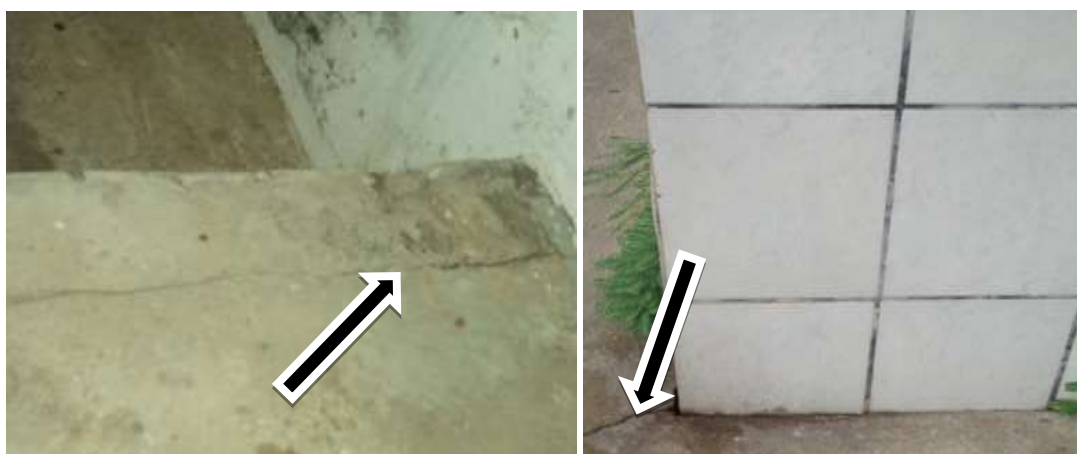
Figura 6: Fissuras horizontais em piso causada por movimentação higroscópica Fonte: Acervo pessoal (2014).
