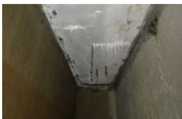
Figura 19: Pontos de estalactites e corrosão de armadura.
