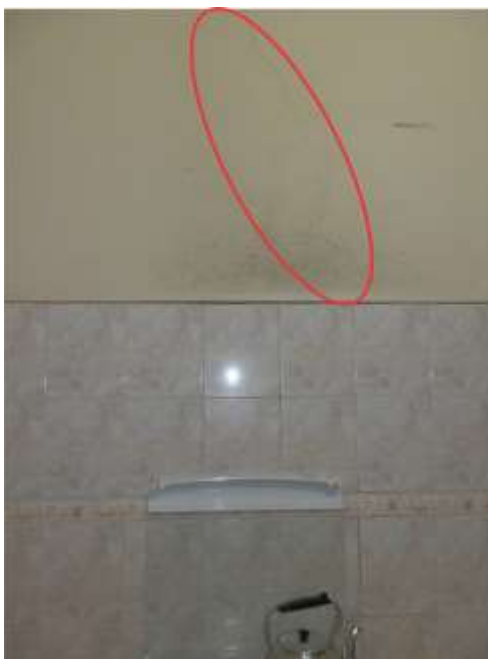
Figura 14: Fissura em revestimento de argamassa, em cima do fogão.
