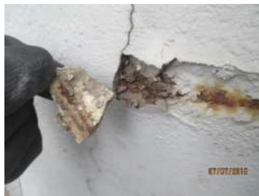
Figura 3: Deslocamento do cobrimento de concreto por corrosão das armaduras, em pontos aleatórios, na face externa do reservatório.
