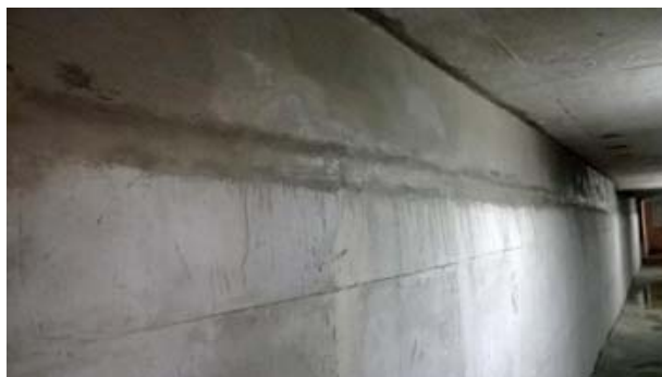
Figura 31 – Tratamento em junta de concretagem com argamassas de reparo estrutural com cristalizante.
