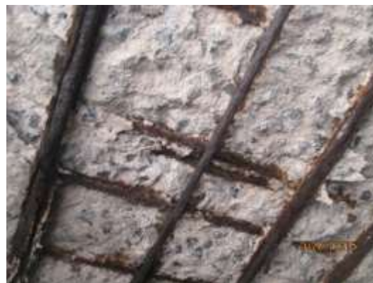
Figura 7: Laje de cobertura das células 2 e 1 com corrosão grave das armaduras, de forma generalizada, inclusive com perda de seção e seccionamento das barras de aço em alguns pontos.
