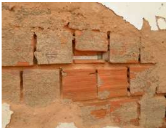
Figura 4: Degradação do reboco na escola 1.
