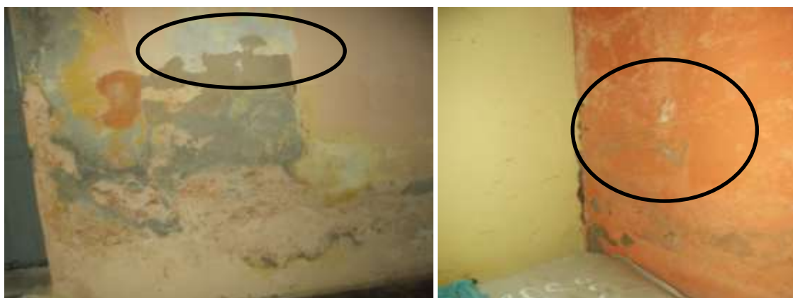
Figura 8: Eflorescência em paredes próximas ao banheiro Fonte: Acervo pessoal (2014).
