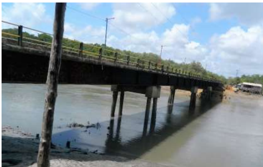
Figura 3: Ponte sobre o Furo Grande Fonte: acervo dos autores
