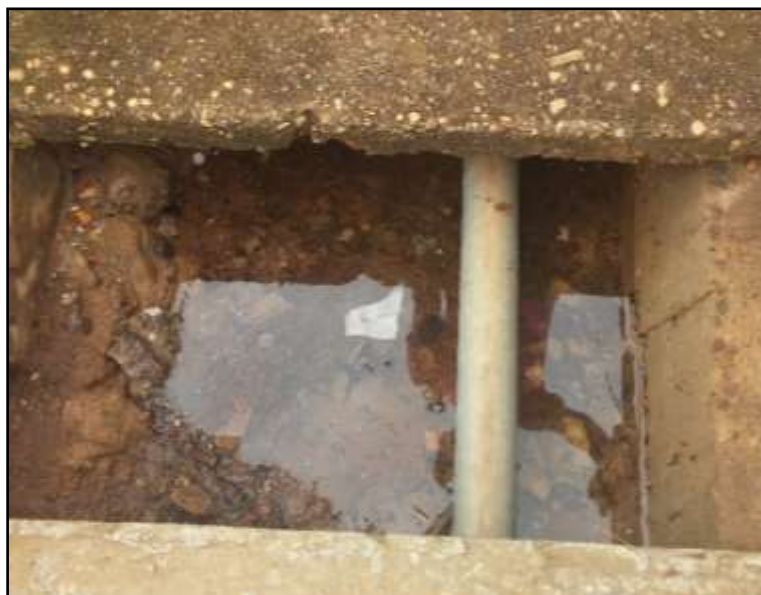
Figura 15: Acúmulo de água junto aos dutos
