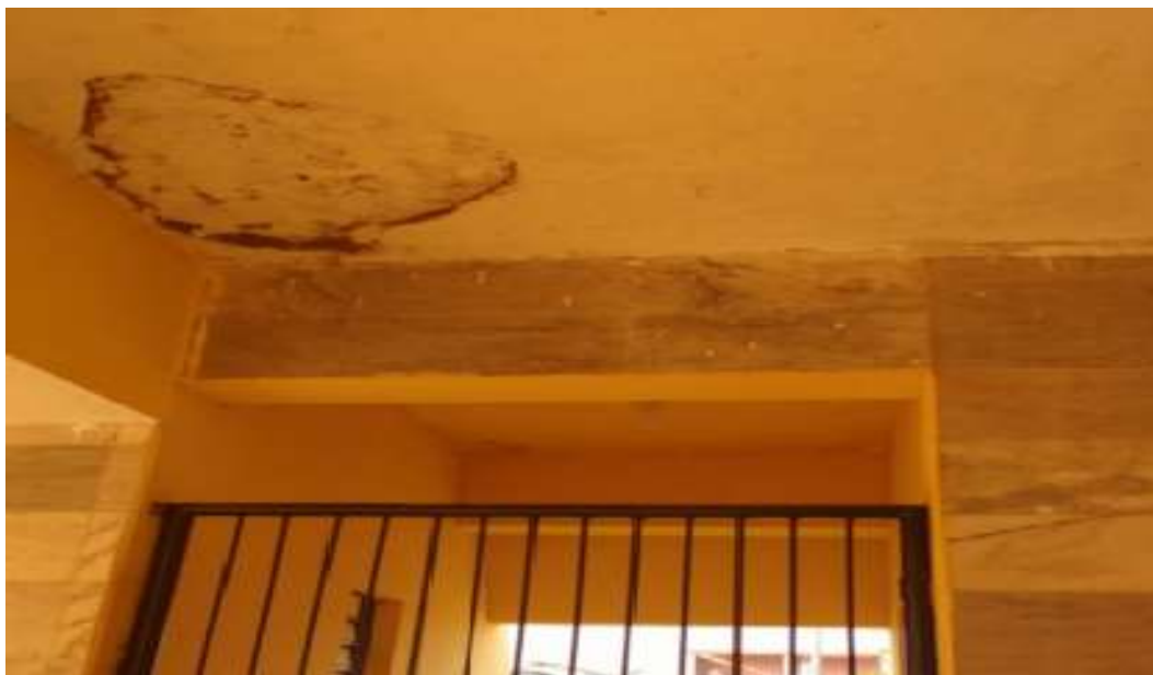
Figura 4: Deslocamento no revestimento da laje na bilheteria
