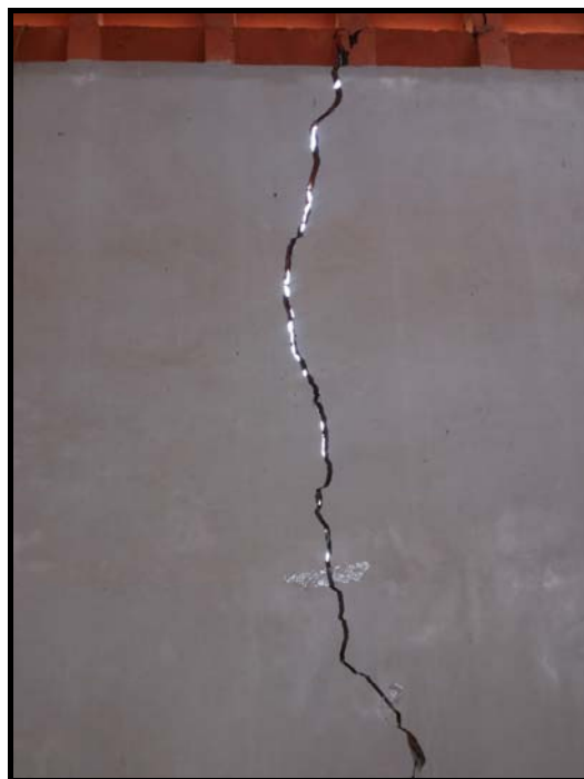
Figura 5: Surgimento de trincas no galpão de cargas da infraestrutura portuária. Fonte: DNIT (2014)
