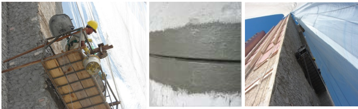
Figura 6- Remoção de pastilhas e reboco existentes na fachada, com refazimento do reboco e detalhe da junta de movimentação.
