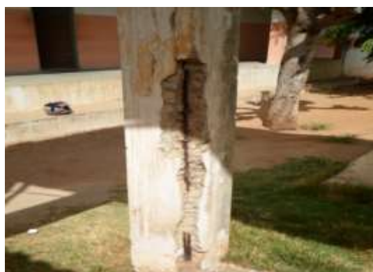
Figura 11: Corrosão da armadura na escola 1.
