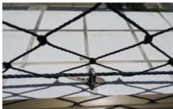
Figura 21: Perfurações inadequadas para fixação de telas.
