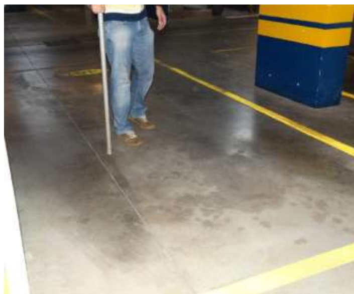
Figura 9 - Realização do ensaio de percussão.
