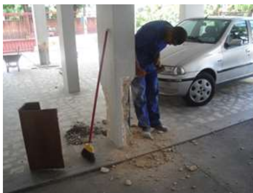
Figura 11: Remoção do concreto em desagregação. (Fonte: Reitec)
