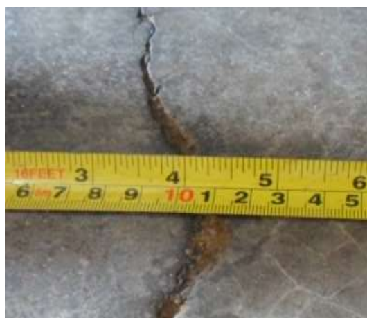
Figura 9: Trincas no piso na escola 3.
