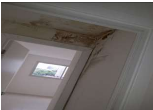
Figura 6 – Infiltração
