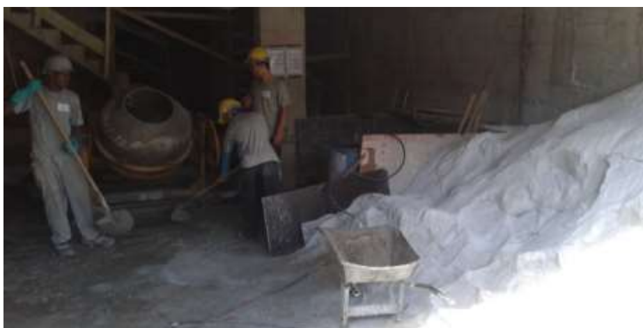
Figura 4 – Estocagem de areia e distância até a betoneira.
