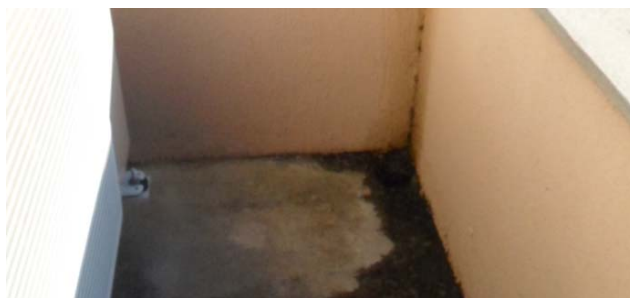
Figura 6: Mancha de umidade
