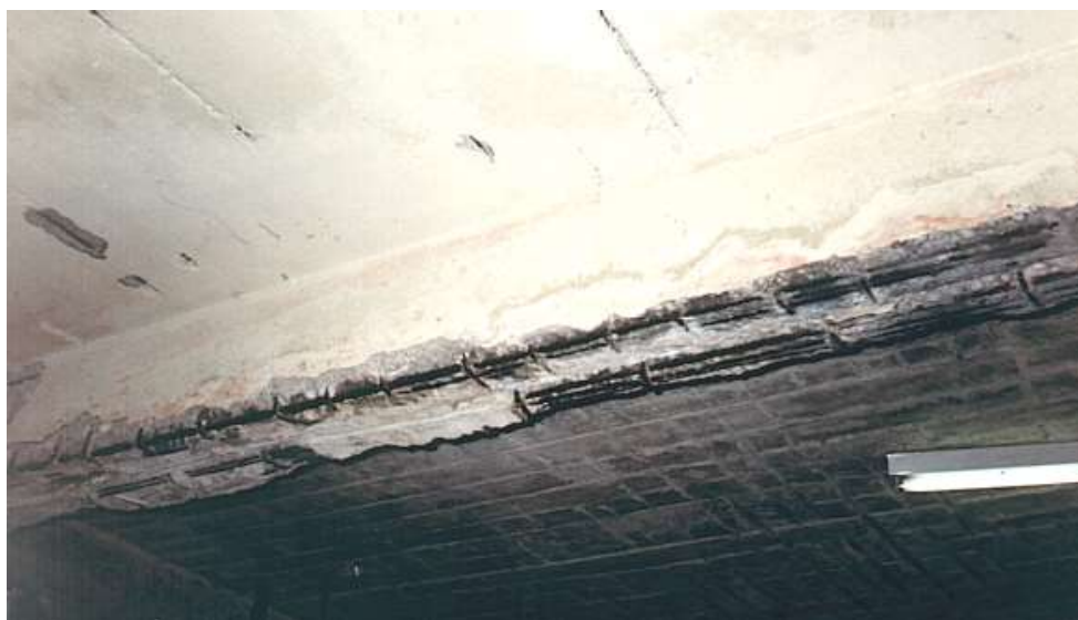
Figura 4: Infiltração pela junta de dilatação como causa da corrosão das armaduras
