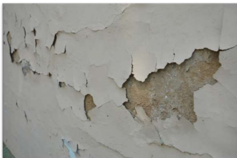
Figura 12: Descolamento com empolamento encontrado na fachada da Casa “J”.
