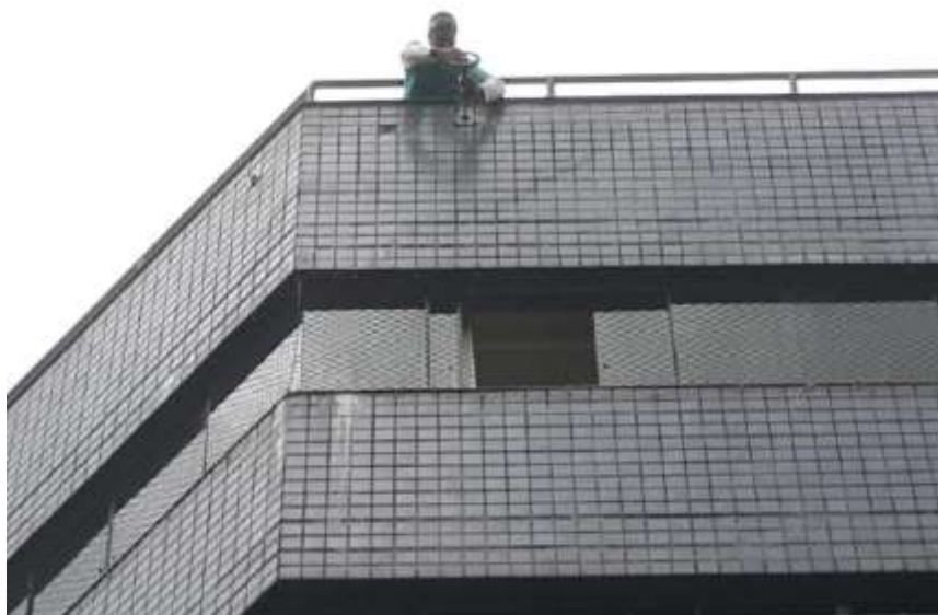
Figura 7: Execução de ensaio de aderência no reboco e no revestimento cerâmico da fachada principal - Poente 6º pavimento
