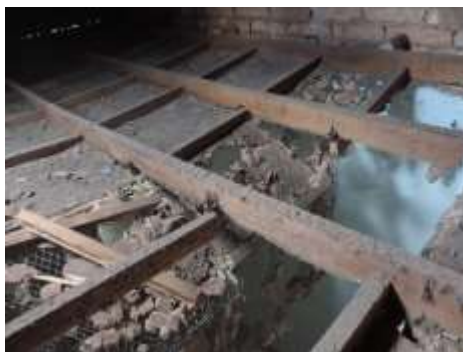
b) Início da retirada da argamassa e tela
