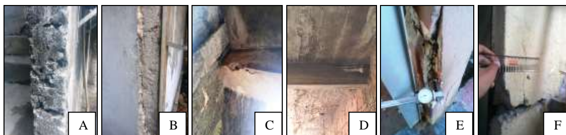
Figura 12: Carbonatação do concreto em elementos estruturais das edificações em análise: (A) Pilar externo da Edificação 1, (B) Pilar externo da Edificação 2, (C) Viga da garagem da Edificação 3, (D) Viga externa da Edificação 4, (E) Pilar externo da Edificação 5, (F) Pilar externo da Edificação 6
