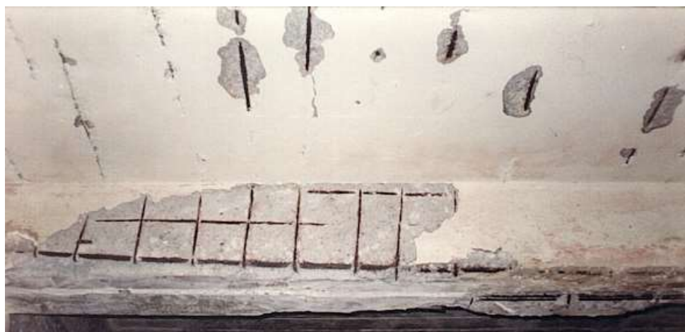
Figura 7: Lascamento do concreto devido à expansão dos produtos de corrosão nas armaduras da laje e viga
