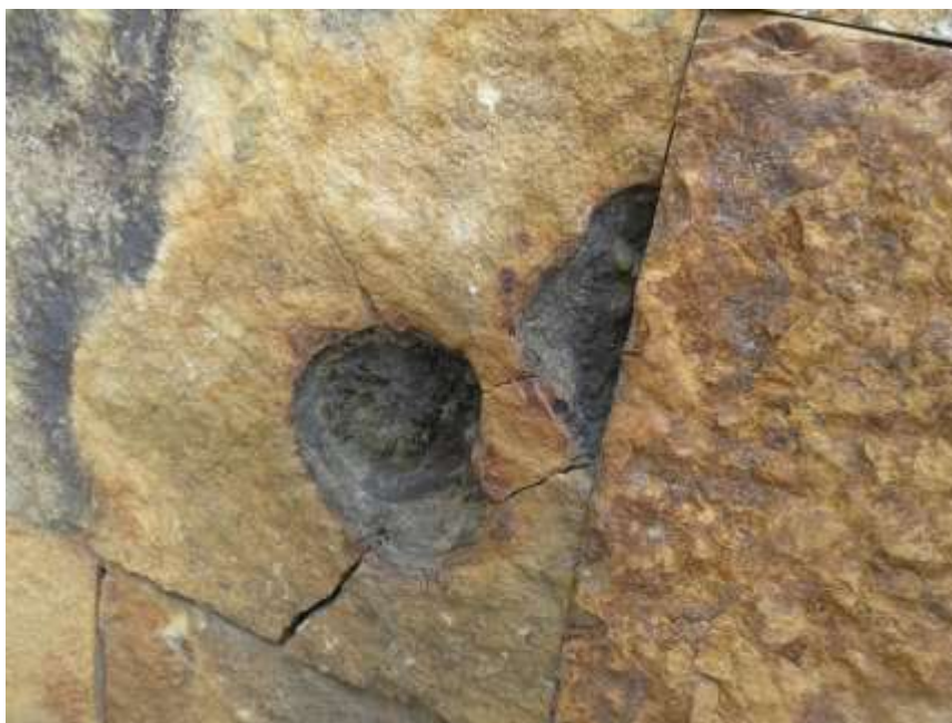
Figura 06: Trincamento e Fraturamento da pedra na fachada Fonte: Acervo dos autores
