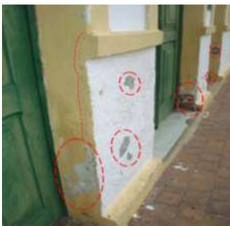
Figura 6: Fachada A – Trincas, fissuras e manifestações patológicas do revestimento.
