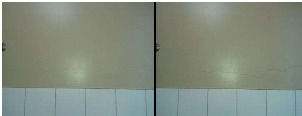
Figura 4: Fissura Bloco 1/Apt.21 – “Parede crítica 1”
