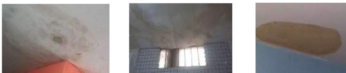
Figura 2 (a)- mancha d'água; Figura 2 (b)- bolsão de acúmulo de água e Figura 2 (c)- Destacamento de revestimento. a)
