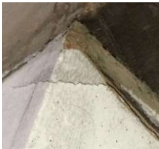
Figura 10 - Destacamento da camada de cobrimento em pilar do anexo B
