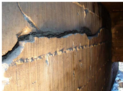
Figura 6: Trinca horizontal com grande abertura e deslocamento [20].
