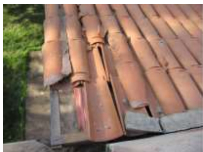
Figura 6: Detalhe da cobertura sobre o banheiro e a varanda em frente ao subsolo, com telhas quebradas [14].
