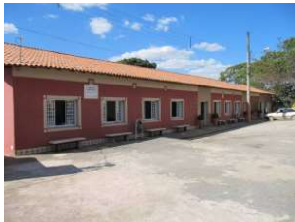
Figura 4: Vista da fachada frontal do Prédio da Antiga Prefeitura (BI-4) [14].
