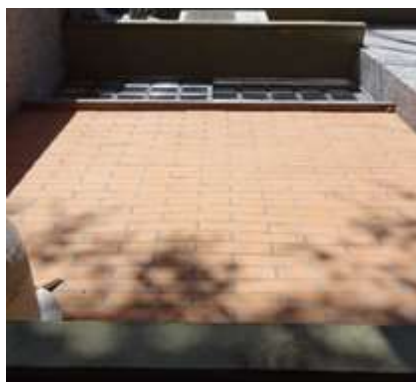
Figura 11: a) Imagens fotográficas de descolamento de plaquetas cerâmicas na fachada Nordeste e b) Imagens termográficas de descolamento de plaquetas cerâmicas na fachada Nordeste
