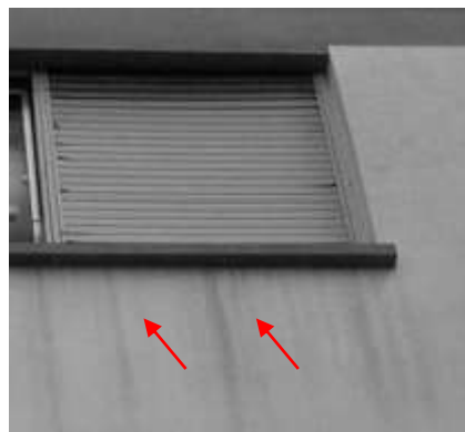
Figura 4: Caso de manchas sob a face inferior
