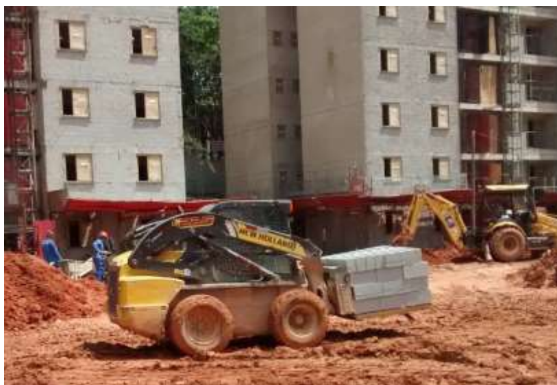
Figura 10 – Transporte dos blocos Obra B.
