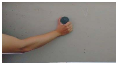
Figura 6: Passagem do disco de carborundum para remover imperfeições superficiais.
