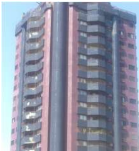
Figura 1: Intervenção na fachada leste do edifício Fontane Blue
