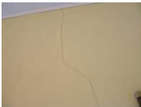
Figura 9: Detalhe de uma das trincas na parede, localizada na face interna da fachada frontal [14].
