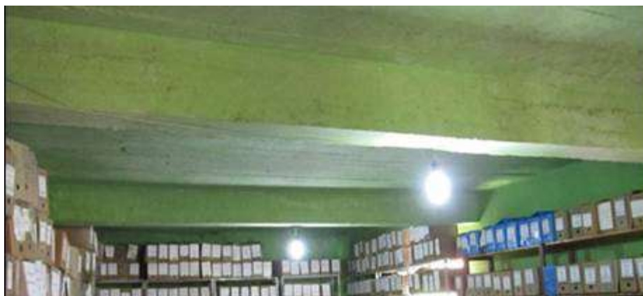
Figura 5: Vista interna do arquivo. Nota-se manchas na viga, devido à sujidades e infiltração [14].
