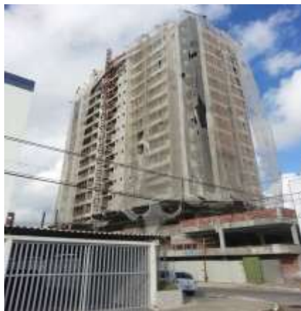
Figura 4: Obra Brisa Marina
