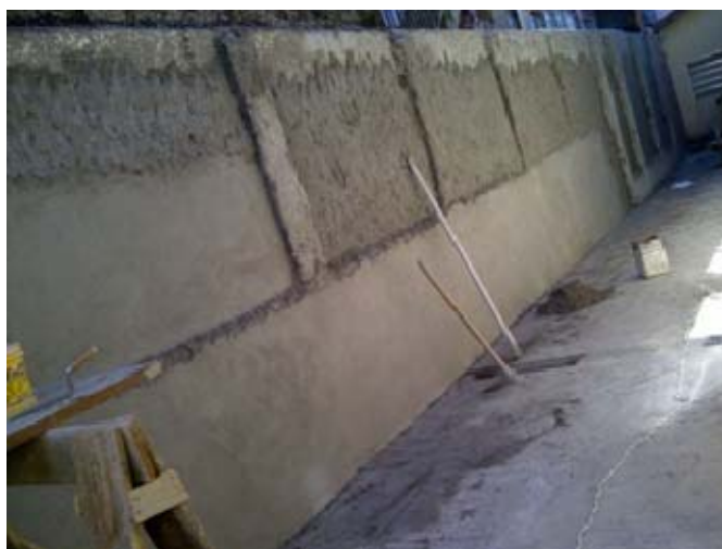
Figura 02: Alvenaria com camada única de revestimento
