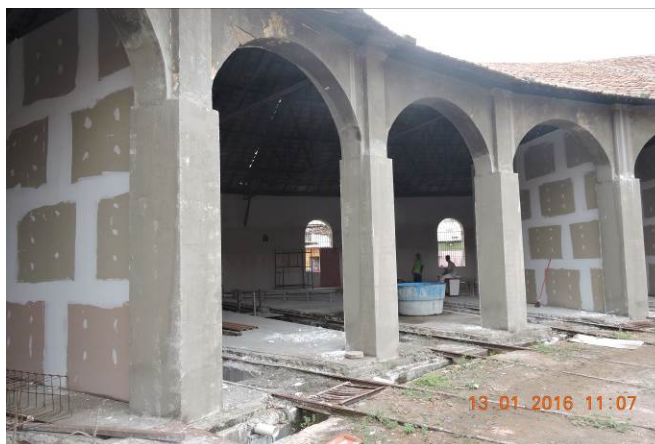
Figura 23: Aspecto atual das colunas das oficinas da rotunda.
