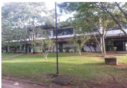
Figura 1: Face sul da edificação estudada (DECiv).
