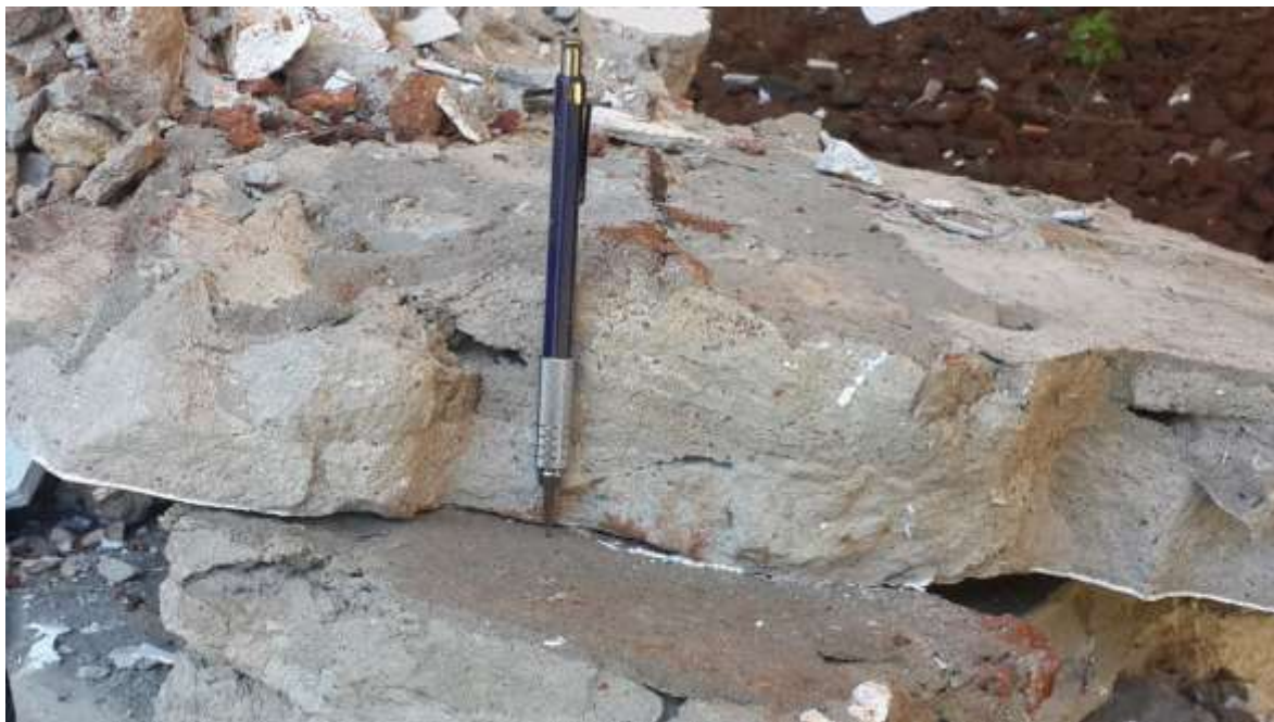
Figura 2a: Apresentação da espessura do reboco
