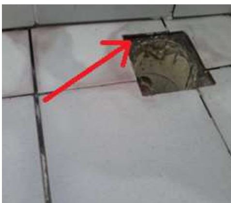
Figura 4: Infiltração decorrente da má execução do ralo e rejunte de piso
