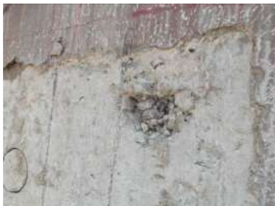
Figura 5: Ponto de concreto segregado visualizado após remoção parcial do revestimento
