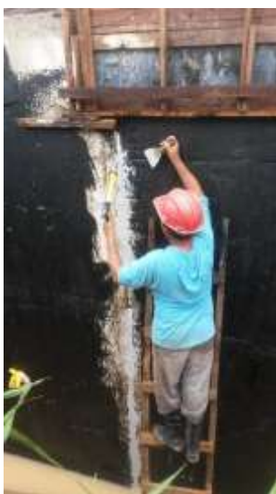
Figura 5: Preparação da junta de dilatação
