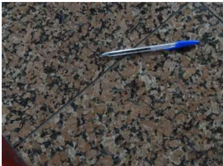
Figura 6 - Trincas e fissuras no piso de granito do hall de elevador na garagem.
