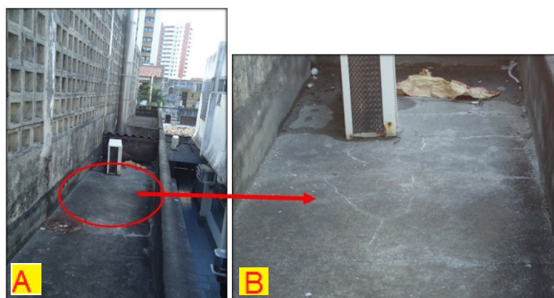
Figura 5: Fissuras na laje
