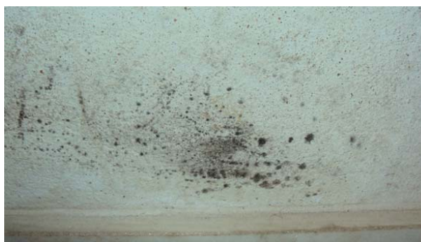
Figura 7. Mofo na parte inferior da parede
