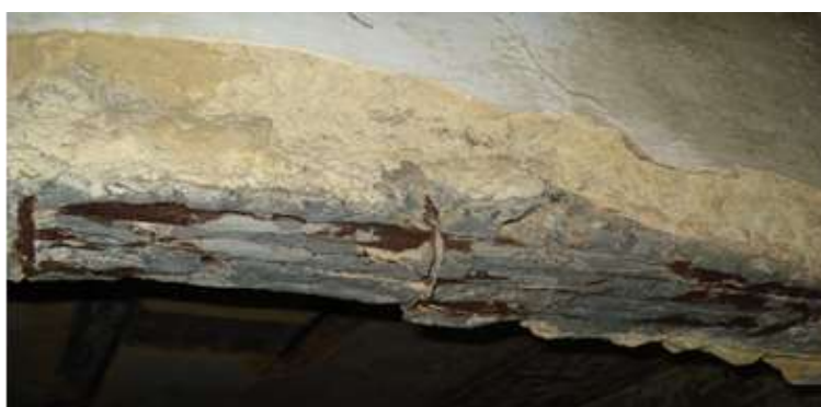
Figura 10: Viga com elevado grau de corrosão
