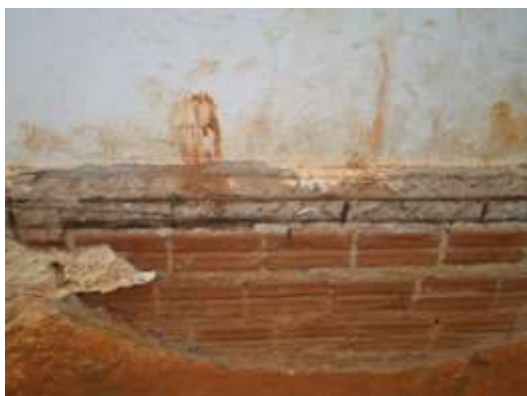
Figura 10: Corrosão da armadura na escola 1.
