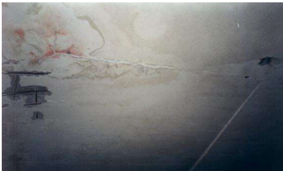
Figura 1: Lixiviação em laje de concreto armado
