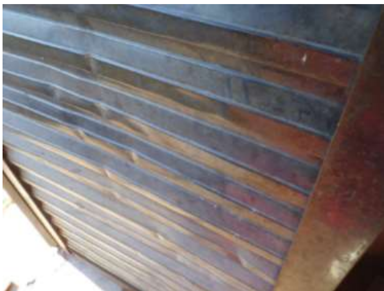
Figura 6: Porta de entrada amassada excessivamente Fonte: Acervo fotográfico dos autores (2012)
