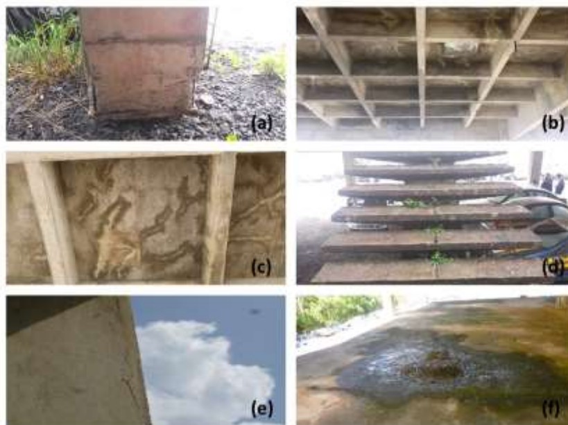
Figura 3: Manifestações patológicas - (a) Corrosão da armadura com deslocamento de concreto; (b) Manchas de umidade; (c) Infiltrações; (d) Vegetação incrustada; (e) Fissuração; (f) Concentração de umidade
