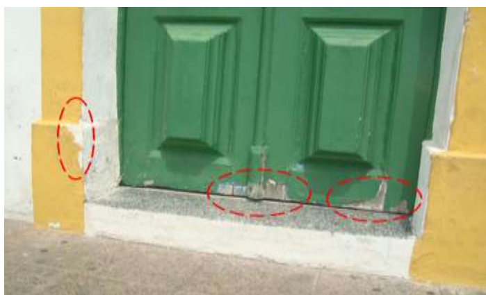
Figura 14: Fachada A - Manifestações patológicas do revestimento e outras.
