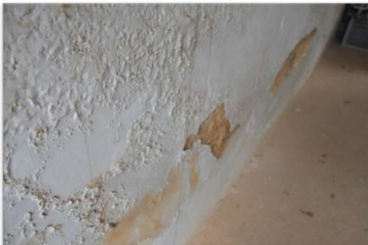
Figura 7: Vesícula e descolamento com pulverulência encontrados na garagem da Casa “G”.
