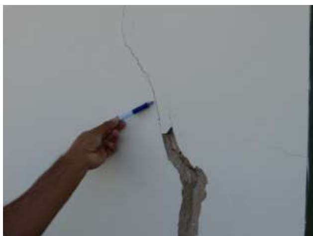
Figura 4: Fissura da vedação vertical (parte interna)
