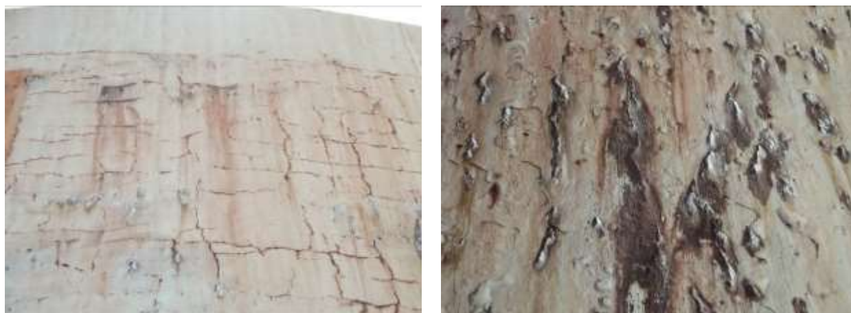
Figura 2: Detalhes da fissuração na parede do reservatório. Nota-se ainda a presença de falhas na estanqueidade e a deterioração da pintura
