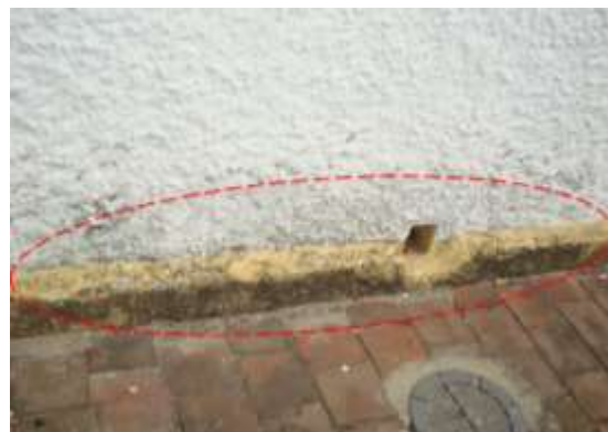
Figura 9: Fachada D – Manifestações patológicas no revestimento e Umidade.
