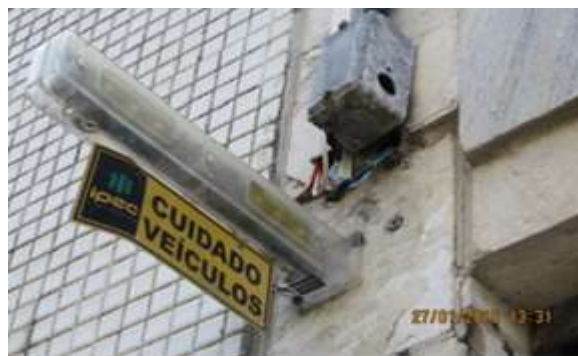
Figura 7: Instalações elétricas expostas.
