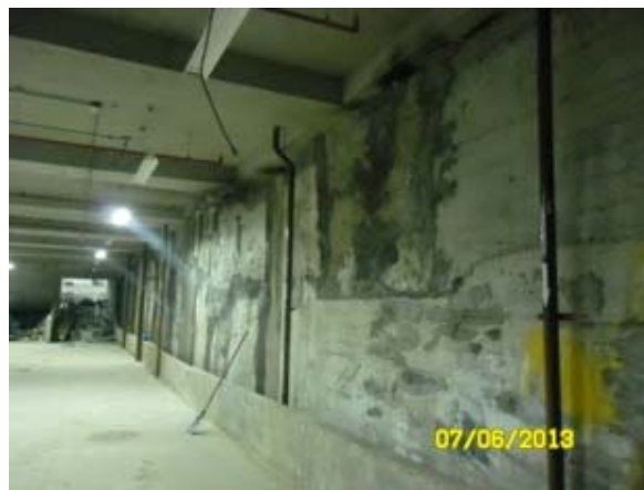
Figura 25 – Tratamento executado nas juntas entre as lamelas com as argamassas de cristalização integral.
