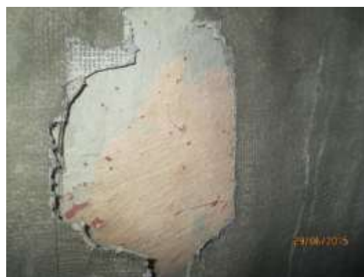
Figura 5: Degradação generalizada do sistema de impermeabilização, observada no interior de todas as células do reservatório.
