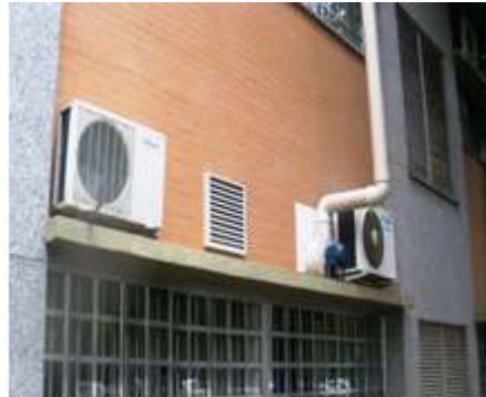
Figura 15: Eflorescência na fachada Nordeste
