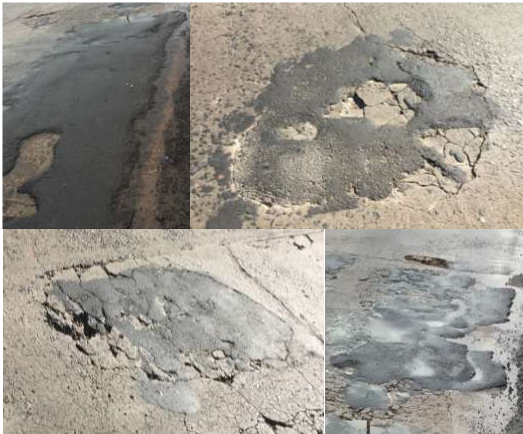
Figura 5: Remendos mal executados na via.
