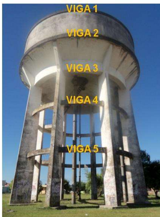
Figura 3: Localização das vigas no reservatório (AUTORA)
