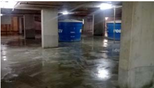
Figura 26 – Vista geral do subsolo com infiltração.
