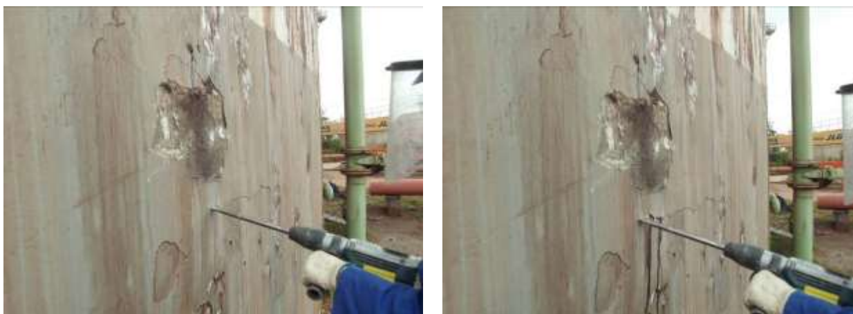
Figura 7: Detalhe da parede imediatamente antes (a) e após o início da perfuração (b), momento em que se observa a percolação de água retida entre o revestimento e a estrutura
