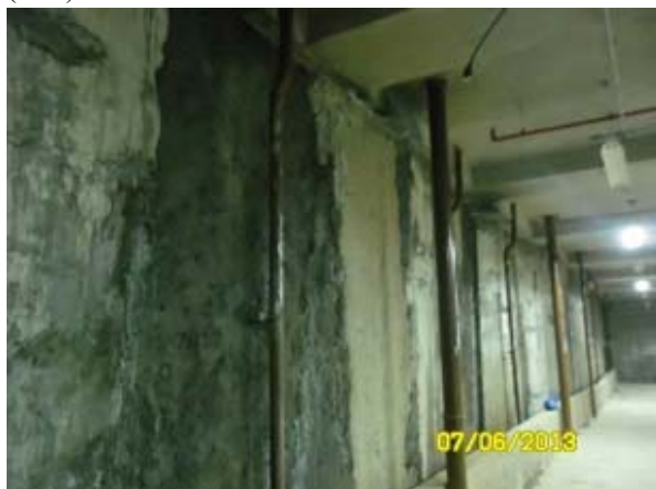
Figura 24 – Tratamento executado nas juntas entre as lamelas com as argamassas de cristalização integral.
