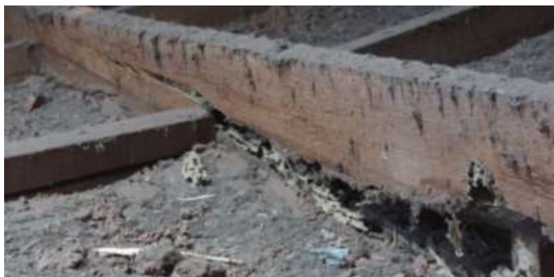
Figura 12: Ruptura por cisalhamento durante demolição com aplicação de carga vertical crescente.
