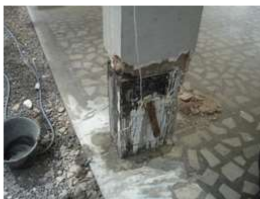
Figura 13: Recomposição com graute auto-adensável. (Fonte: Reitec)
