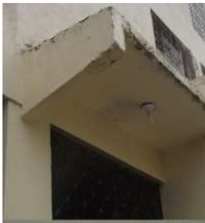
Figura 5: Desagregação da pintura Fonte: Acervo pessoal (2015).
