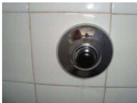
Figura 2: Válvula de descarga com vazamentos no AT4
