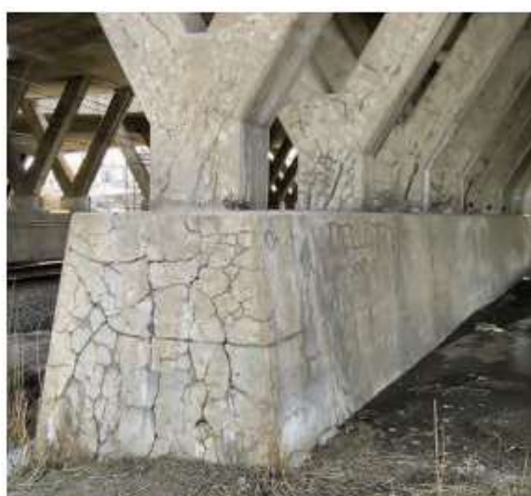
Figura 12a - Reação álcali-silica em um bloco de pilar [5]
