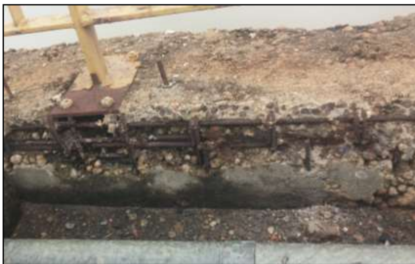
Figura 13: Vazios de concretagem
