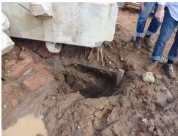
Figura 20: Pilar P1 desprendido do cálice
