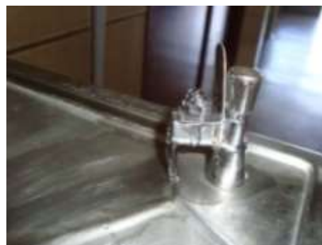
Figura 8: escoamento de água constante em bebedouro, quando não acionado
