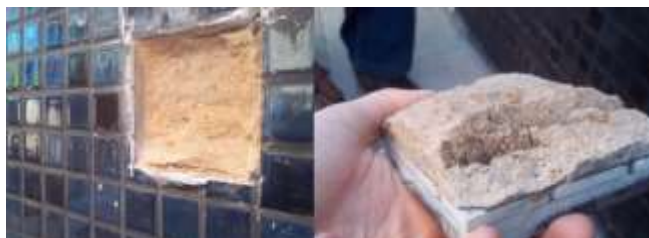
Figura 4: Argamassa de substrato de aderência
