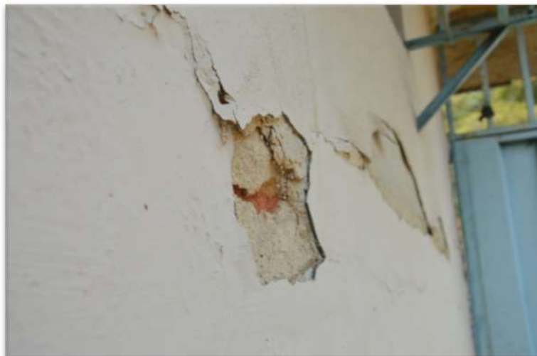
Figura 11: Descolamento com pulverulência encontrado na fachada da Casa “J” (tijolo à mostra).
