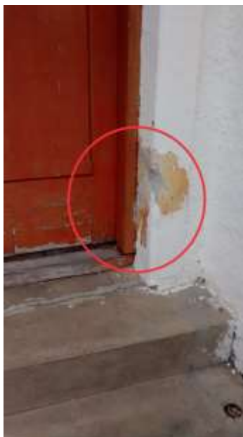
Figura 8: Descolamento de revestimento pontual na porta da cozinha
