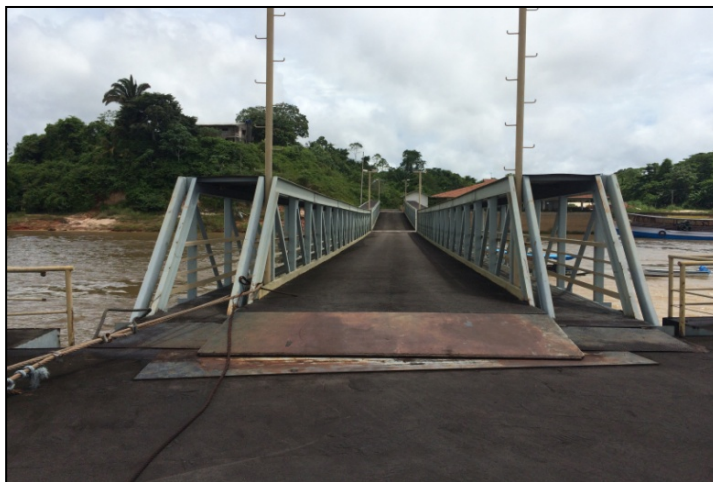
Figura 7: Ponte de acesso desalinhada, em função da torção causada por falhas no sistema de fundeio. Fonte: DNIT (2015)
