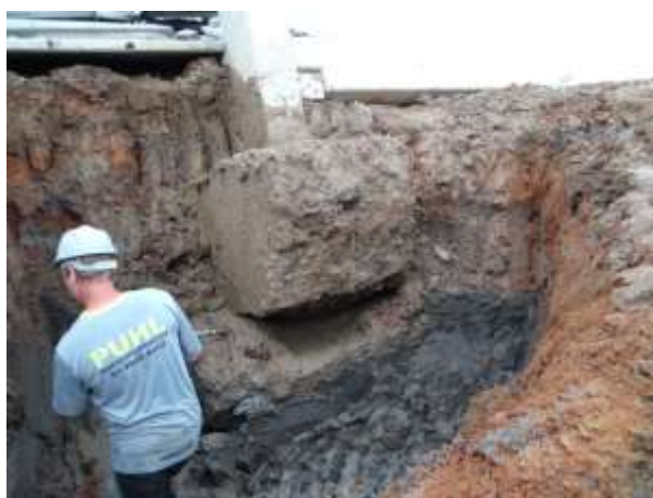
Figura 22: Vista do colarinho do pilar P23 solto e rotacionado após o colapso.
