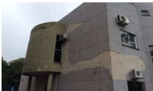
Figura 4:44 Deslocamento do Revestimento de Fulget
