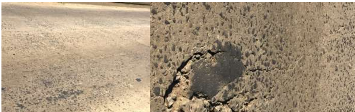
Figura 10: a) Desgaste do pavimento. b) fissuras no pavimento.
