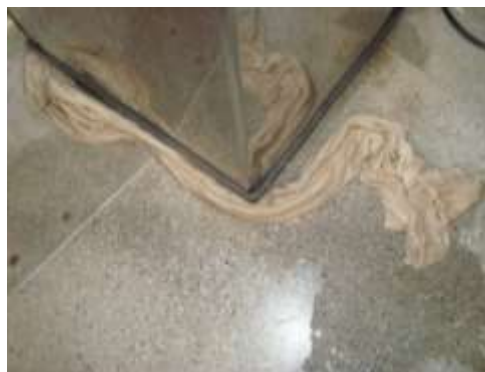
Figura 13: Vazamento no bebedouro do AT9
