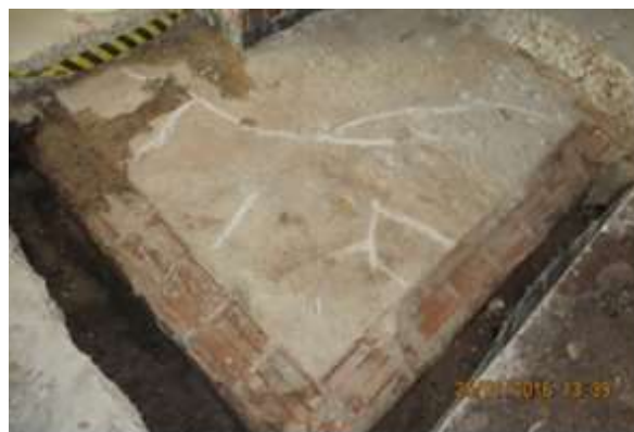
Figura 2: Fissuração com características expansivas.
