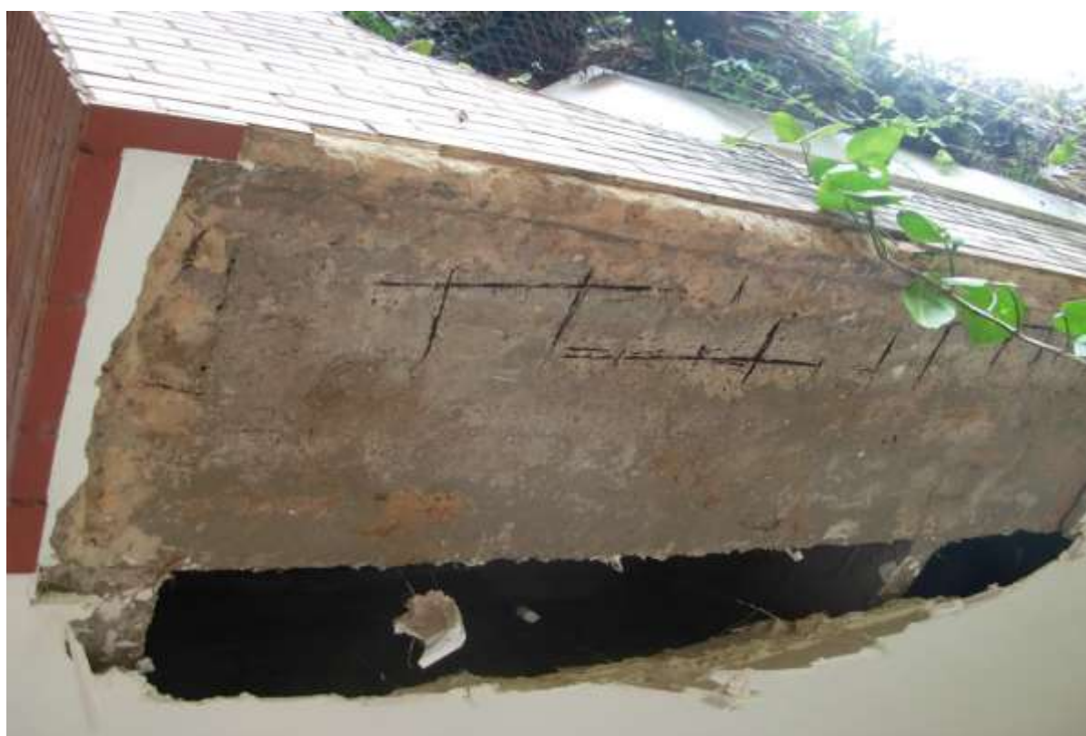
Figura 3b: Armaduras de aço corroídas
