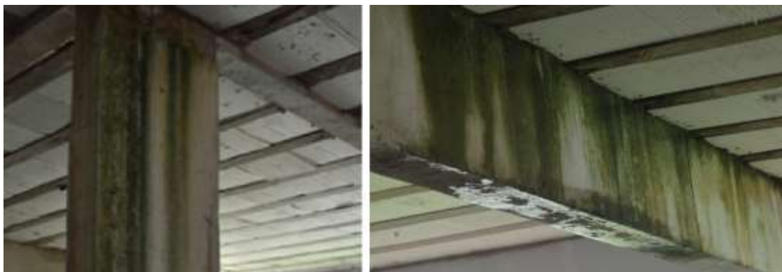
Figura 13 – Manchas de musgos causadas pela percolação de água em (a) pilar e (b) viga no anexo B
