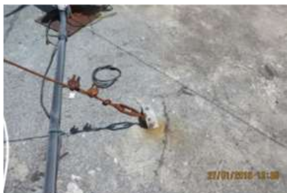
Figura 17: Perfuração do sistema impermeabilizante para colocação da antena.
