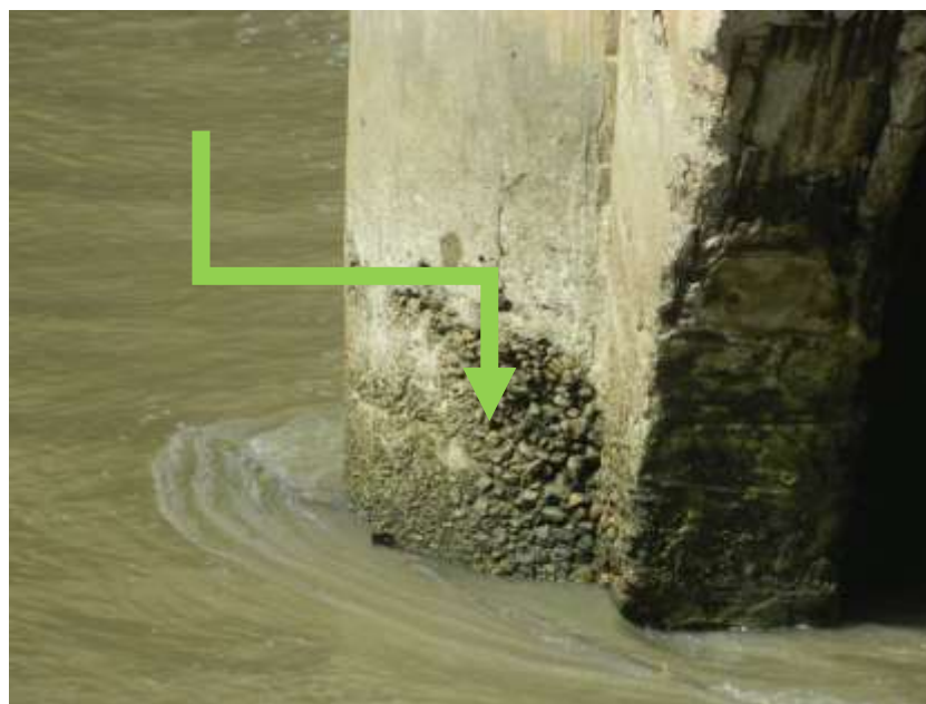
Figura 8: Detalhamento da desagregação de concreto
