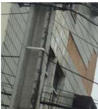
Figura 4: Destacamento do revestimento cerâmico Fonte: Acervo pessoal (2015).
