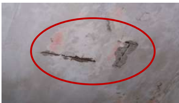
Figura 2: Corrosão de armadura com presença de deslocamento
