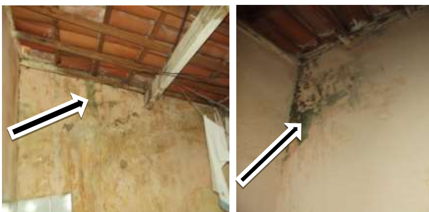
Figura 13: Mofo em parede interna
