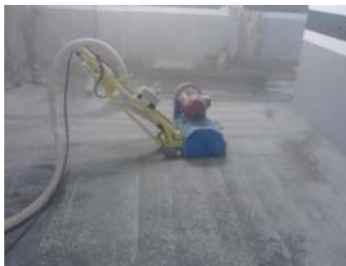
Figura 2 – Fresamento mecânico para remoção de milímetros de concreto deteriorado
