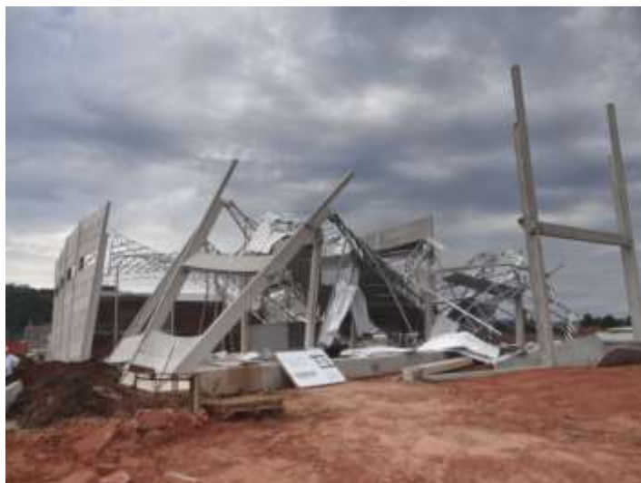
Figura 18: Vista da obra após o colapso
