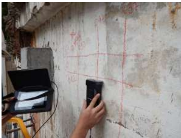
Figura 9 - Realização dos ensaios de pacometria com demarcação das armaduras para posterior ensaio de potencial de corrosão.
