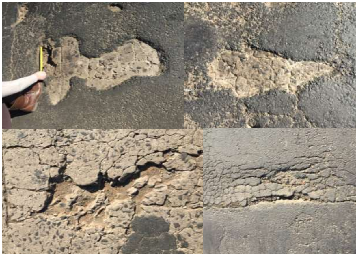
Figura 4: Painelas e afundamentos presentes na rodovia.
