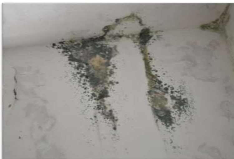
Figura 2: Bolor e descolamento com empolamento encontrado no banheiro da Casa “G”.
