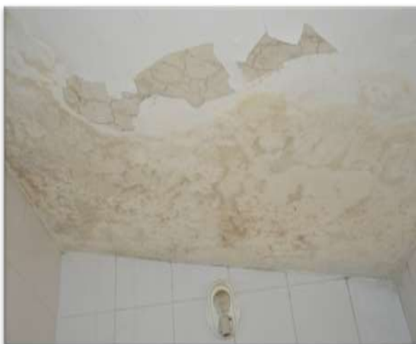
Figura 6: Fissuras mapeadas e descolamento com empolamento encontrada no banheiro da Casa “G”.
