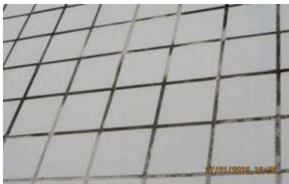
Figura 20: Manchas de bolor na fachada.
