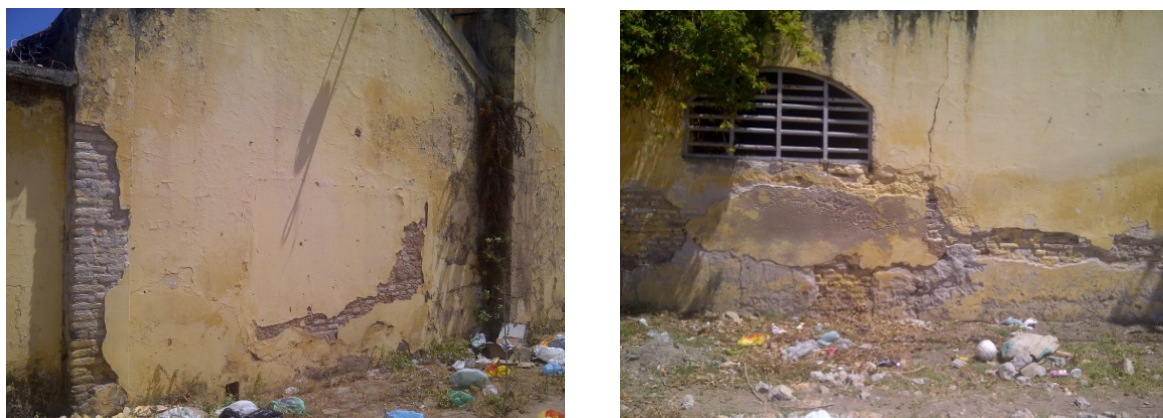
Figura 20: Registro da ocorrência de desgaste de rejuntamento.
