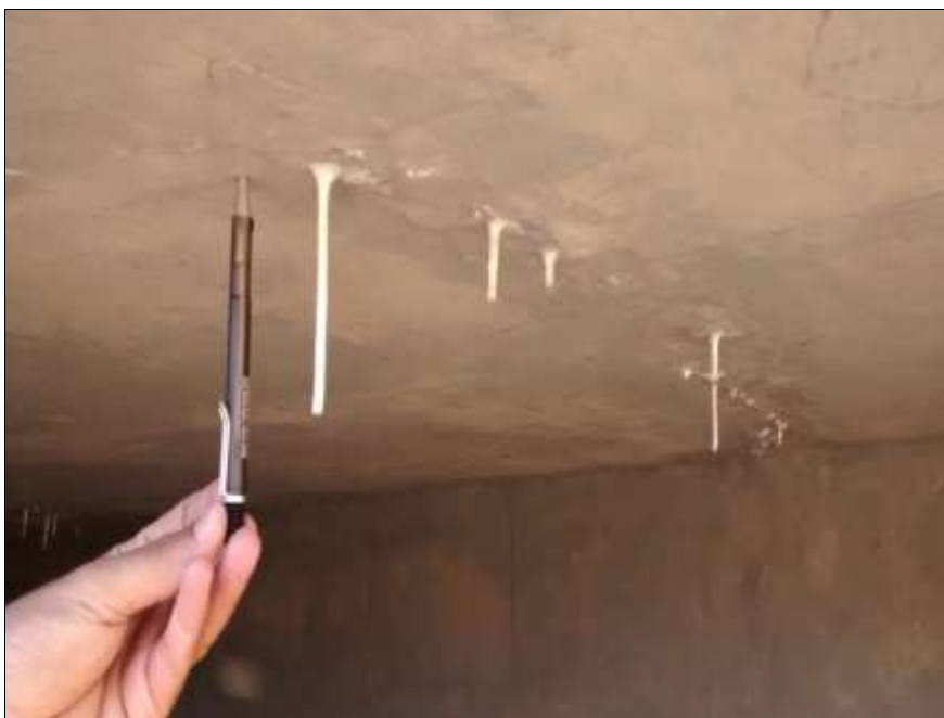
Figura 4: Estalactite formada por lixiviação de sal de hidratação do concreto endurecido em laje de fundo do decantador. (Fonte: Autor, 2015)
