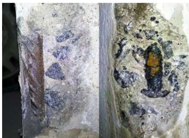
Figura 17: Corrosão por cloretos livres, precipitados brancos.
