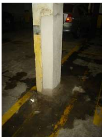
Figura 8: Pilotis, local úmido e com baixa ventilação. (Fonte: Prezi)
