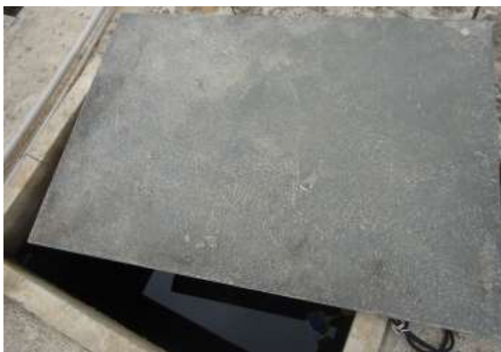
Figura 16. Tampa de ardósia dos reservatórios da Edificação C.
