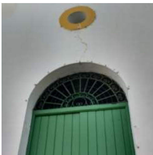
Figura 5: Fissura na fachada lateral.
