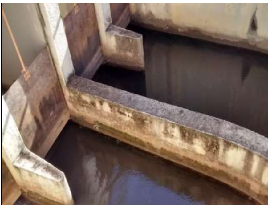
Figura 2: Gradeamento da estação com sinais de abrasão em canal. . (Fonte: Autor, 2015)
