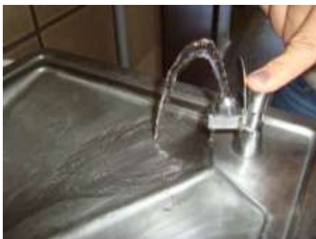
Figura 9: Baixa vazão de água em bebedouro, quando acionado
