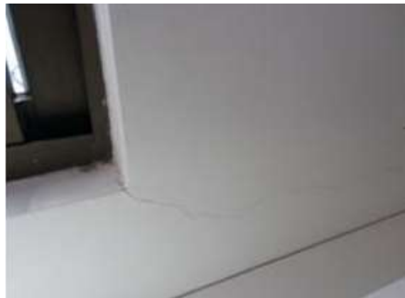
Figura 27: Fissura próxima à janela.
