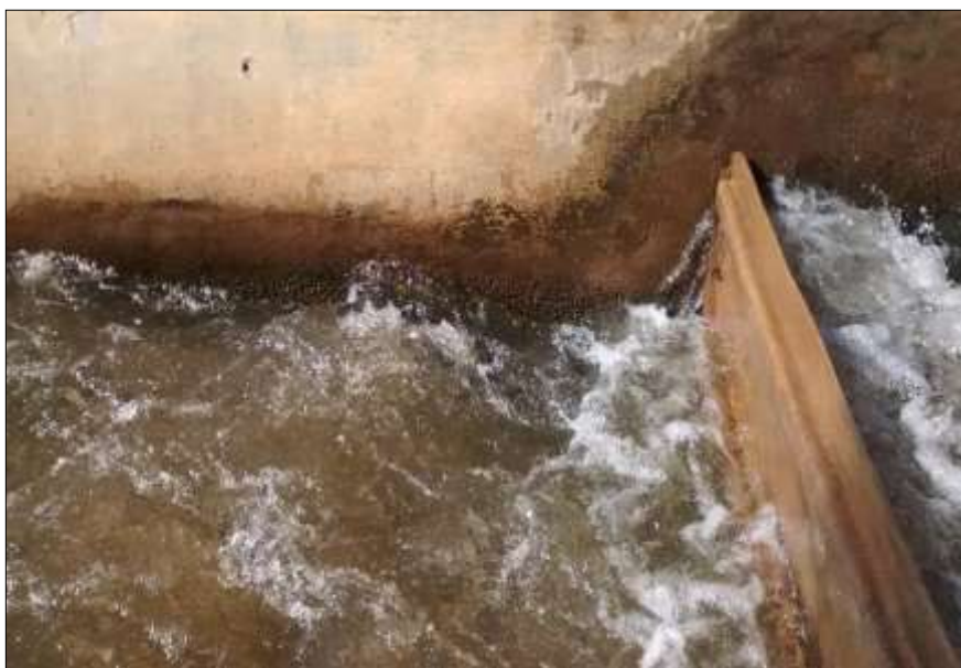
Figura 3: Canal de lançamento e mistura de produto químico coagulante. (Fonte: Autor, 2015)
