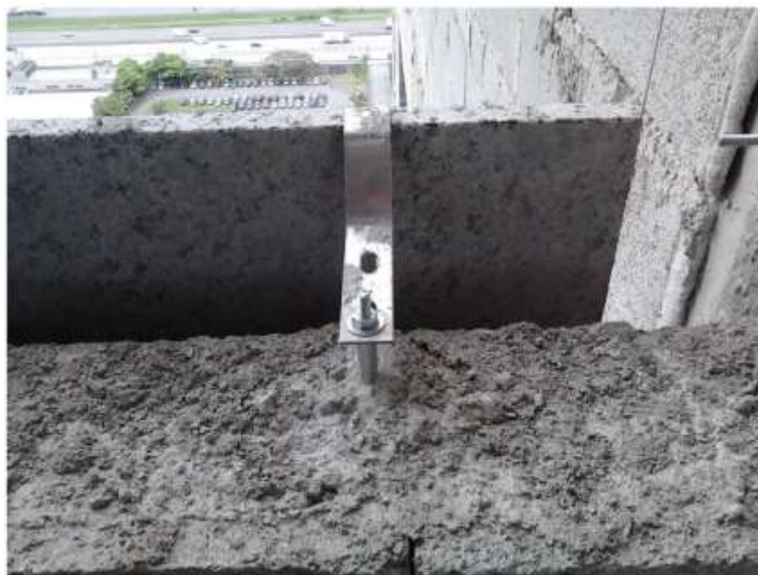
Figura 03: Fixação mecânica do revestimento em pedra natural Fonte: [6]
