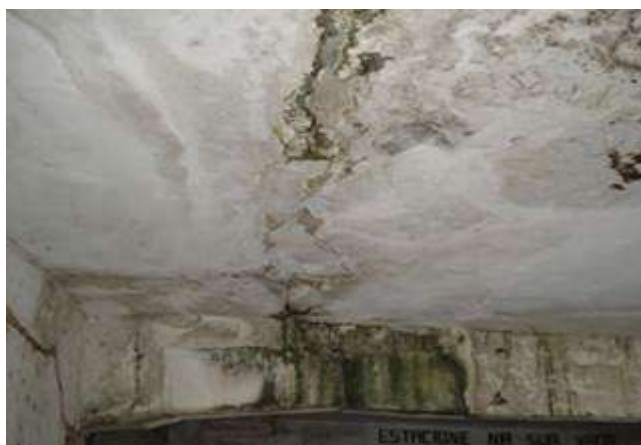
Figura 6: Presença de lodo e manchas de umidade.
