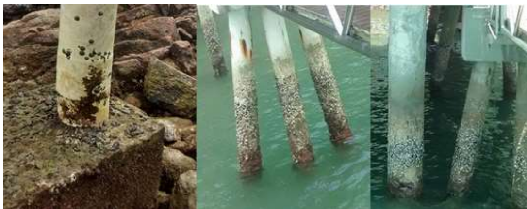
Figura 7 – crustáceos nos elementos estruturais do Píer A, B e C, respectivamente.
