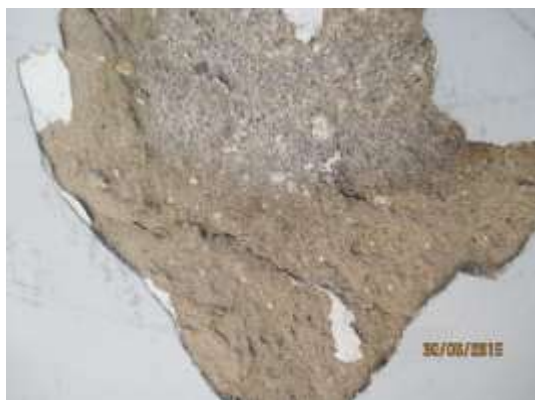
Figura 2: Degradação generalizada da pintura e do revestimento de argamassa (reboco) externo, com som cavo, detectado pelo teste de percussão, e fissuras em diversos pontos do reservatório.
