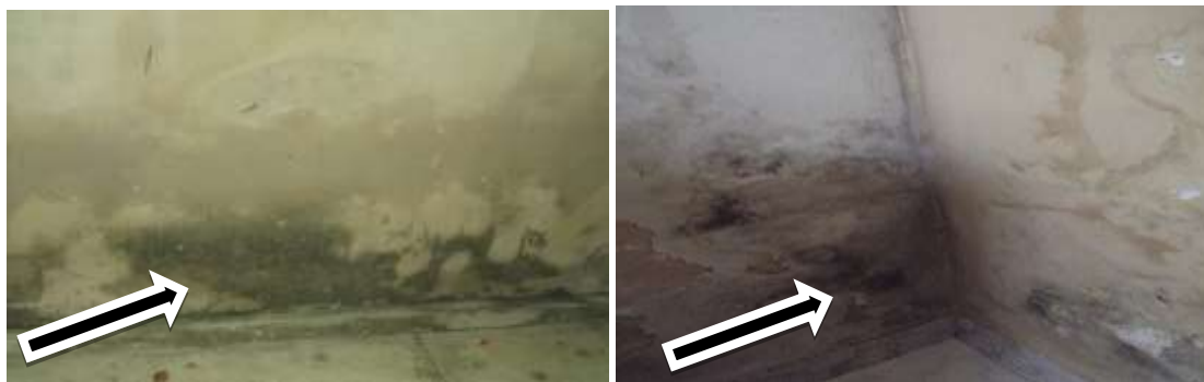
Figura 11: Mofo causado devido à umidade por capilaridade
