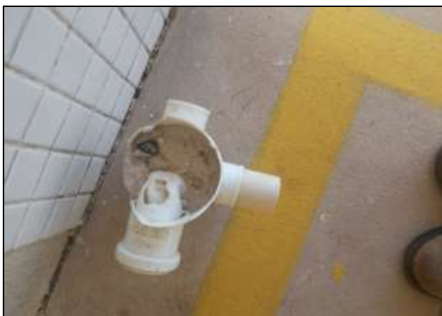
Figura 5 – Caixa sifonada obstruída.
