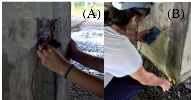
Figuras 4: Contato com a armadura (A); Utilização do eletrodo e do multímetro (B)
