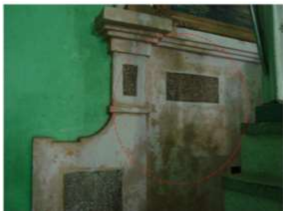
Figura 10: Área interna - Manifestações patológicas do revestimento.
