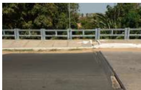
Figura 8: Desnível na área de tráfego
