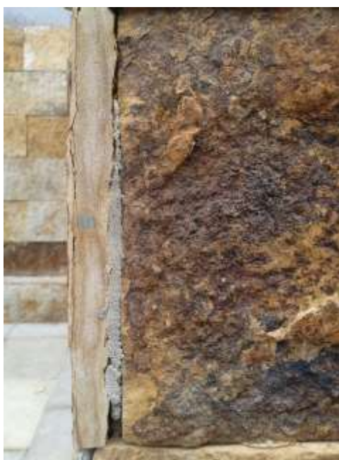
Figura 02: Fixação por colagem do revestimento em pedra natural
