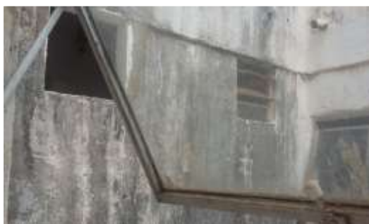
Figura 5 (a) e Figura 5 (b)- Bolores e Eflorescências.
