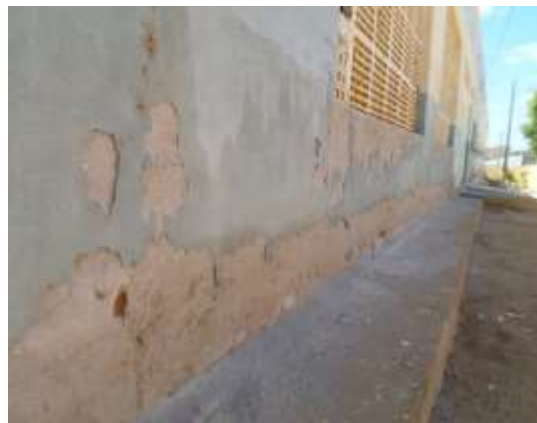
Figura 5: Degradação do reboco na escola 2.
