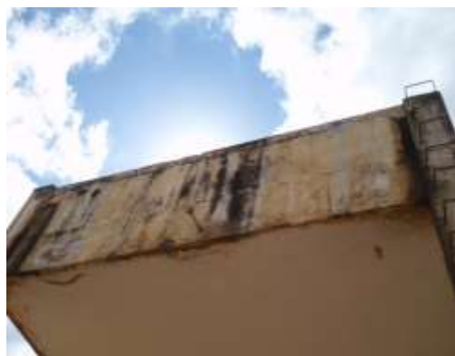
Figura 1: Manchas de umidade no reservatório superior da escola 1.
