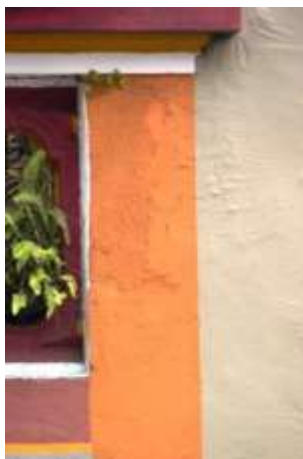
Figura 48: Detalhe do muro com perda de parte do revestimento sob a camada pictórica e aparecimento de microflora. Fonte: acervo pessoal, 2015.
