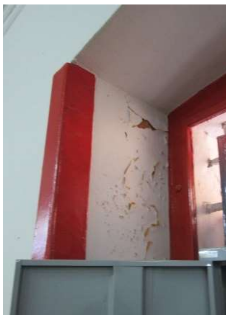
Figura 35: Descamação da pintura
