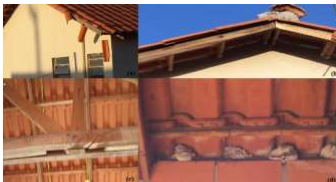
Figura 7 – Irregularidades em telhado: (a) Fiada de borda solta, sem amarração (b) Cumeeira não aderida a massa. (c) Fendas no madeiramento do telhado. (d) Fechamento entre alvenaria e telhamento de maneira incorreta, com excesso de massa
