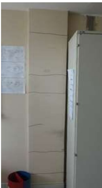
b) Fissuras de Retração
