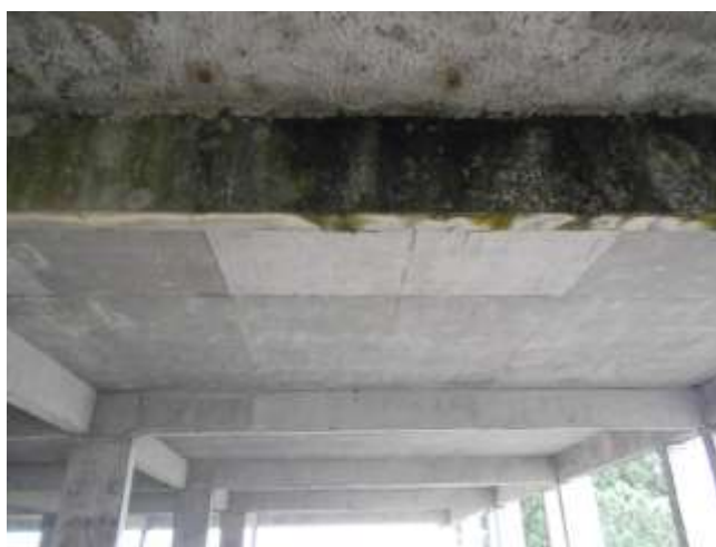
Figura 72: Presença de matéria orgânica em viga do 2º pavimento
