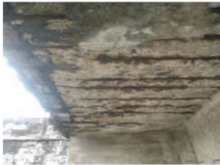
Figura 1: Corrosão em estrutura de concreto armado.
