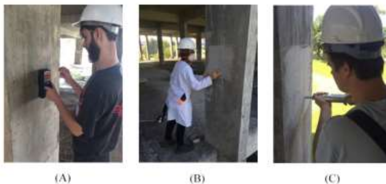
Figura 65: Execução do ensaio de esclerometria: (A) Localização de armaduras, (B) Uniformização da superfície com pedra abrasiva, (C) Uso do esclerômetro.
