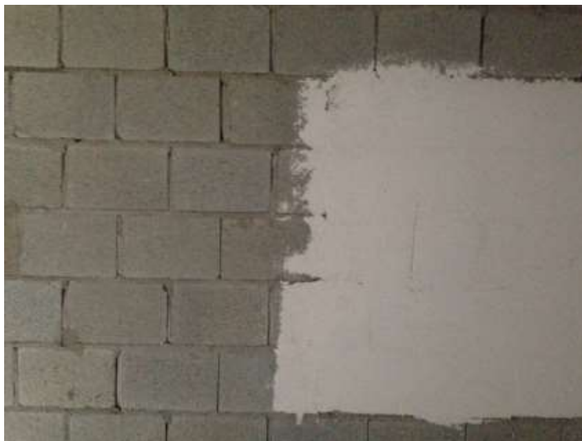
Figura 17 – Alvenaria executada na Obra B.
