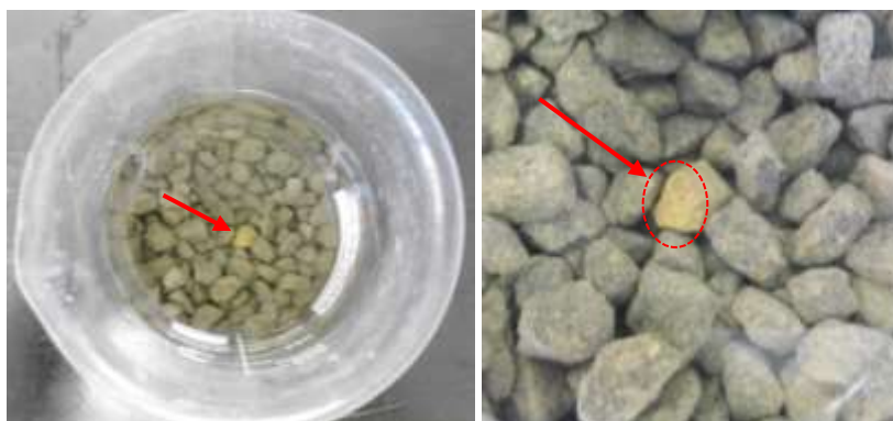
Figura 5 – Agregado em processo inicial de oxidação
