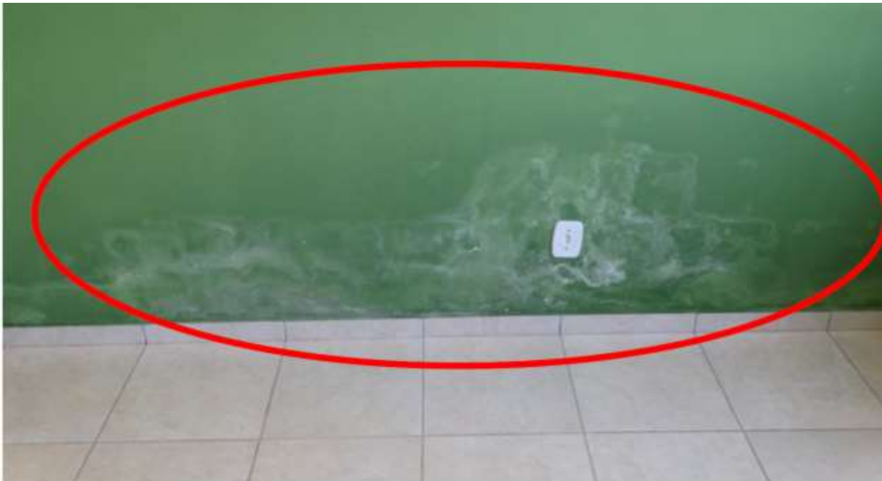
Figura 6: Infiltrações na parede
