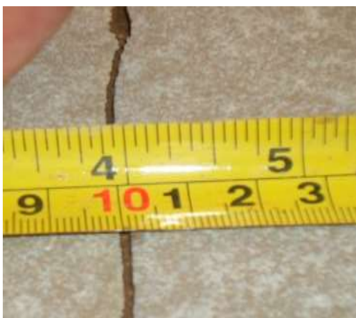
Figura 8: Trincas no piso na escola 1.
