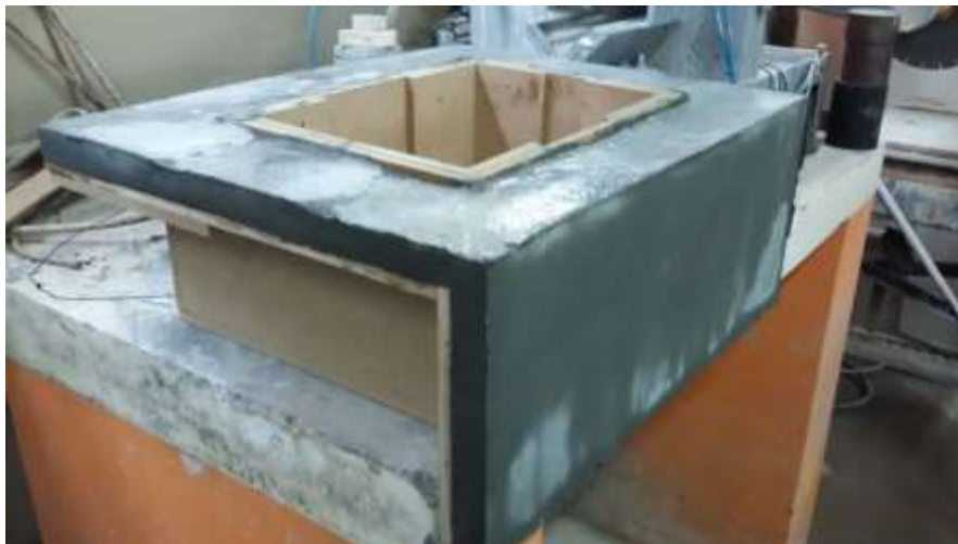
Figura 5: Processo de desformagem da cuba.
