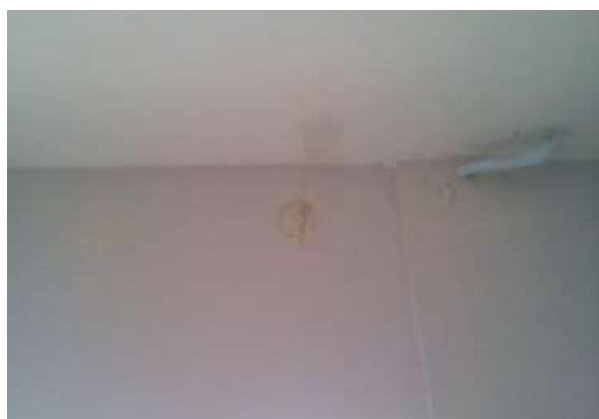
Figura 5: Manchas oriundas de infiltração observadas na sala de administração da biblioteca
