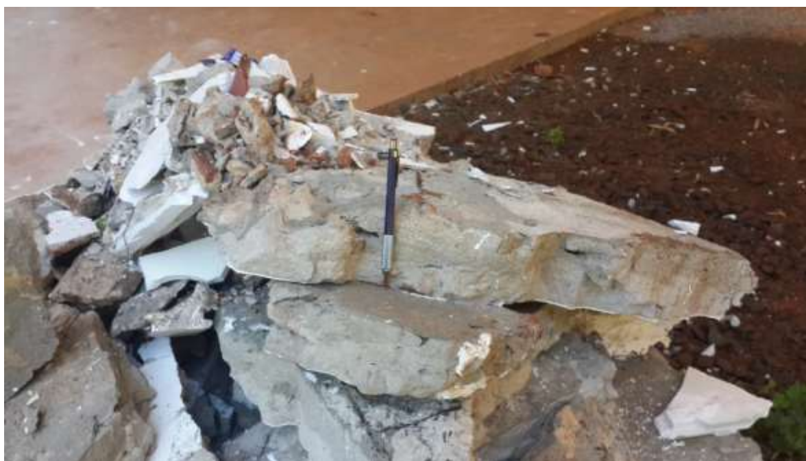
Figura 2b: Apresentação da espessura do reboco
