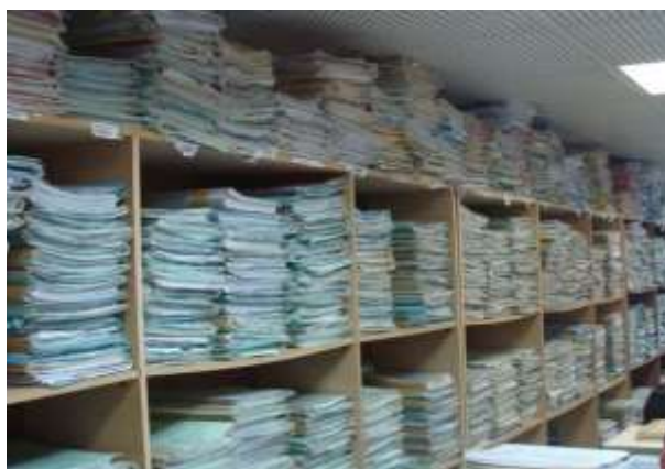
Figura 19 – Arquivos de papel sobre as lajes do edifício
