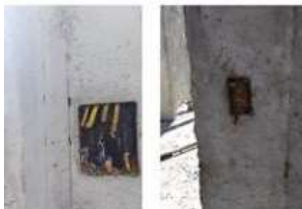
Figura 9: Manifestação patológica (8): quadros de distribuição e caixas de transmissão tortas
