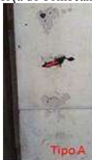
Figura 3: Manifestação patológica (1): falha de concretagem Tipo A
