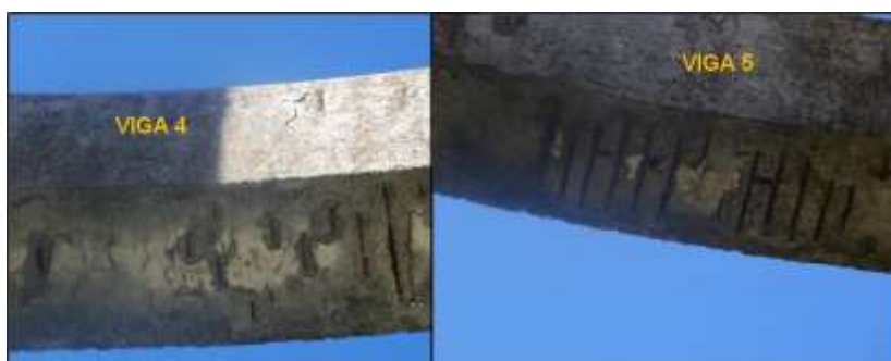
Figura 5: Manifestações patológicas nas vigas inferiores (AUTORA)
