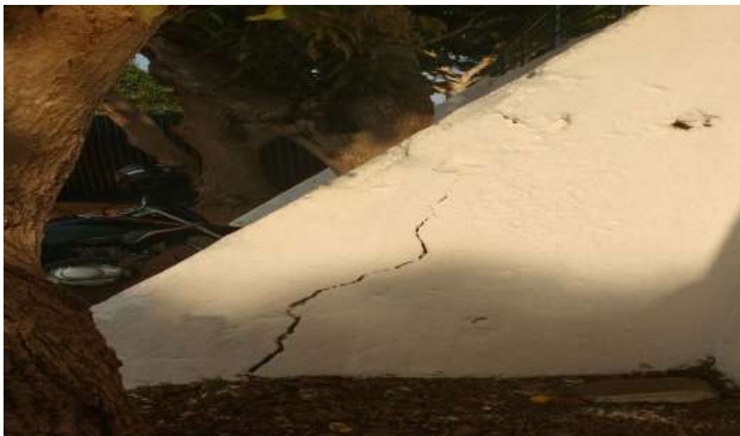
Figura 6: Fissura na estrutura de sustentação da arquibancada
