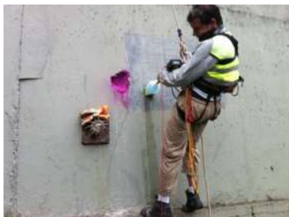
Figura 7 - Realização de ensaios de potencial de corrosão em cortina atirantada
