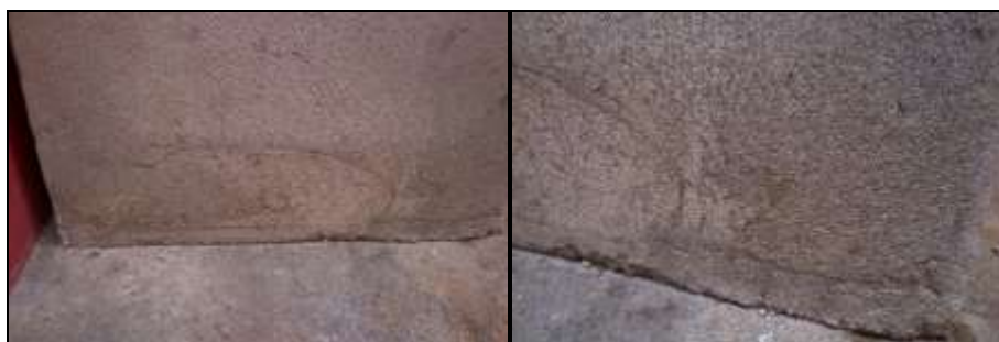
Figura 25: Faixa de bolor junto à base do modelo
