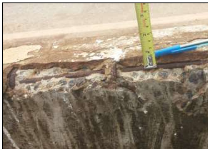
Figura 12: Espaçamentos insuficientes
