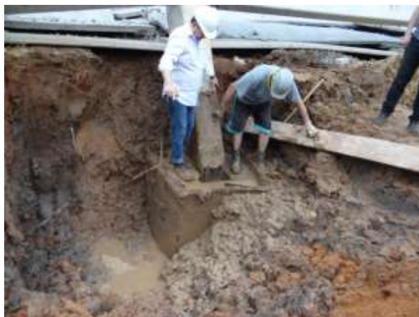
Figura 21: Vista do pilar P22
