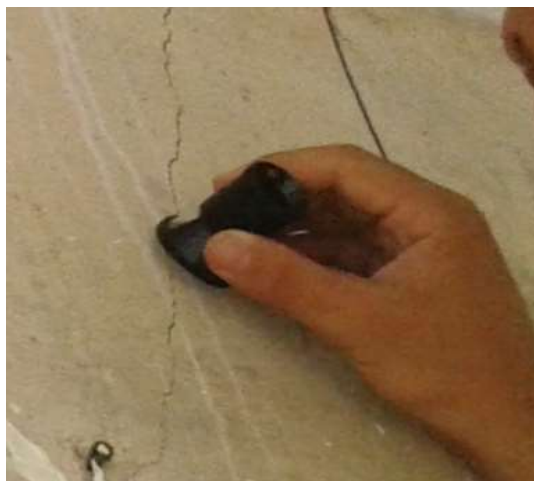
Figura 7: Acompanhamento de fissuras com fissurômetro
