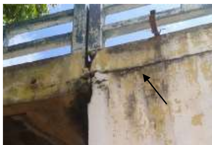
Figura 3: Trincas na zona de encontro
