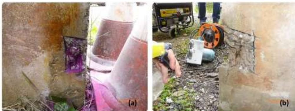
Figura 7: Resultados do ensaio de carbonatação - (a) Pilar 16; (b) Pilar 7.
