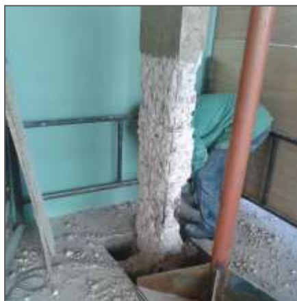
Figura 3: Procedimento de retirada de cobrimento de armaduras.
