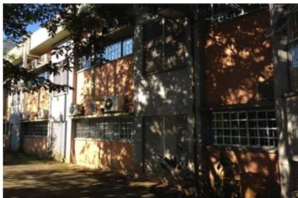
Figura 1: Foto da fachada principal e do acesso principal
