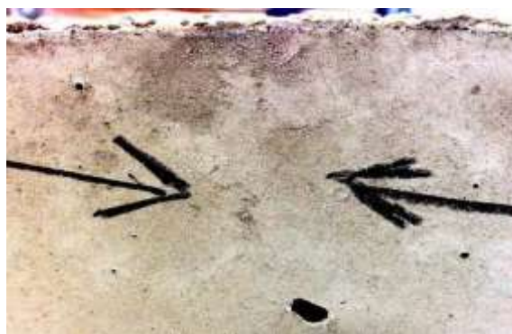
Figura 4: Presença da primeira fissura na amostra CR 03 do concreto referencial
