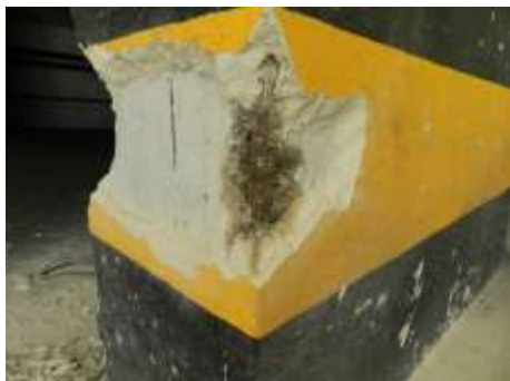
Figura 1 – Ensaio de presença de cloretos no Pilar 1 (reforçado)
